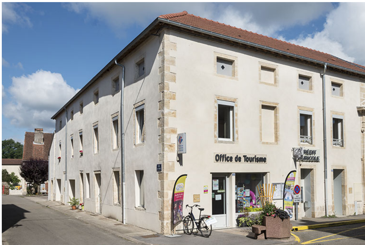
Élévation extérieure sur la rue Armand Paulmard et la rue des Forges. 70, Scey-sur-Saône-et-Saint-Albin, 24-26-30-32 rue Armand Paulmard
