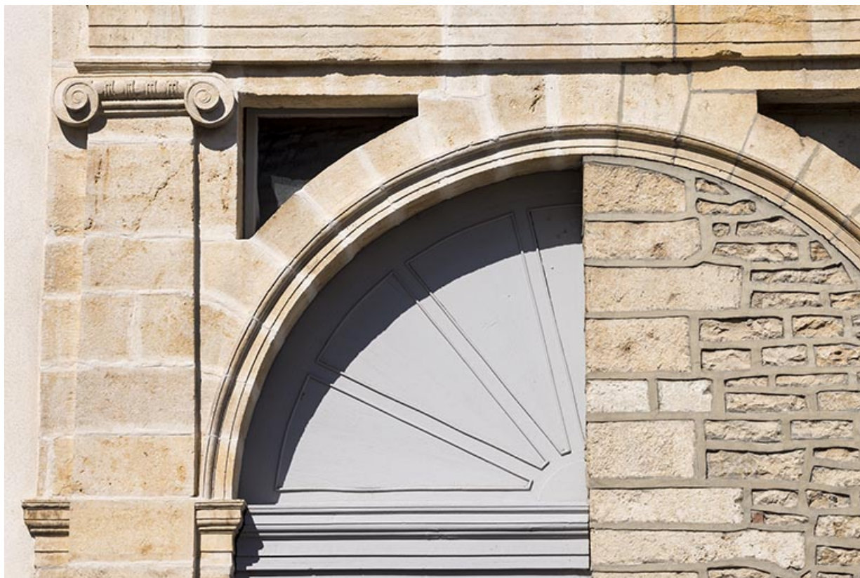
Ancien portail d'entrée, rue Armand Paulmard, détail.
