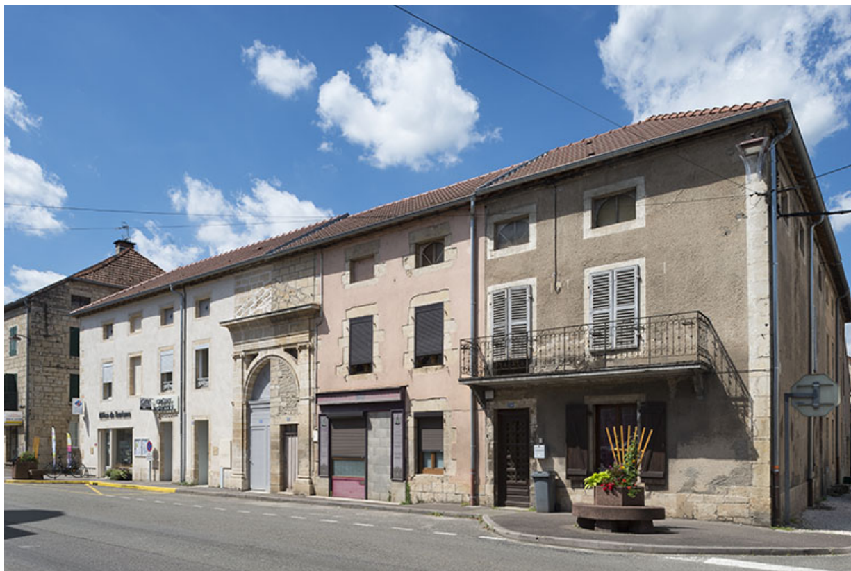
Élévation extérieure sur la rue Armand Paulmard et la rue des Fours. 70, Scey-sur-Saône-et-Saint-Albin, 24-26-30-32 rue Armand Paulmard
