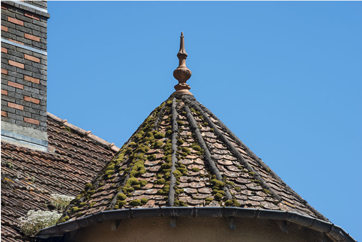
Toit conique nervuré de la tour demi-hors-œuvre.
