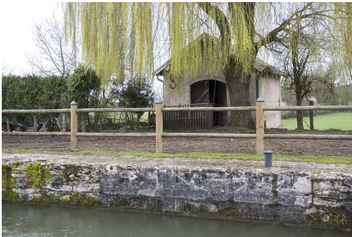
La remise portant la date de 1878.
