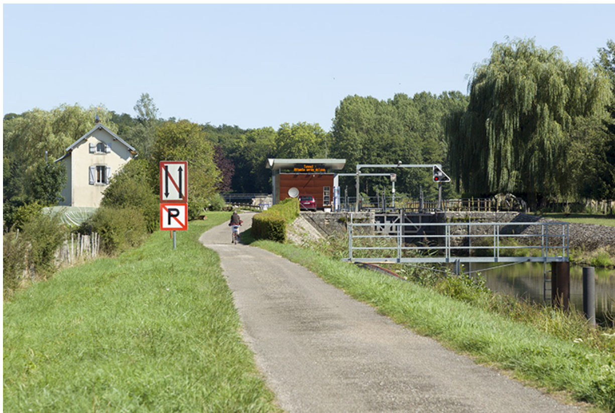
Le chemin de halage, actuellement utilisé en voie verte. 70, Rupt-sur-Saône
