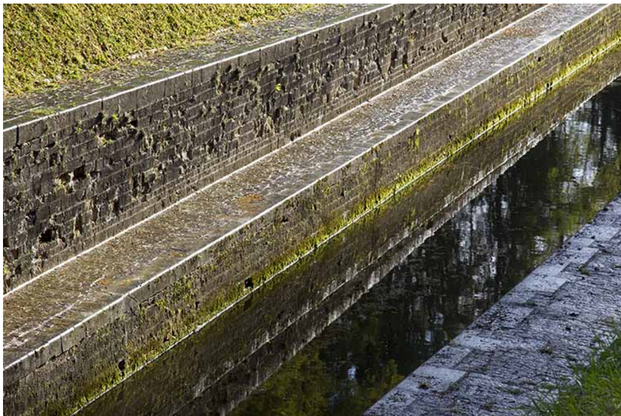
Vue sur la maçonnerie du canal.
