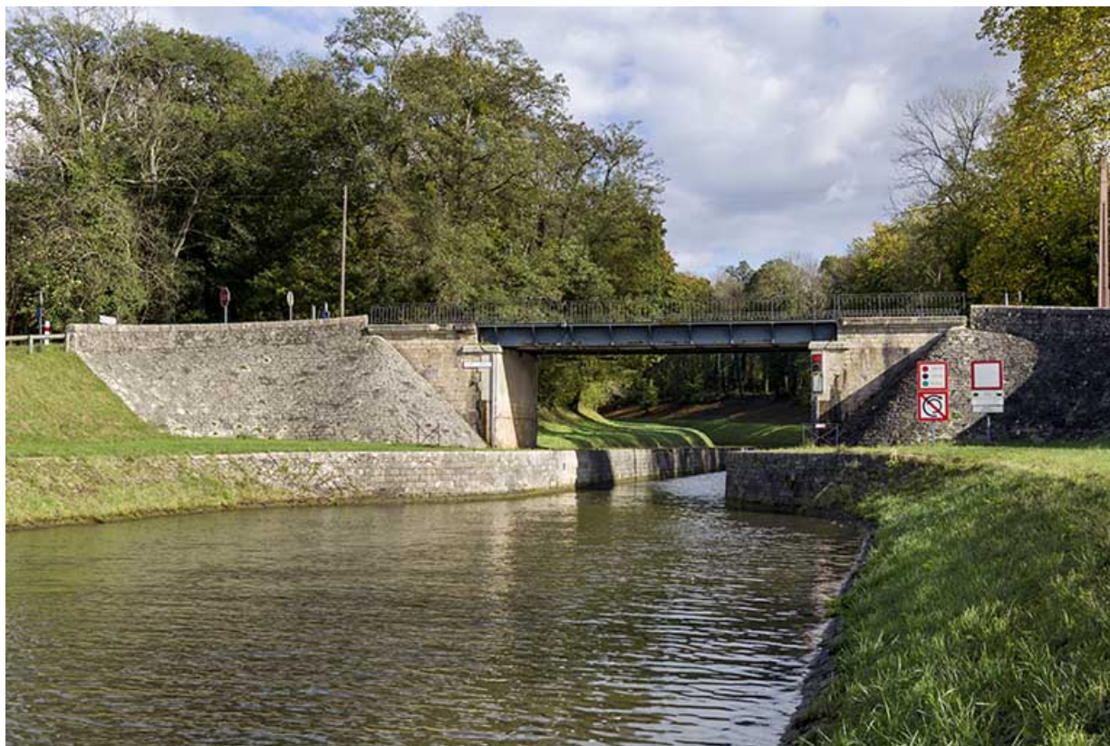
Passage de la dérivation à la partie canal en aval.
