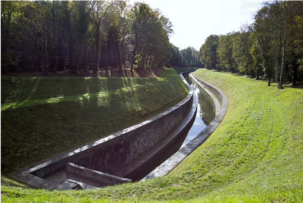
Le canal de navigation en aval. 70, Scey-sur-Saône-et-Saint-Albin
