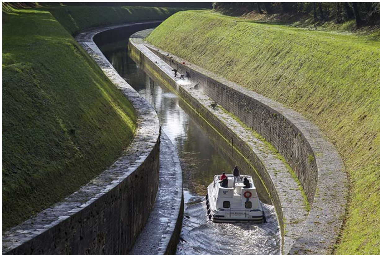
Le canal en aval formant un S.
