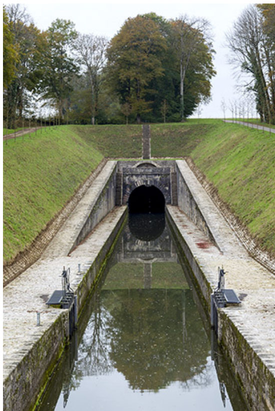
Entrée amont du tunnel de Saint-Albin.
