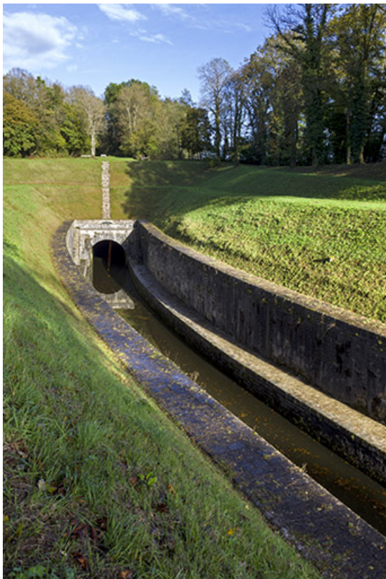
Entrée du tunnel depuis l'aval. 70, Scey-sur-Saône-et-Saint-Albin
