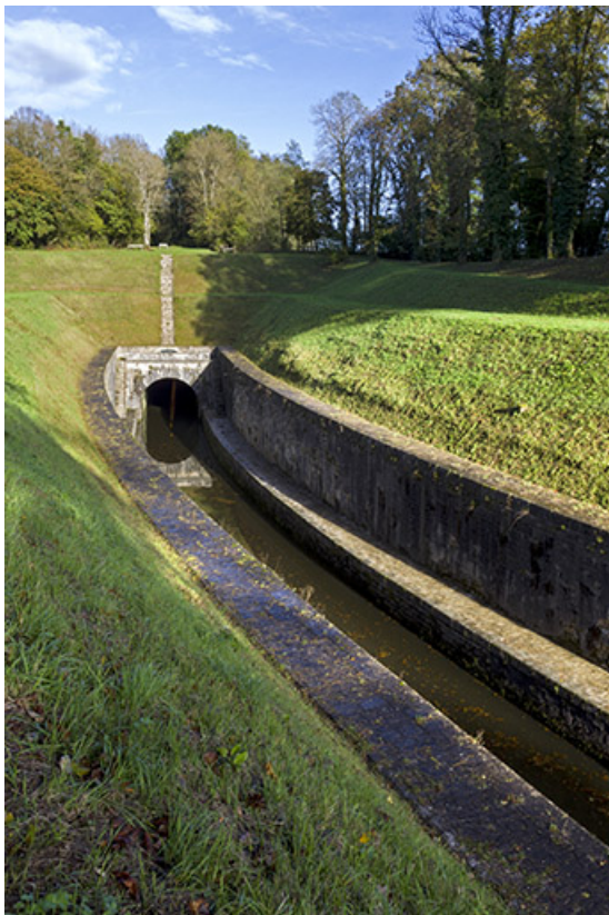
Entrée du tunnel depuis l'aval. 70, Scey-sur-Saône-et-Saint-Albin
