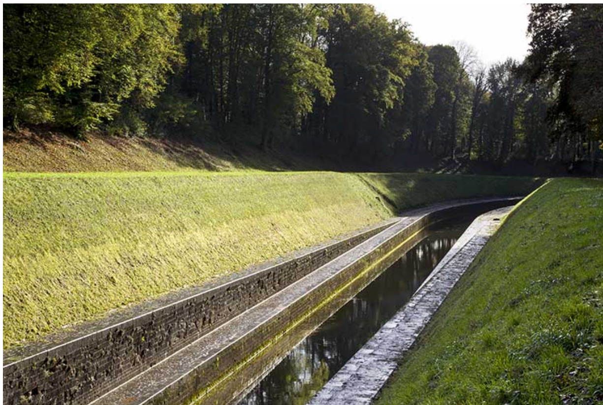
Le canal, vue aval.
