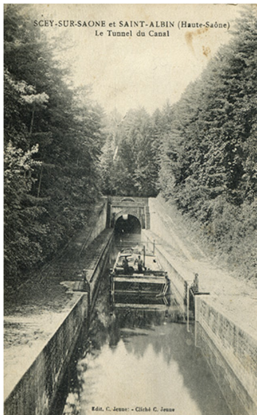
L'entrée amont du tunnel de Saint-Albin, carte postale. 70, Scey-sur-Saône-et-Saint-Albin
