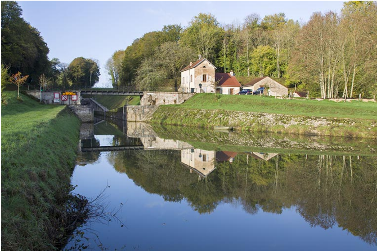
Entrée du canal depuis l'amont. 70, Scey-sur-Saône-et-Saint-Albin
