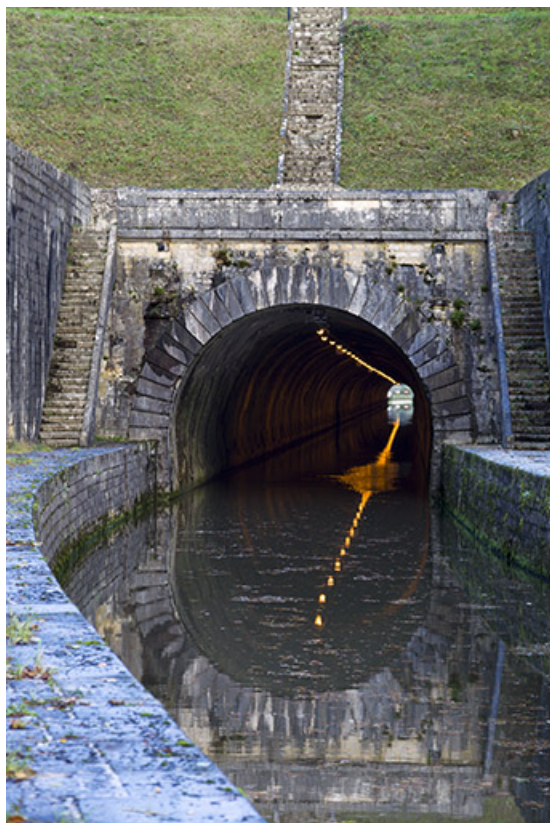
Le tunnel depuis l'aval.
