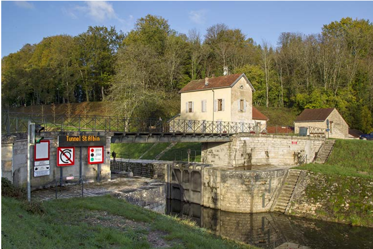
L'entrée du canal et la maison du barragiste. 70, Sceaux-sur-Saône-et-Saint-Albin
