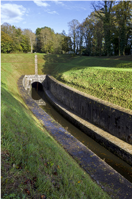
Entrée du tunnel depuis l'aval. 70, Scey-sur-Saône-et-Saint-Albin
