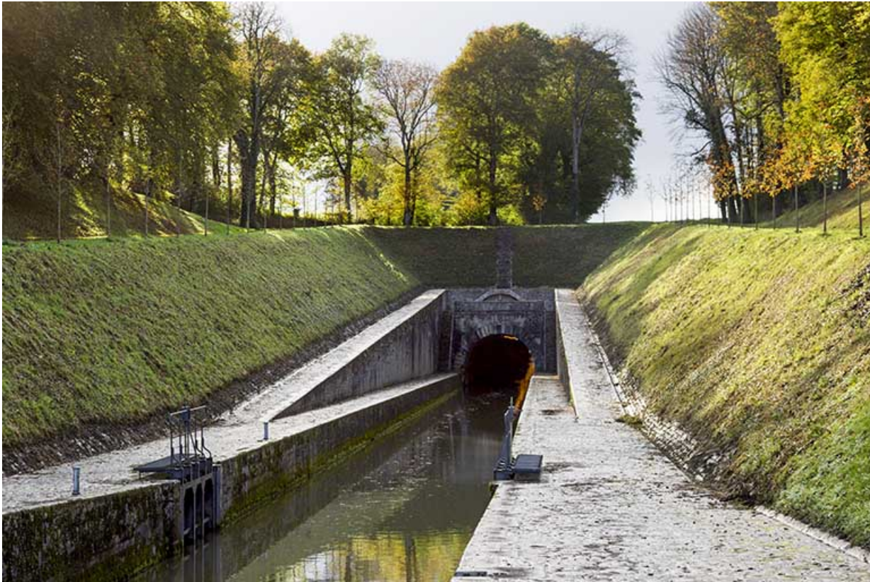
Le canal et le tunnel, vue amont.
