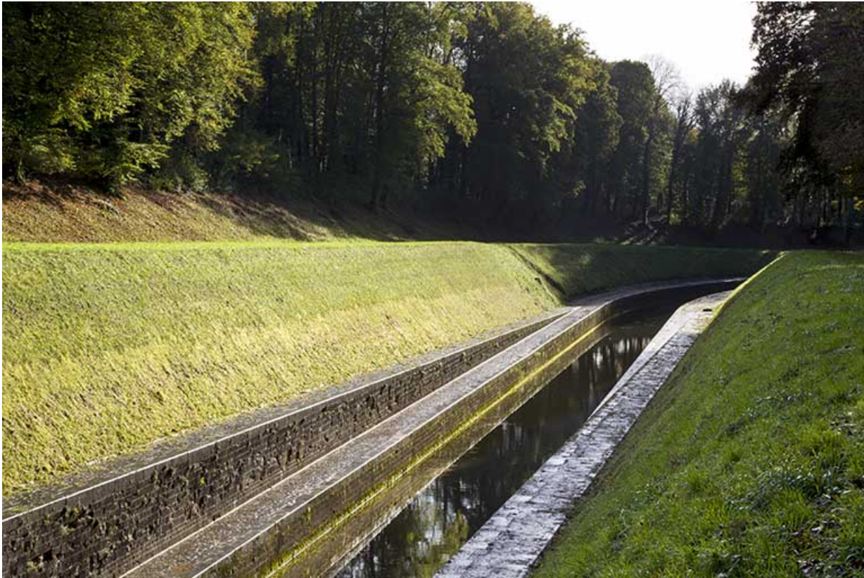
Le canal, vue aval.
