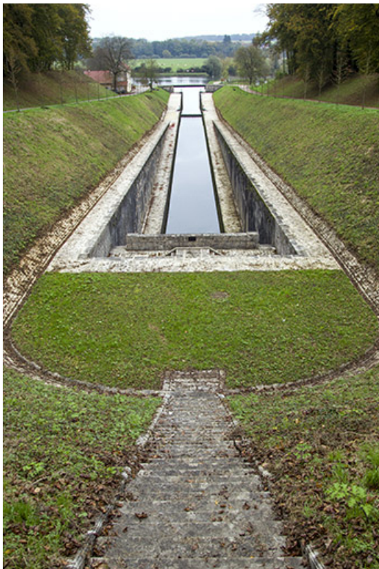
Vue du canal depuis le haut de l'escalier.
