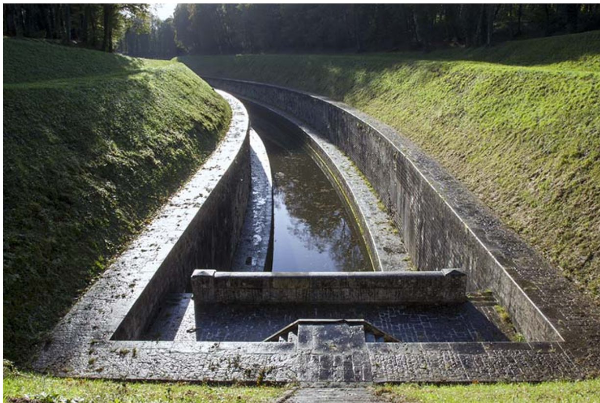
Vue vers l'aval depuis l'escalier surplombant l'entrée aval du tunnel.
