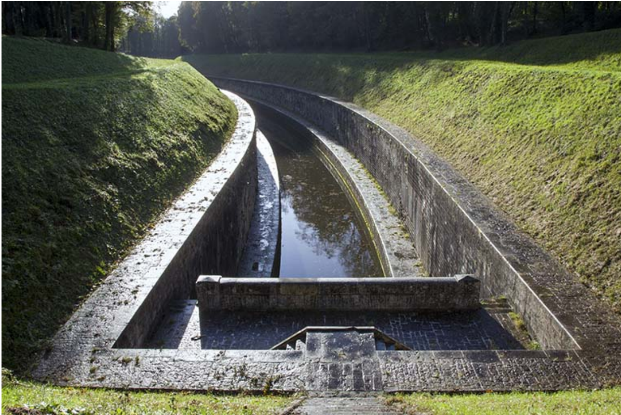
Vue vers l'aval depuis l'escalier surplombant l'entrée aval du tunnel. 70, Sceaux-sur-Saône-et-Saint-Albin
