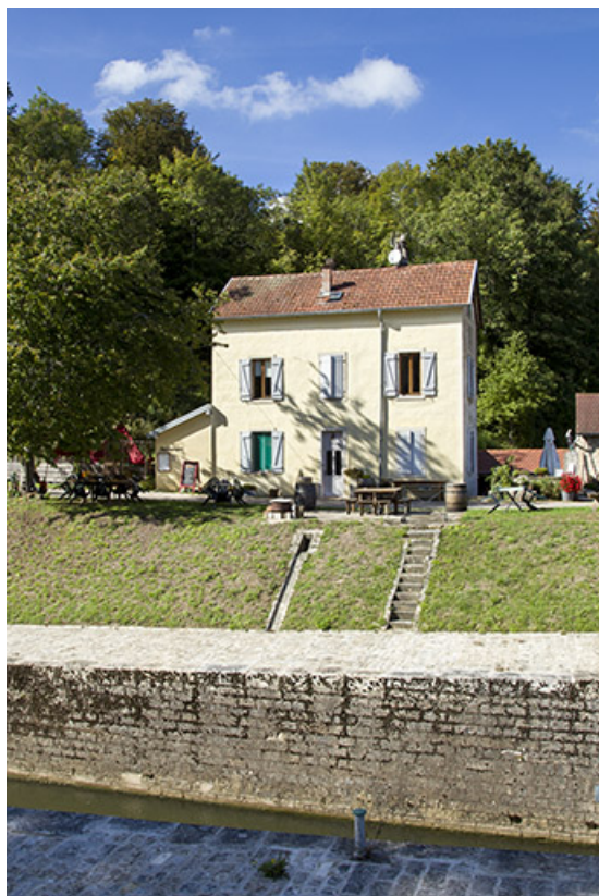
La maison du barragiste.
