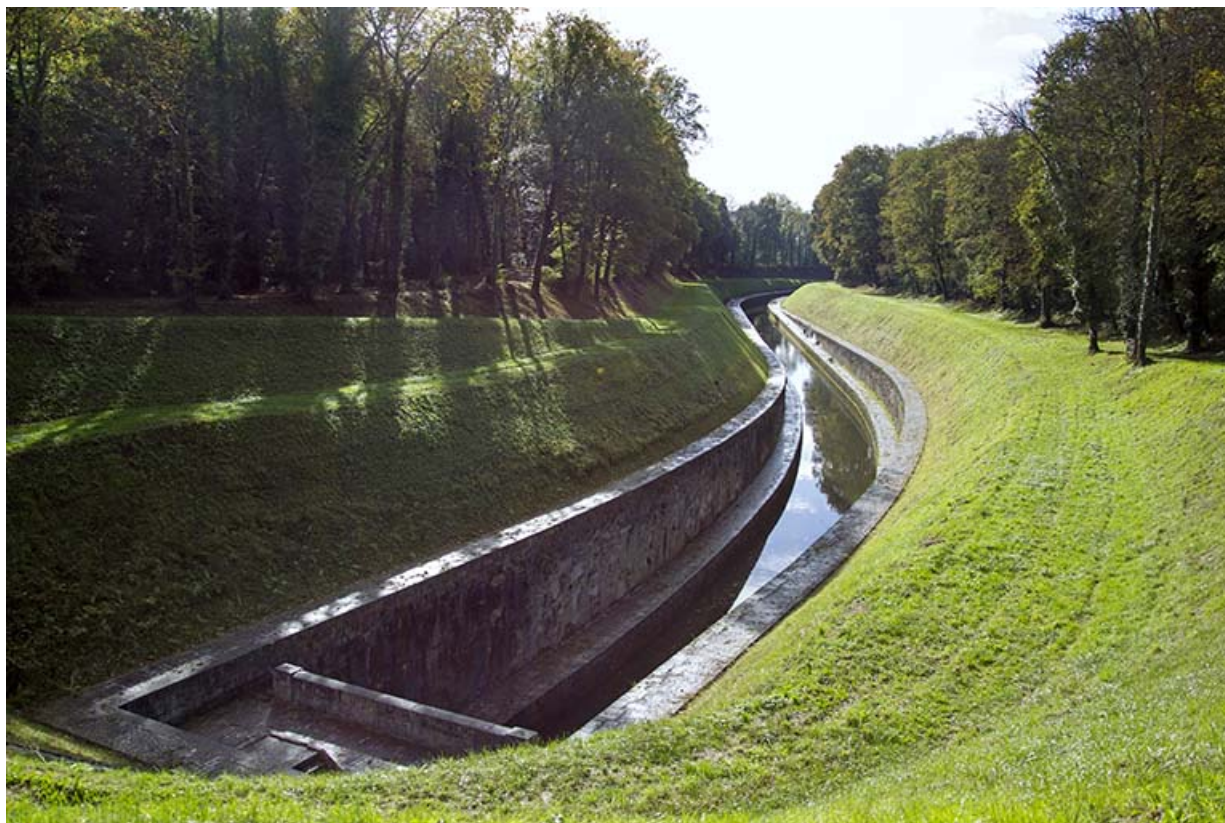
Le canal de navigation en aval. 70, Scey-sur-Saône-et-Saint-Albin
