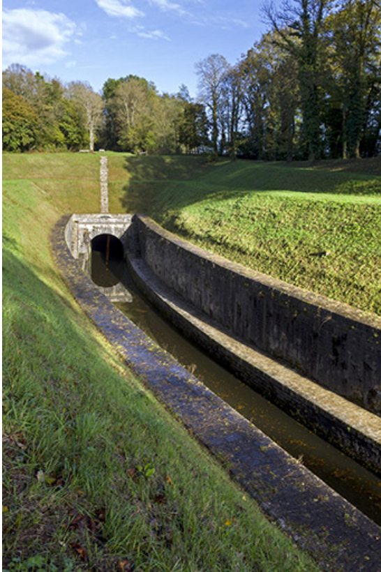
Entrée du tunnel depuis l'aval. 70, Scey-sur-Saône-et-Saint-Albin
