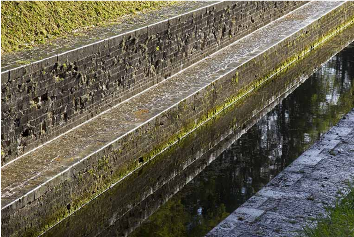
Vue sur la maçonnerie du canal. 70, Scey-sur-Saône-et-Saint-Albin
