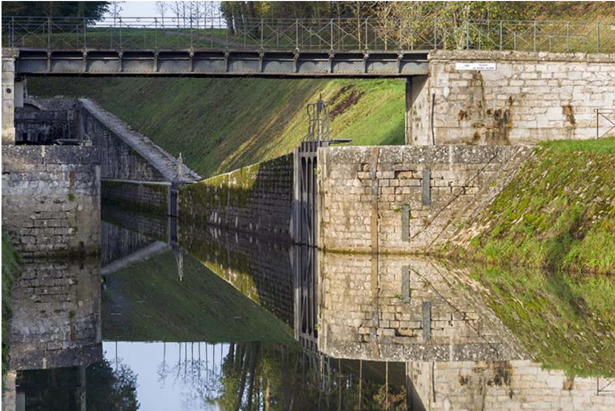
Entrée du canal amont et l'écluse de garde. 70, Scey-sur-Saône-et-Saint-Albin
