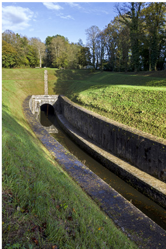
Entrée du tunnel depuis l'aval. 70, Scey-sur-Saône-et-Saint-Albin
