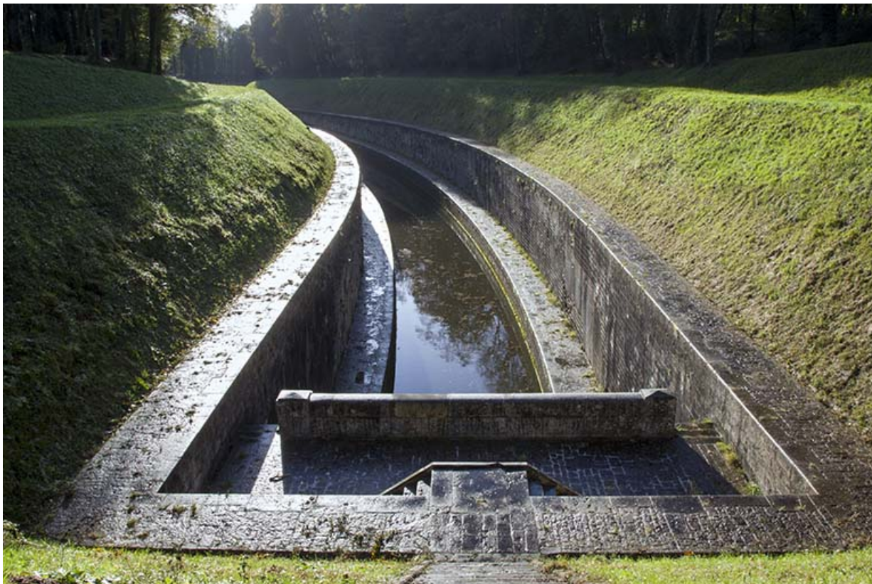
Vue vers l'aval depuis l'escalier surplombant l'entrée aval du tunnel. 70, Scey-sur-Saône-et-Saint-Albin
