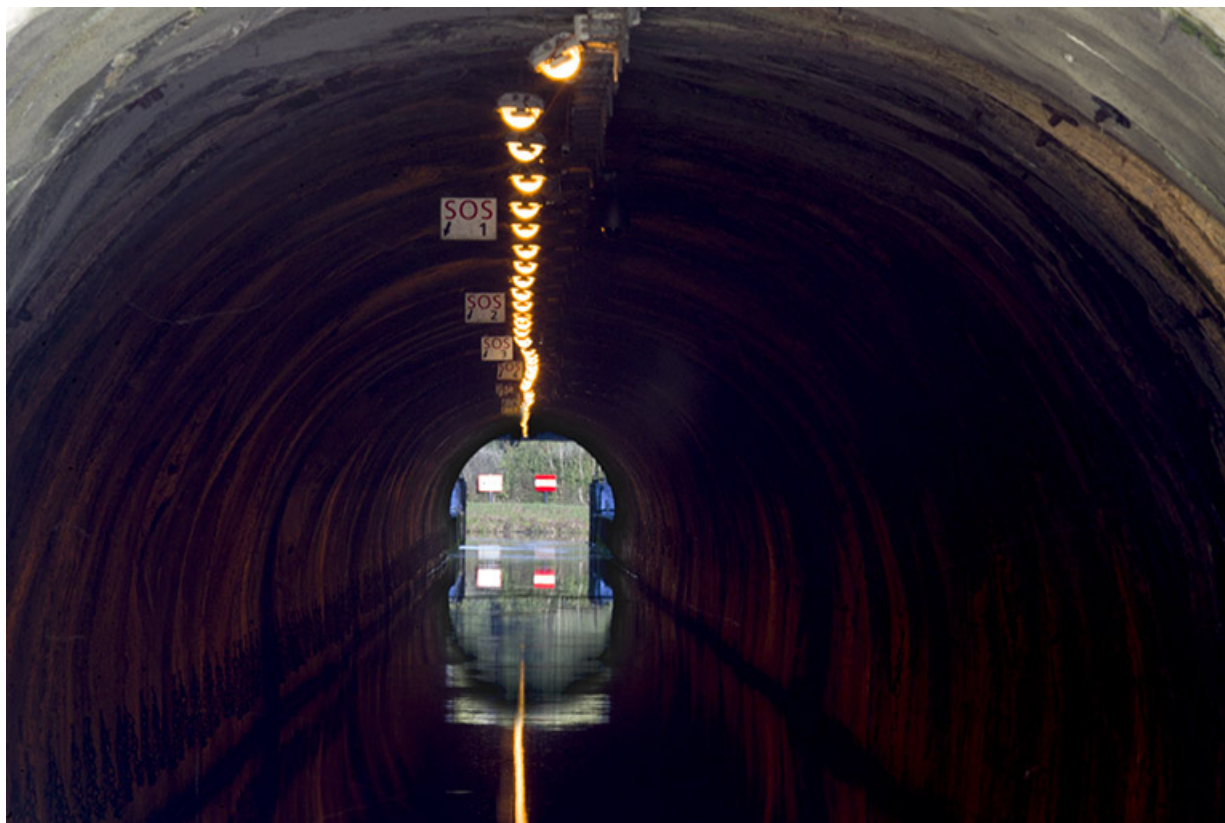
Le tunnel, vue intérieure.
