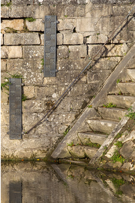
Echelles limnimétriques , porte de garde.
