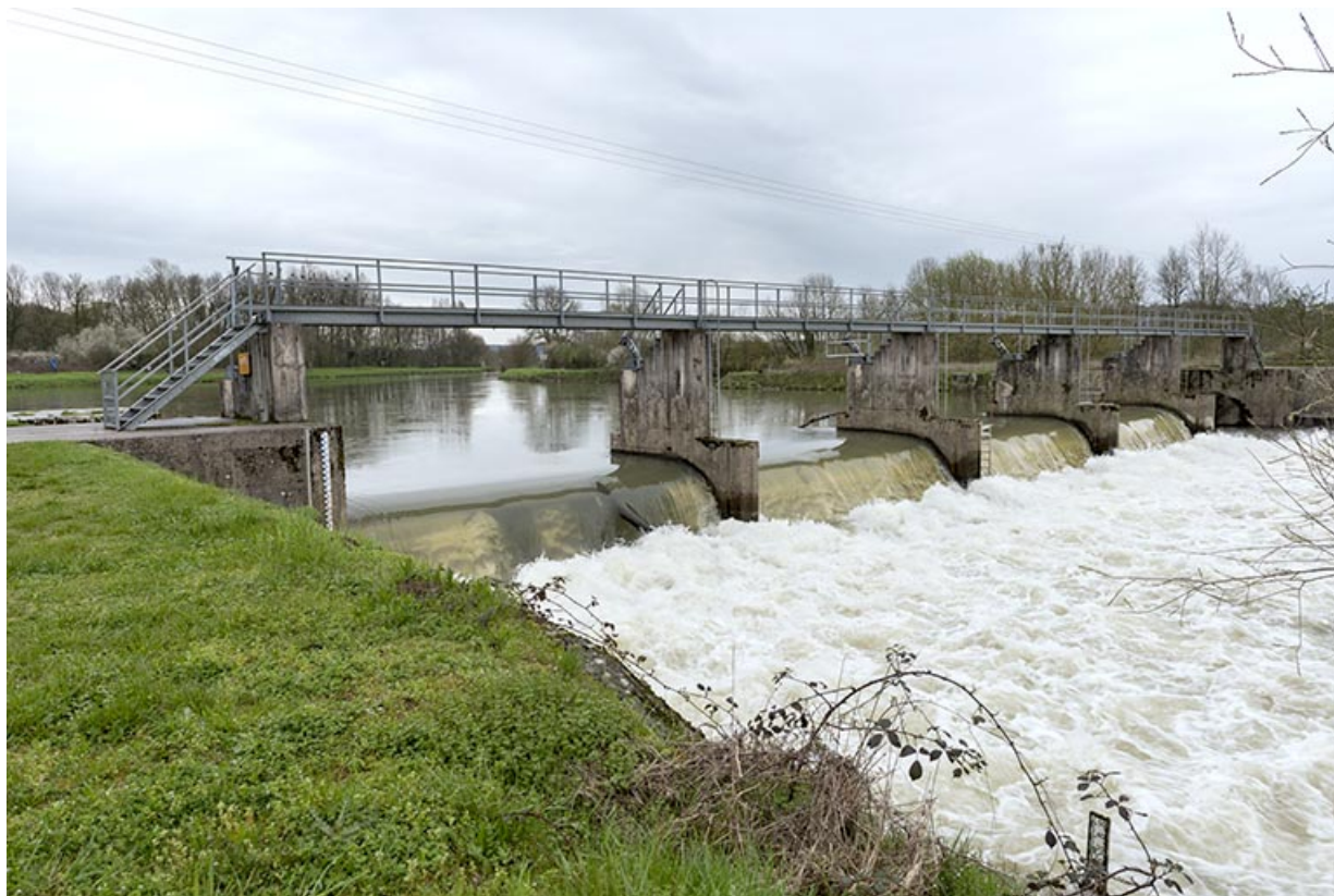
Vue depuis l'aval. 70, Rupt-sur-Saône
