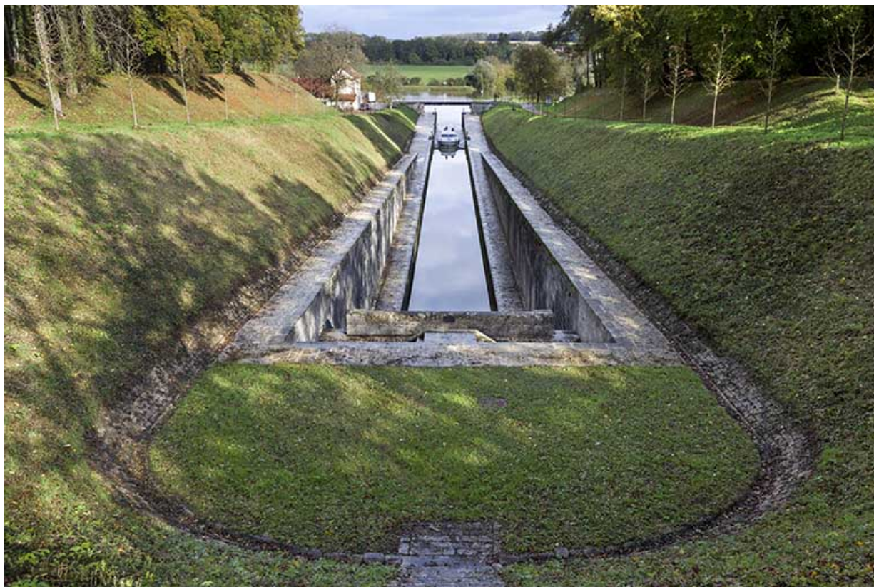
Vue amont du canal.
