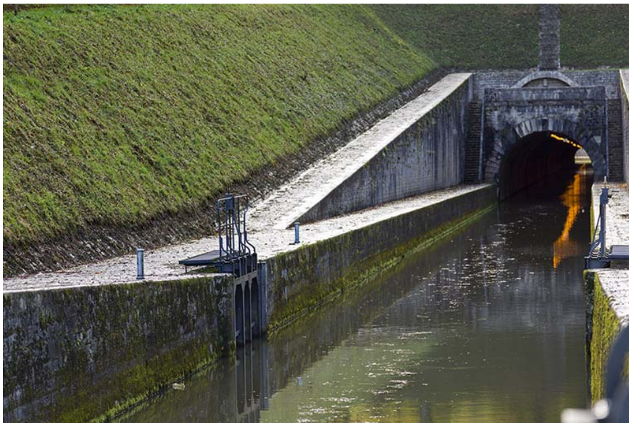
Le tunnel, vue amont.
