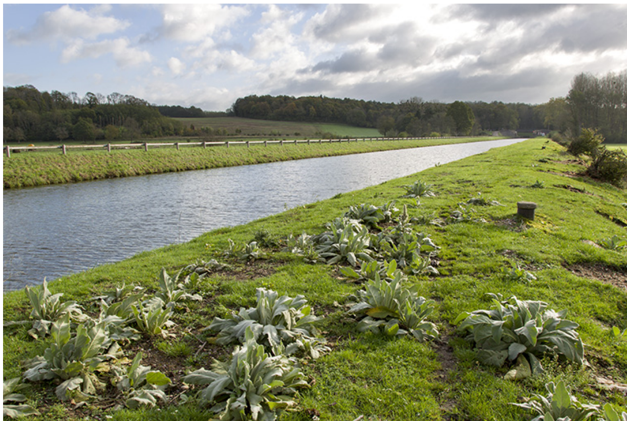
La dérivation au niveau de la commune de Rupt-sur-Saône. 70, Rupt-sur-Saône
