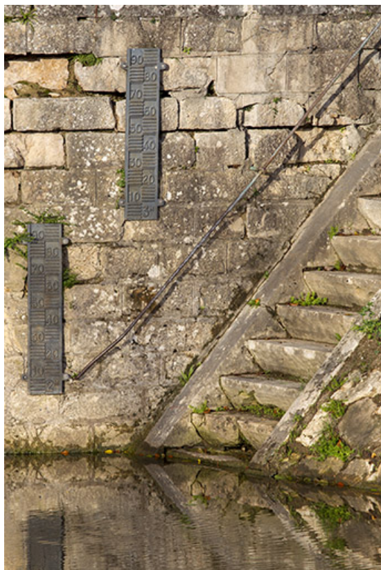
Echelles limnimétriques , porte de garde. 70, Rupt-sur-Saône
