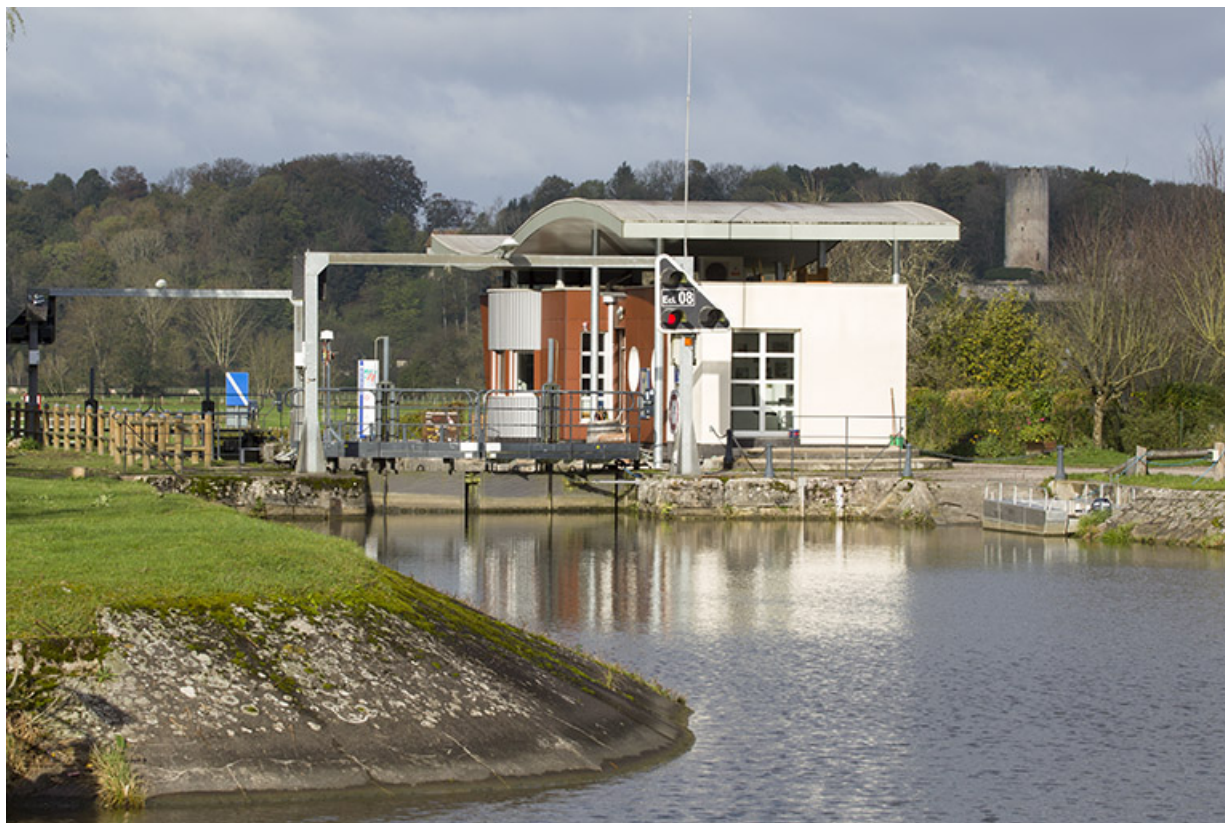
Le site d'écluse de Rupt-sur-Saône, fin du bief. 70, Rupt-sur-Saône
