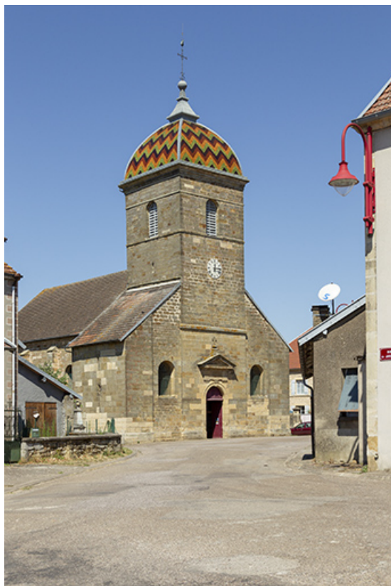
Vue de trois-quart sud-est.
