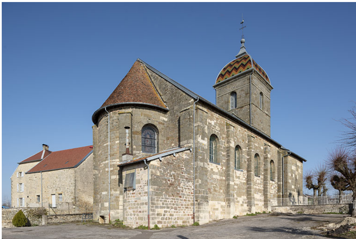
Vue de trois-quart arrière (sud-ouest) sur le chevet et la sacristie. Au second plan : l'ancienne cure et sa dépendance agricole. 70, Cendrecourt impasse de l'église
