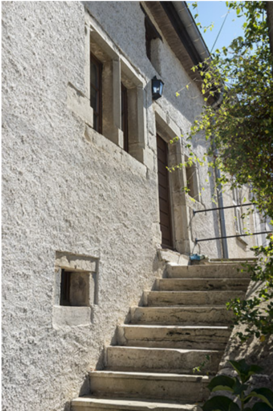
L'escalier extérieur permettant d'accéder à l'étage carré. 70, Conflandey, 10 rue des Pâtis
