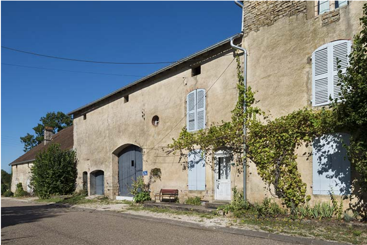
Vue générale depuis le nord-ouest.
