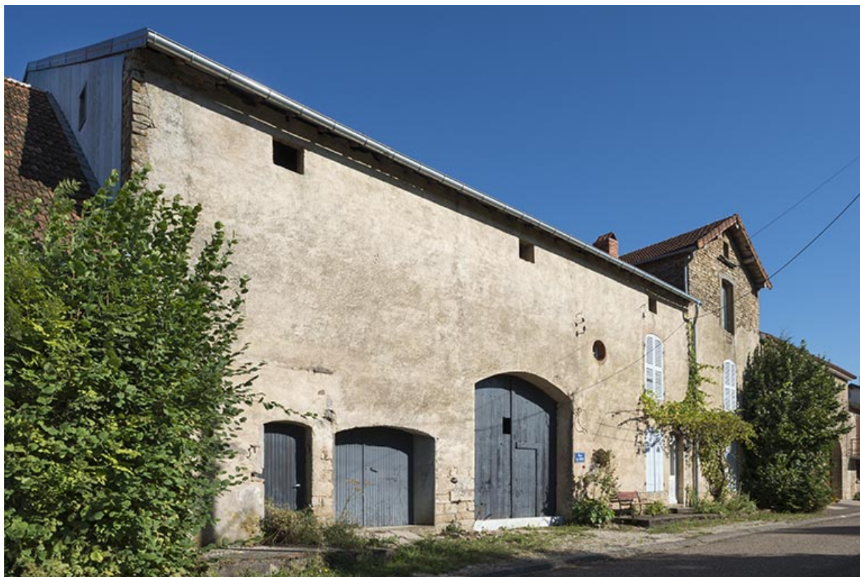
Vue générale depuis le sud-ouest.
