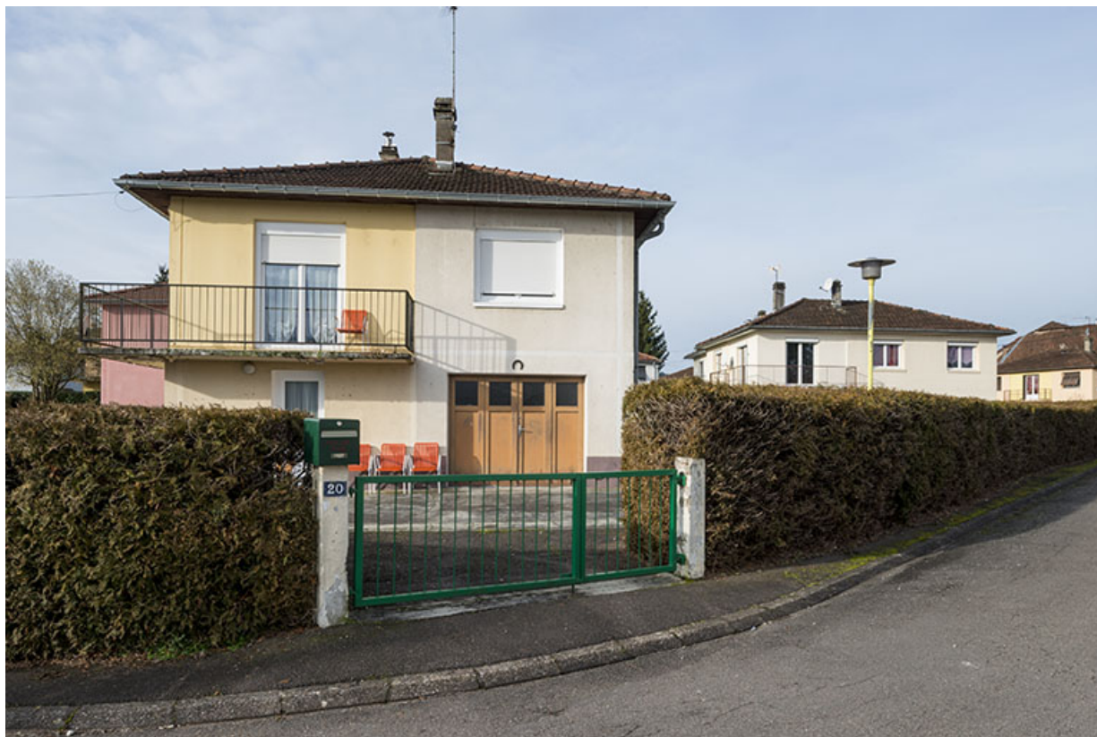
Façade antérieure d'une des maisons.
