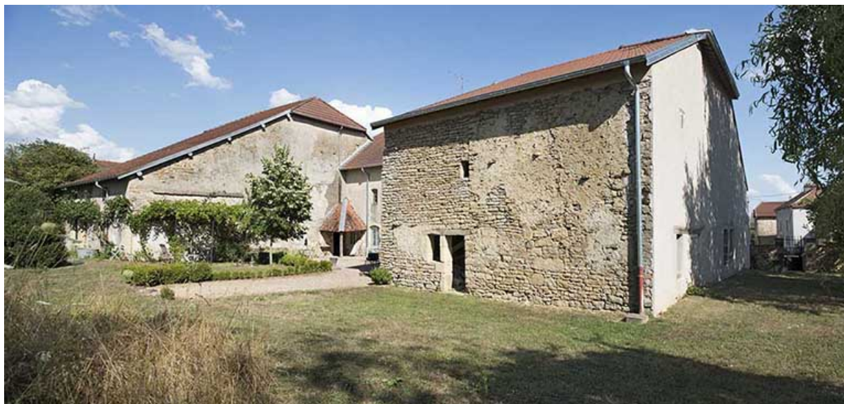
Vue de trois-quart nord-ouest de la façade postérieure.
