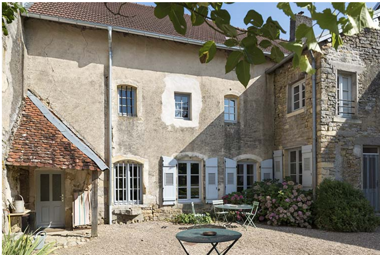
Vue rapprochée depuis le nord de la façade postérieure de la partie habitation. 70, Betaucourt place du Petit-Magny
