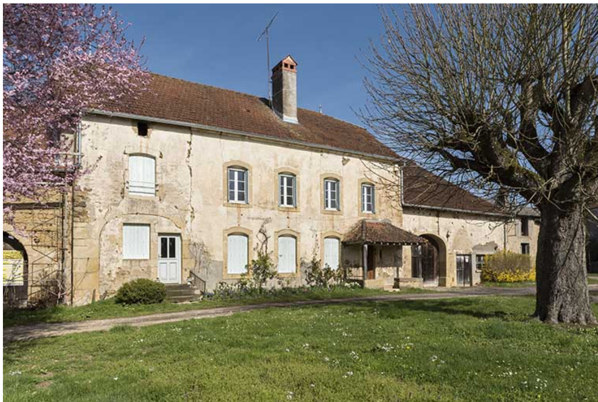
Façade antérieure de la demeure donnant sur la place.
