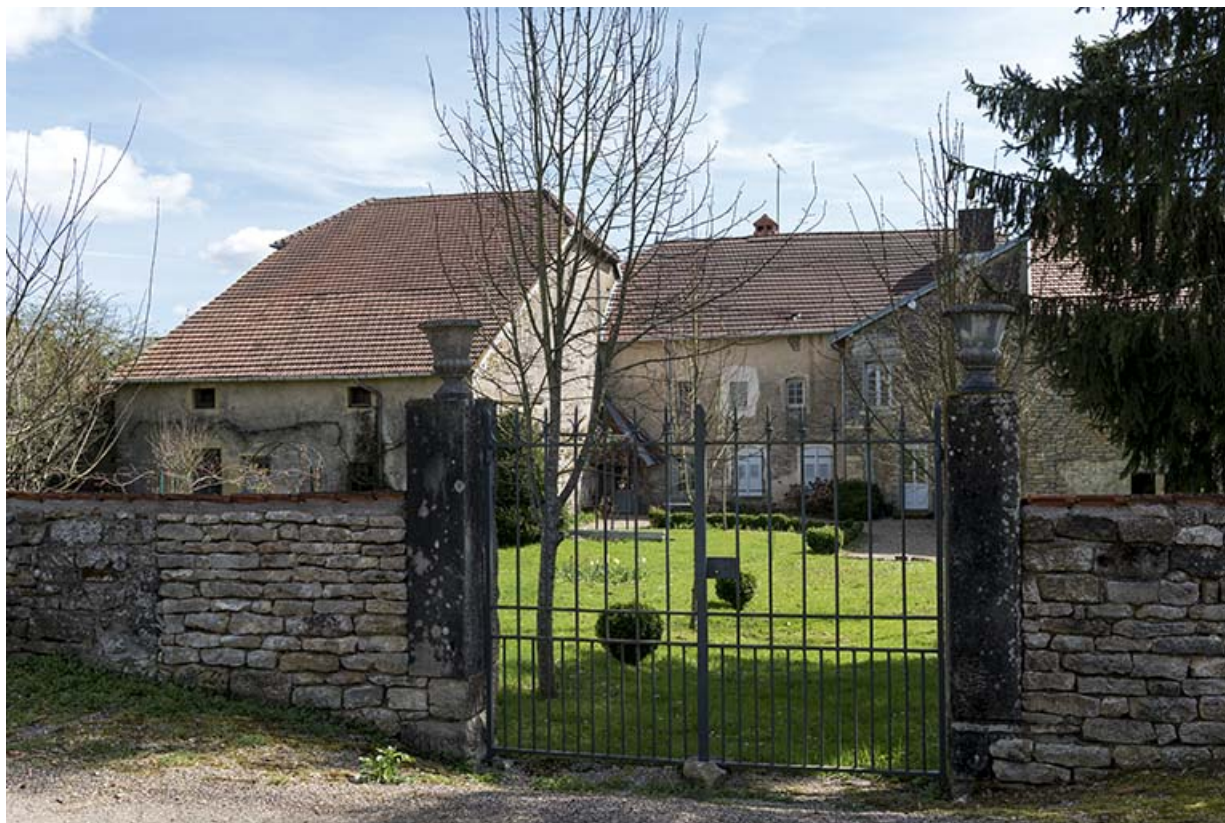
Porte flamande et vue de la façade postérieure depuis la rue de la Fontaine au nord-ouest. 70, Betaucourt place du Petit-Magny
