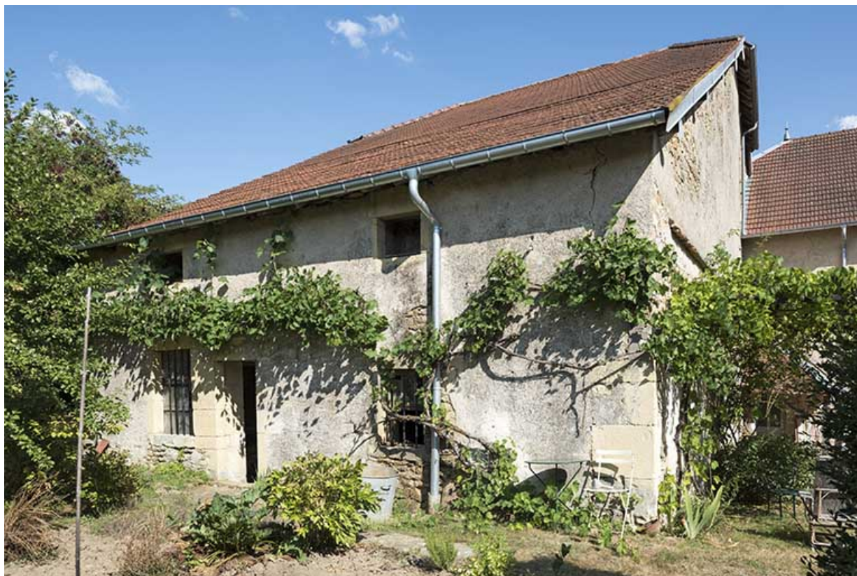
Vue rapprochée de trois-quart nord-ouest de la façade postérieure de la grange . 70, Betaucourt place du Petit-Magny
