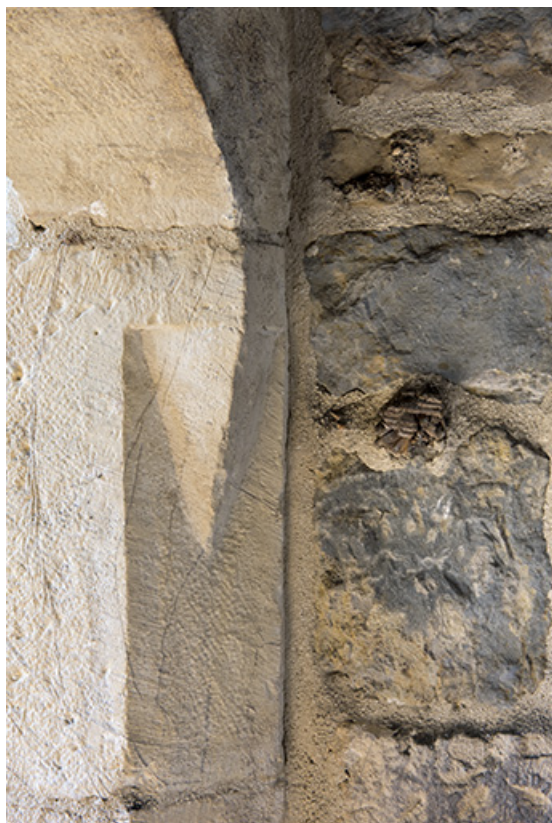
Détail sculpté des piédroits de la cheminée.
