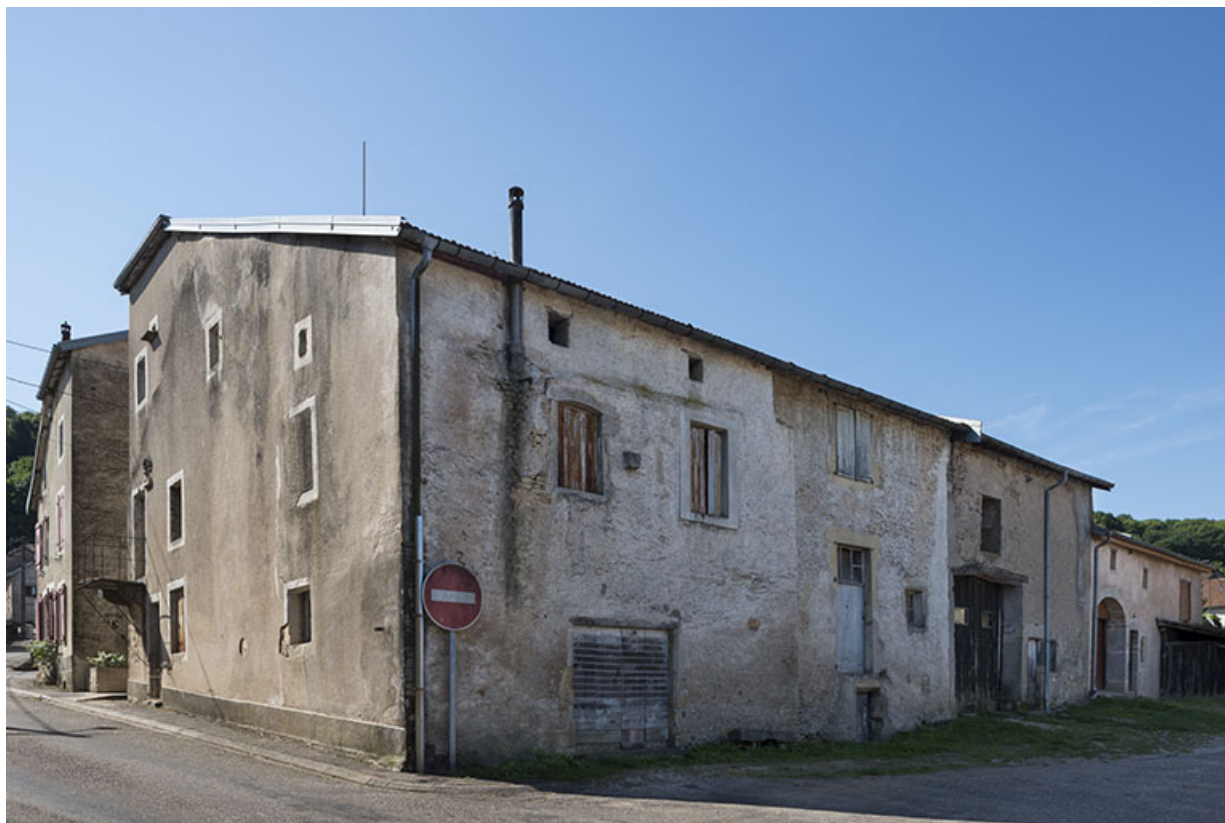
Vue depuis le nord.
