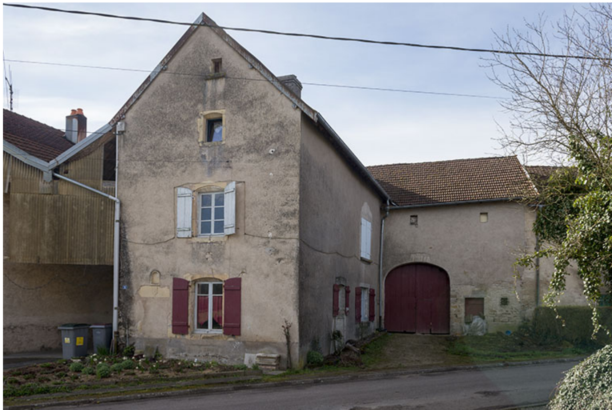
Ferme en équerre, rue du Bac. 70, Purgerot
