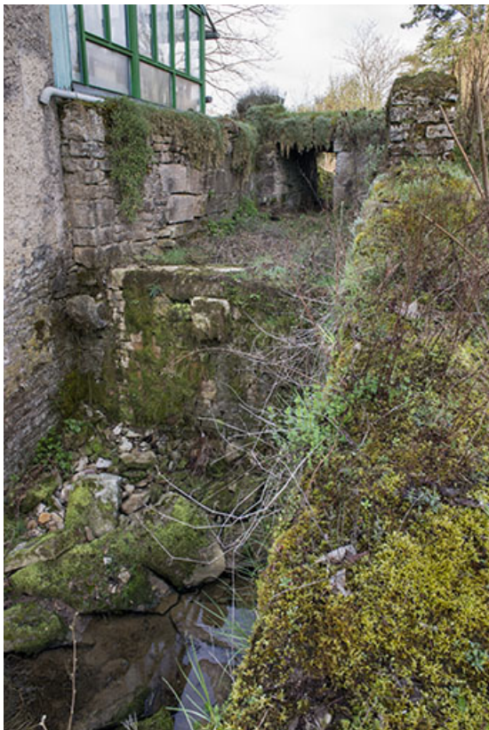
Le bief et la chute d'eau, moulin Guyot.
