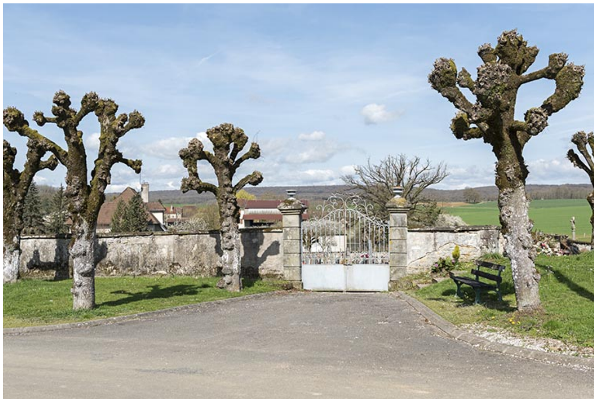
Grille d'entrée et mur d'enceinte du cimetière. 70, Betaucourt
