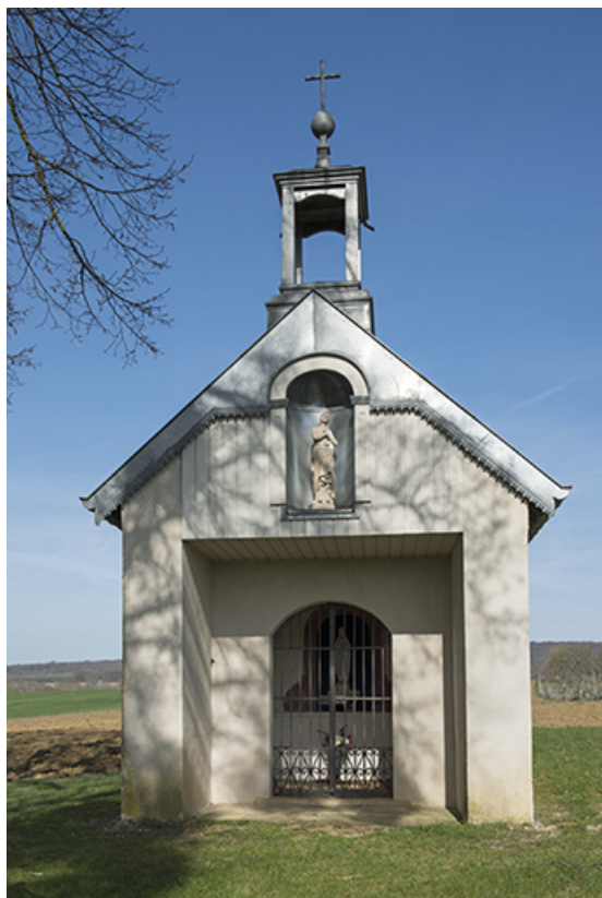
Chapelle saint-Brice. Vue de face.
