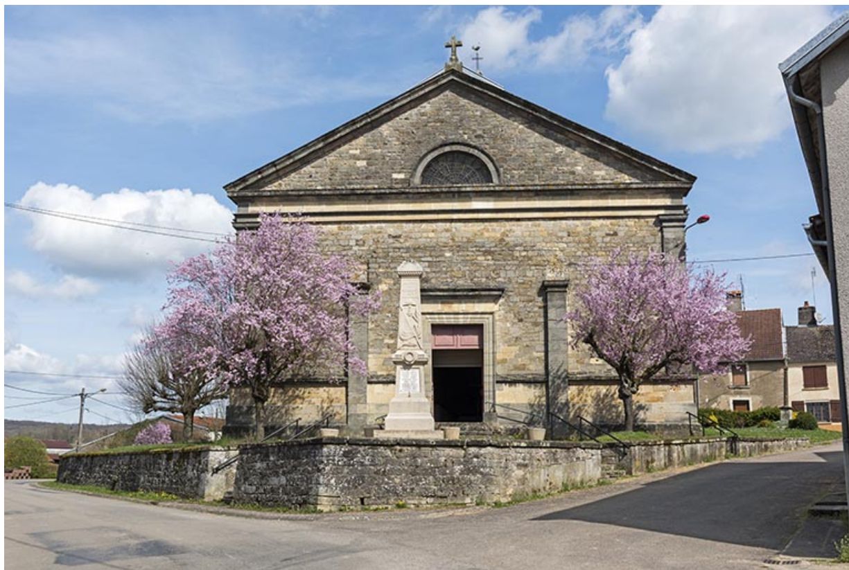
Portail d'entrée vue de face, depuis le sud. 70, Betaucourt
