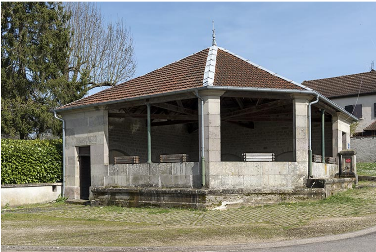
Fontaine-lavoir rue Saint Antoine : vue de trois -quart sud-ouest. 70, Betaucourt
