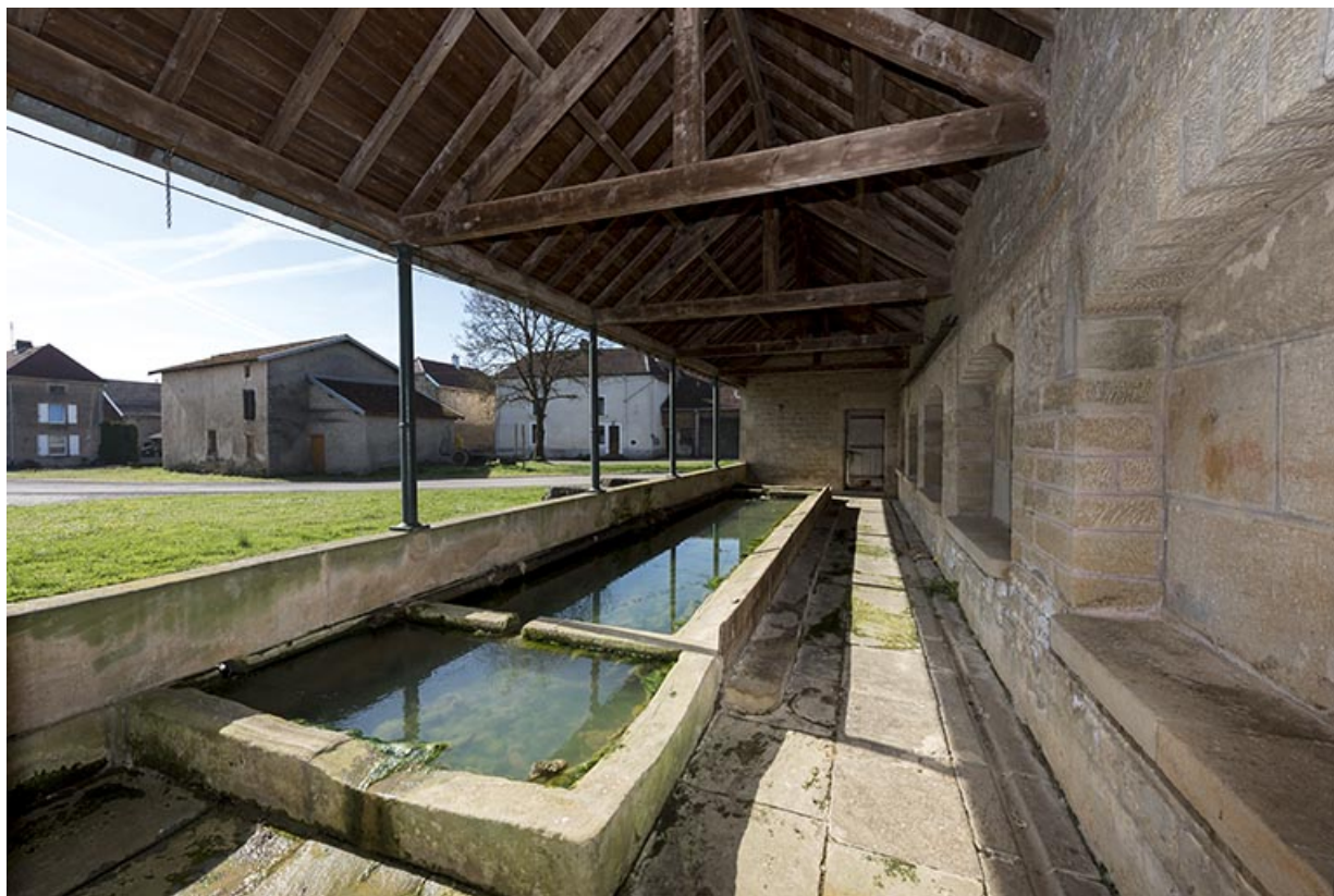
Fontaine-lavoir du Petit-Magny : vue intérieure depuis le nord-est. 70, Betaucourt
