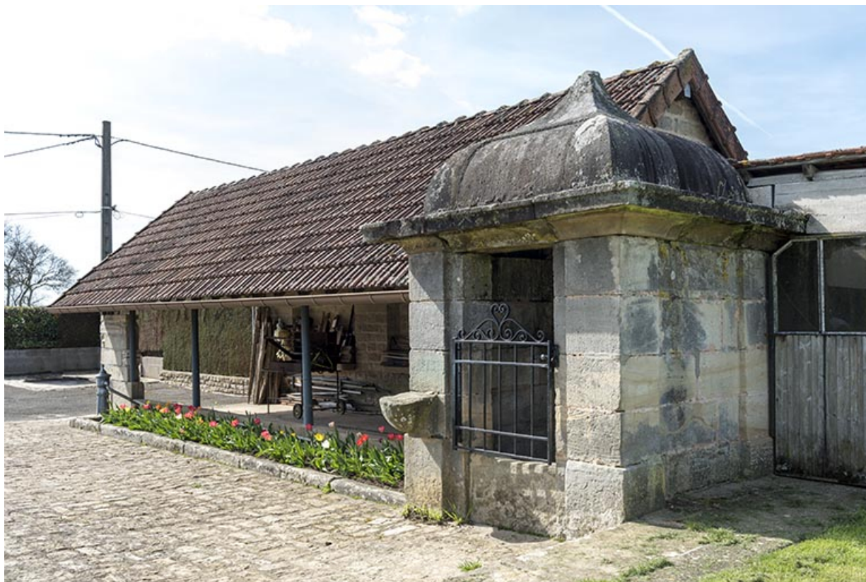
Ancienne fontaine-lavoir, 2 rue de Jonvelle : vue de trois-quart est. 70, Betaucourt
