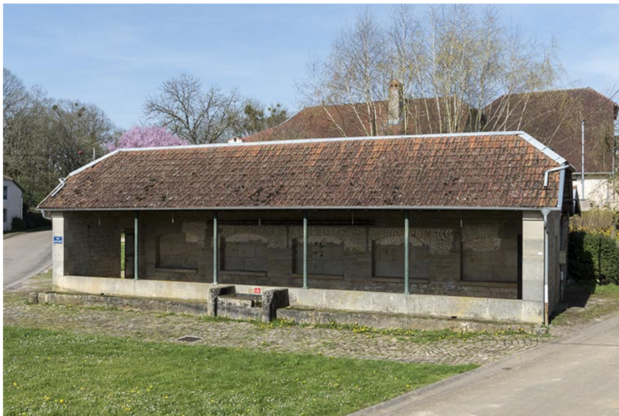
Fontaine-lavoir du Petit-Magny : vue de face depuis l'est. 70, Betaucourt
