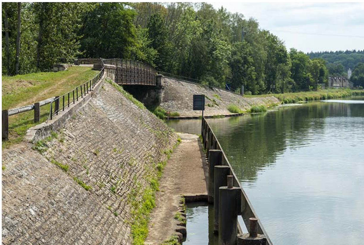
Perrée en aval de l'écluse et le pont de la Lanterne. 70, Conflandey
