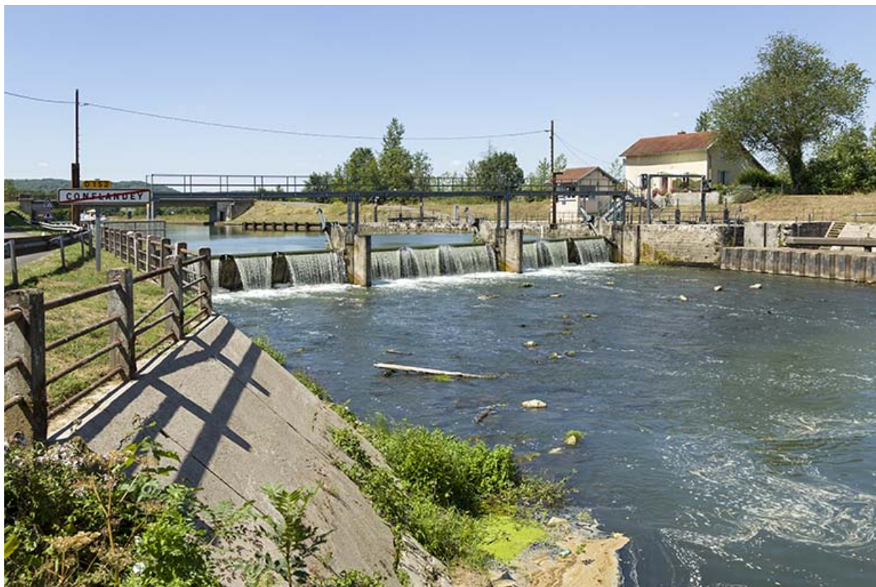
Barrage de Conflandey vu de la rive droite en aval. 70, Conflandey
