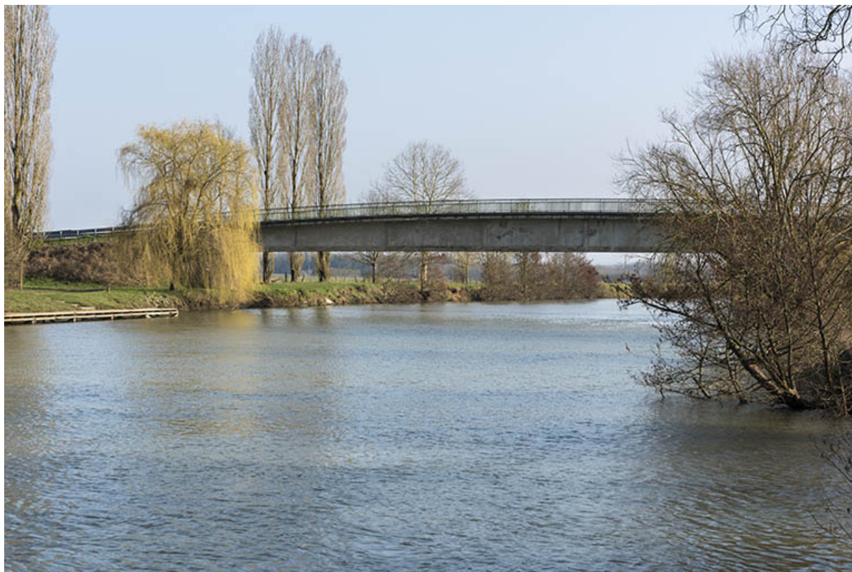
Franchissement de la Saône : pont de Fouchécourt. 70, Conflandey
