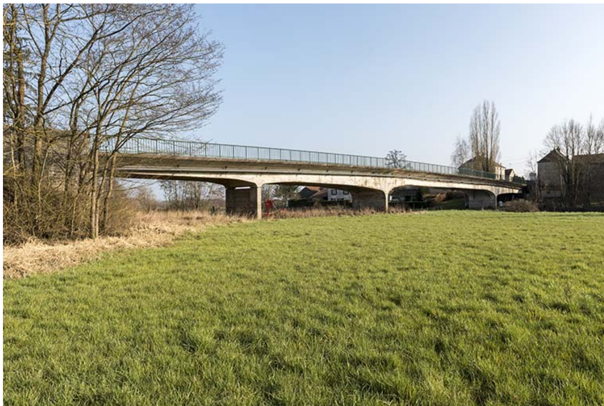
Franchissement de la Saône : pont routier à Port d'Atelier. 70, Conflandey
