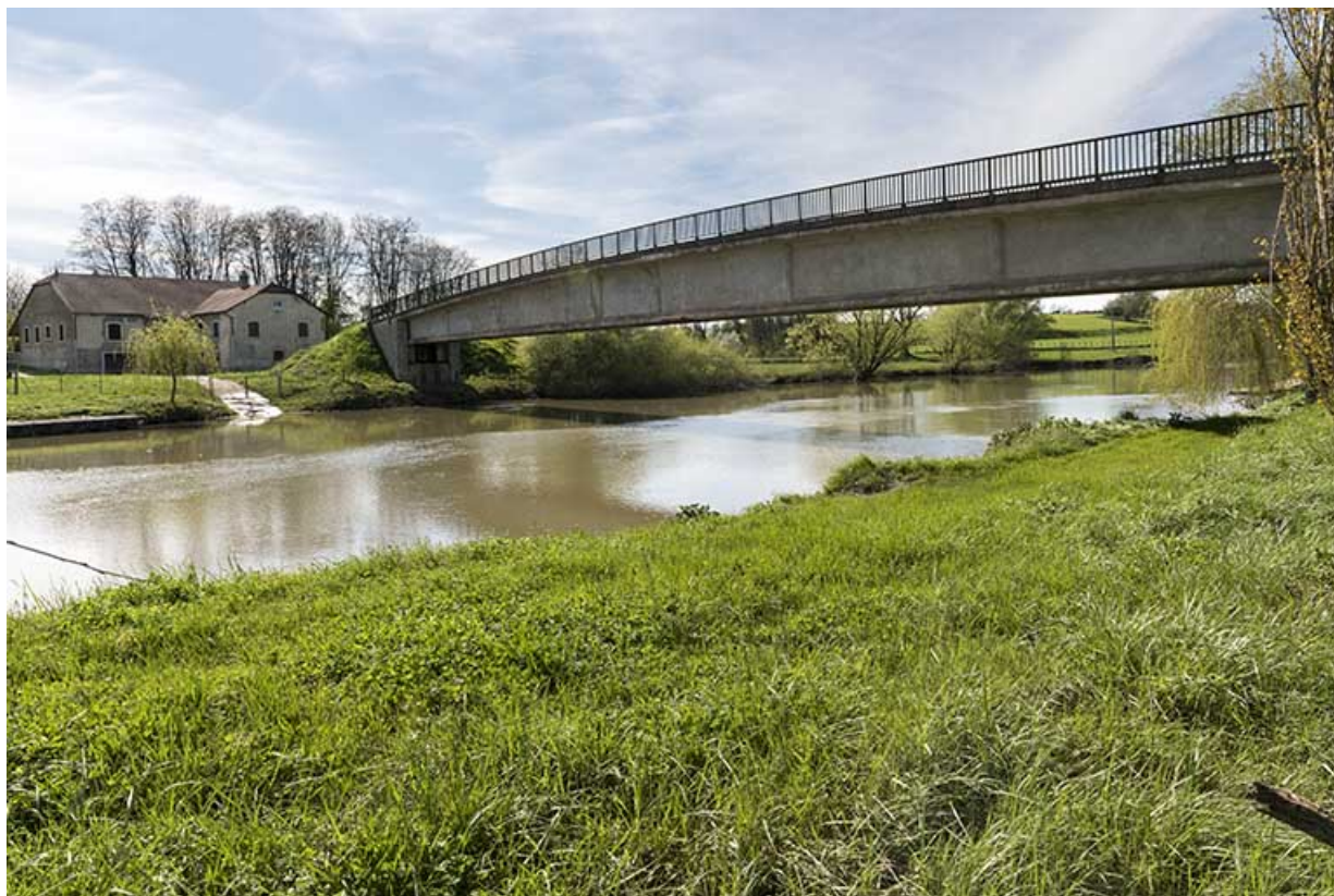
Franchissement de la Saône : pont de Fouchécourt.
