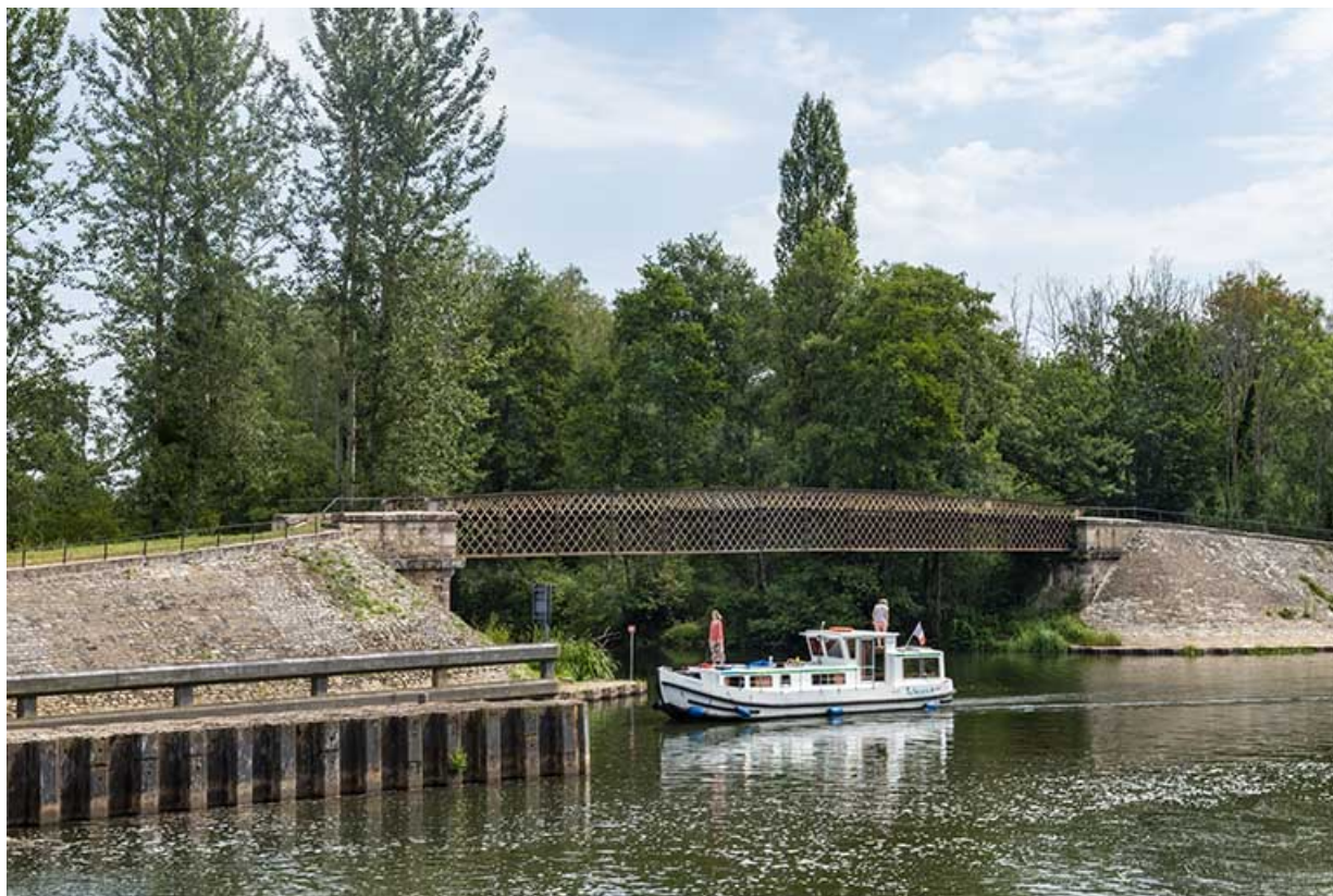
Plaisanciers s'appêtant à entrer dans l'écluse. 70, Conflandey
