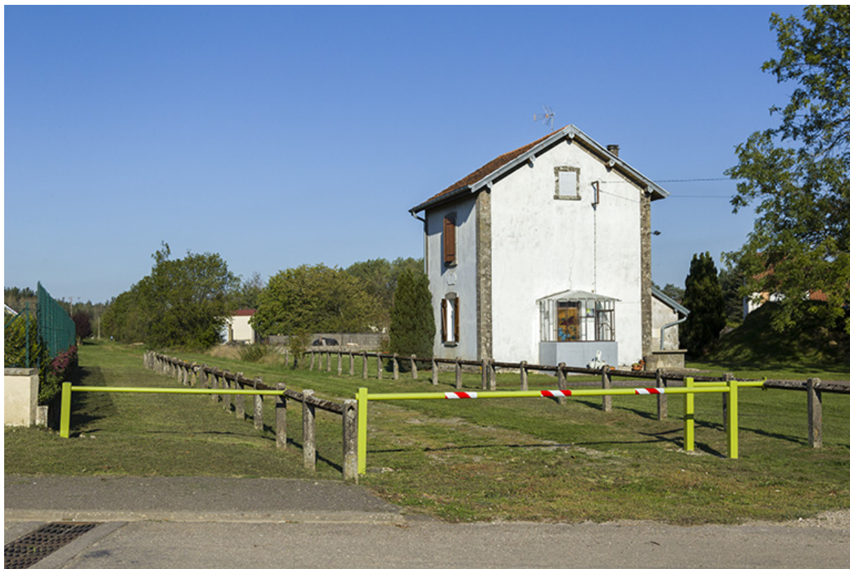
Vue de trois-quart nord-ouest de l'ancienne maison de garde-barrière.
