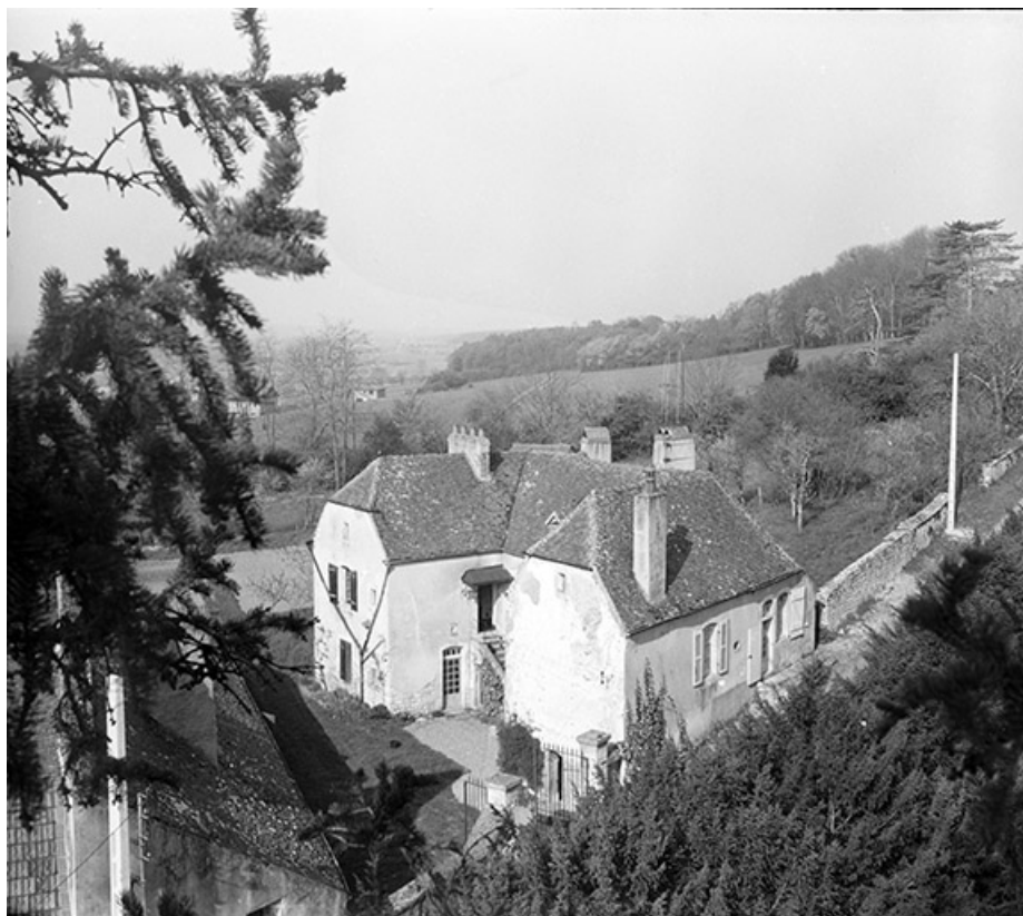
[Vue d'ensemble depuis le parc du château], 1955.
