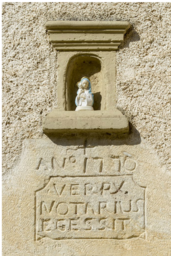
Détail de l'aile en retour d'équerre sur cour : inscription et date (1770). 70, Ray-sur-Saône, 17 rue du Château
