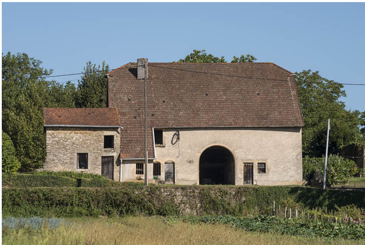
Vue depuis le chemin de la Charrière.
