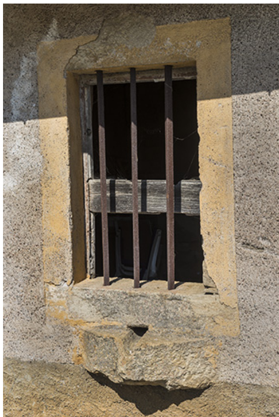
La fenêtre de la cuisine.
