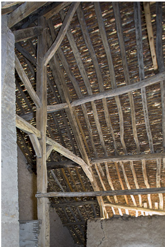
Intérieur : détail de la charpente.
