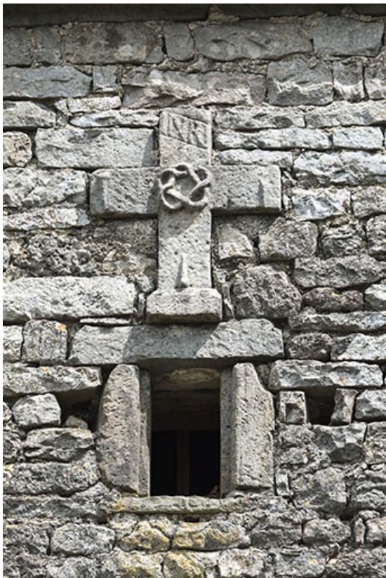
Détail de la croix sous la demi-croûpe du mur pignon 16 rue des Vosges. 70, Vougécourt
