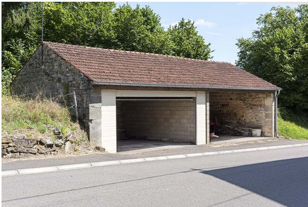
Ancienne fontaine-abreuvoir réaffecté à usage de hangar, rue des Marronniers. 70, Vouécourt
