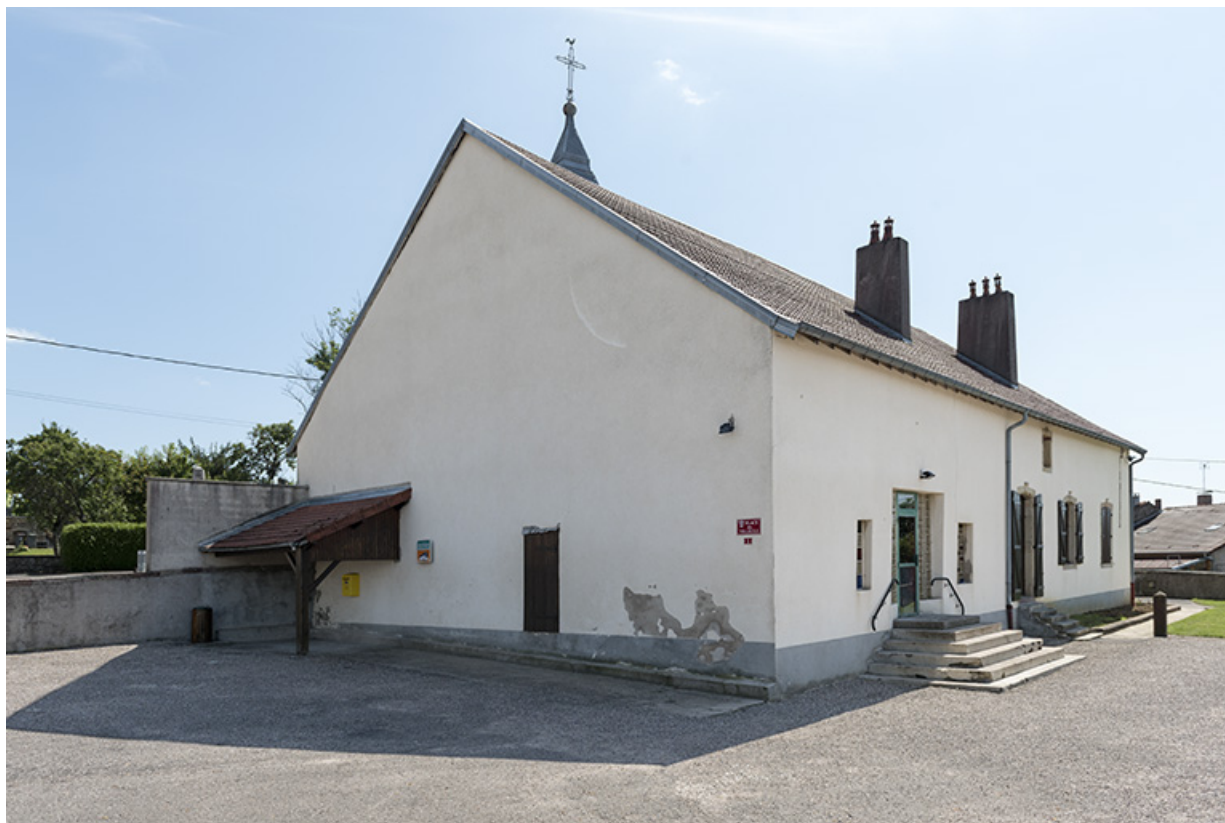
Mairie vue de trois-quart de la façade postérieure.
