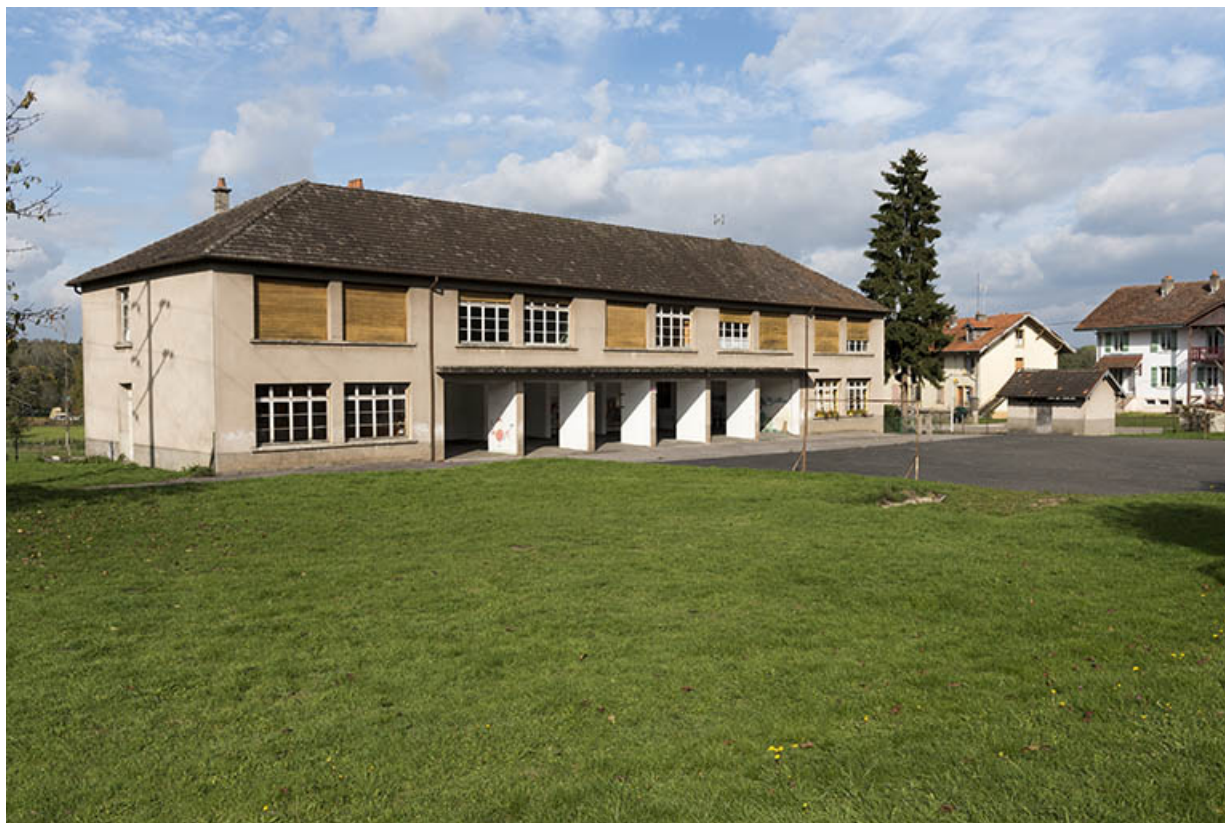
Vue de trois quart sud-ouest de la façade sud de la mairie.
