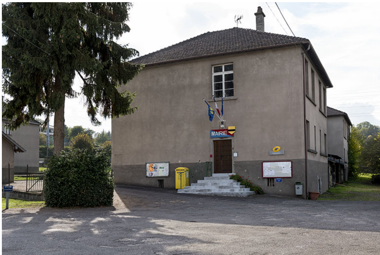
Pignon d'entrée nord-est de la mairie.
