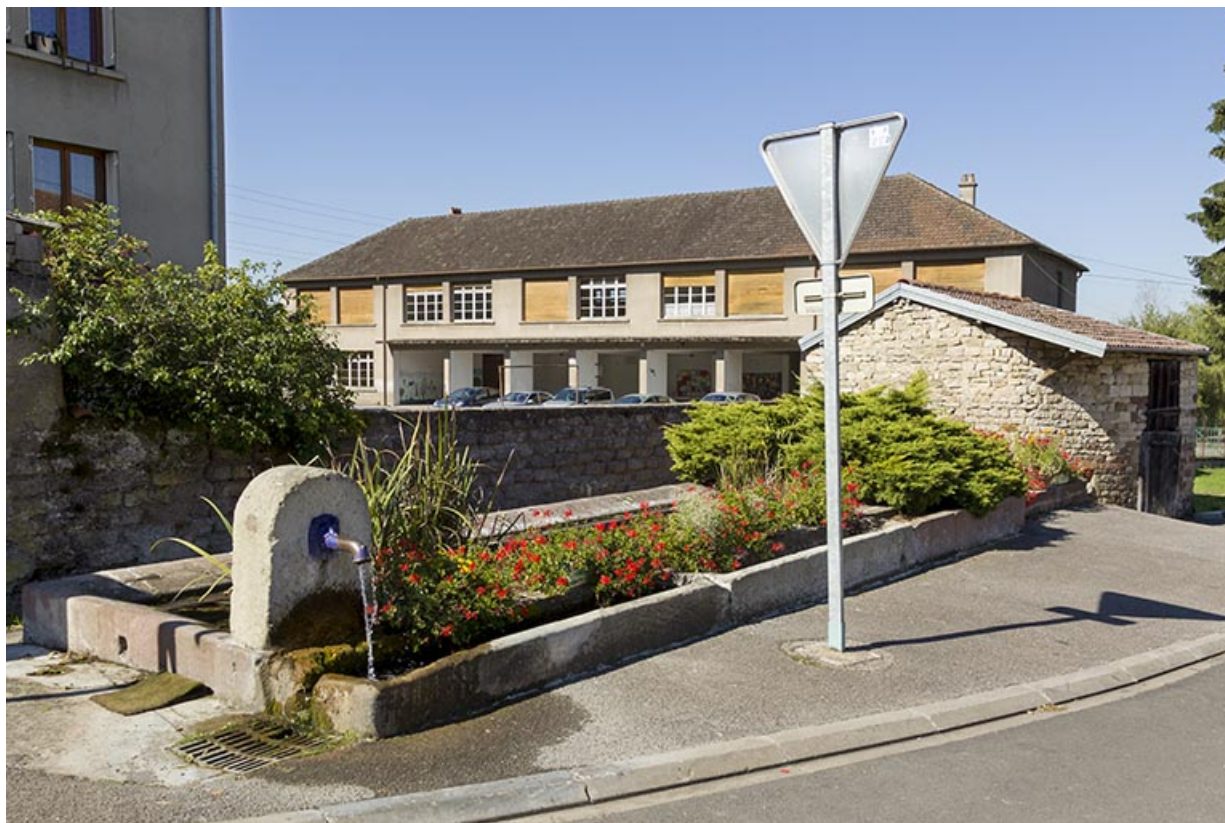
Fontaine, mairie, ancienne mairie école, ancienne poste. Vue de trois quart sud-est. 70, Demangevelle
