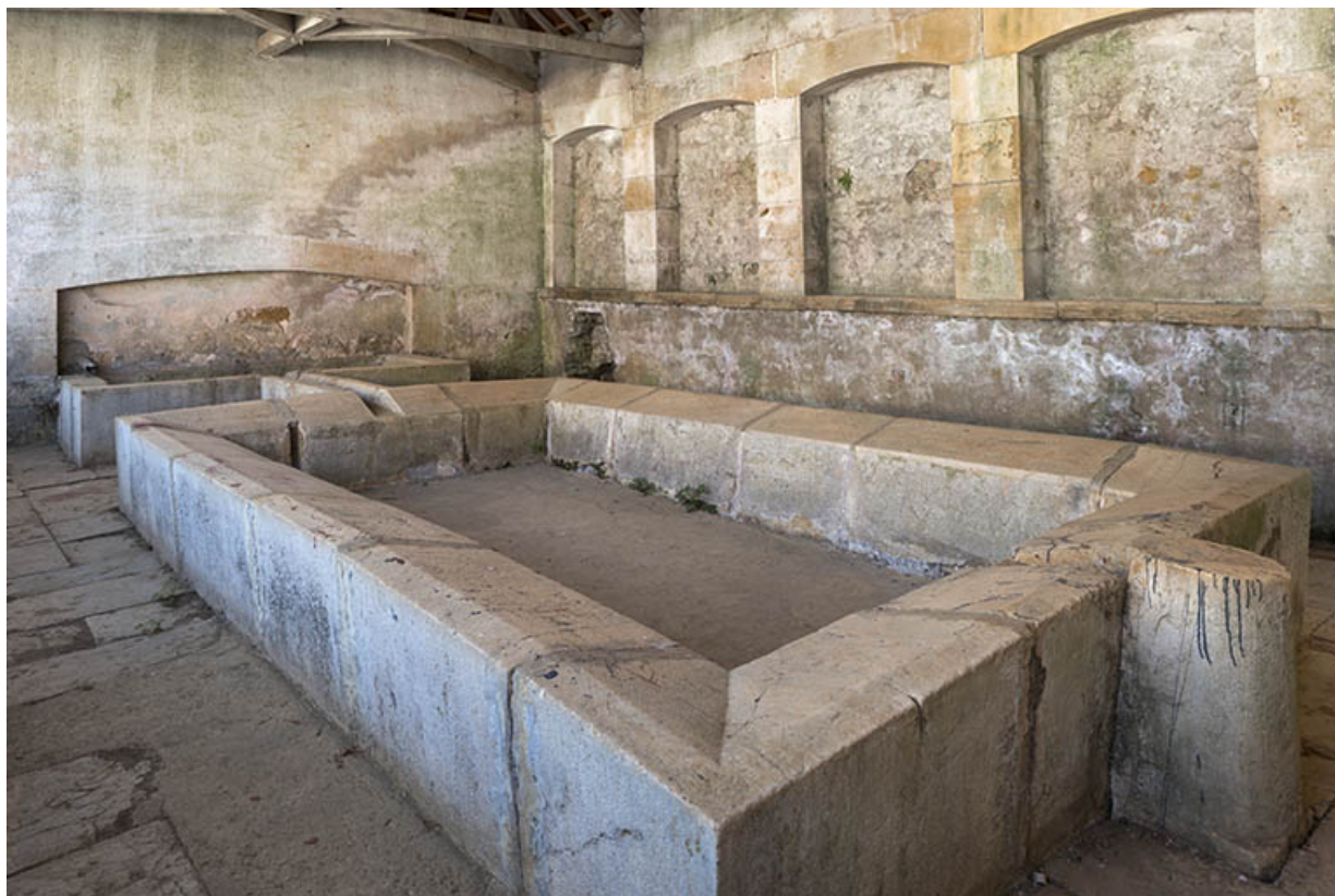
Le bassin du lavoir.
