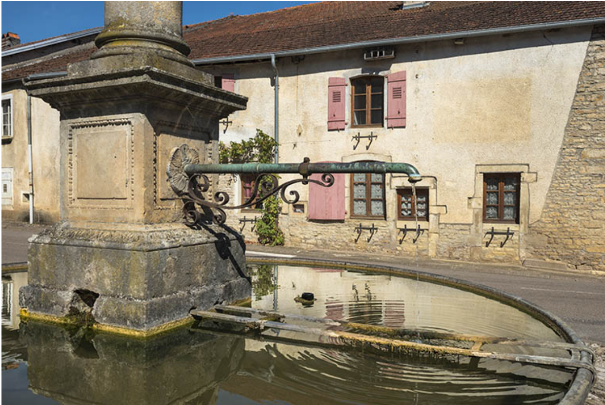
Le bassin et la base de la colonne.
