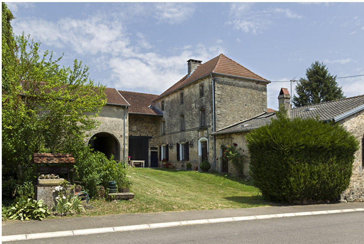
Maison et ferme, 11 rue des Marronniers. 70, Vougécourt
