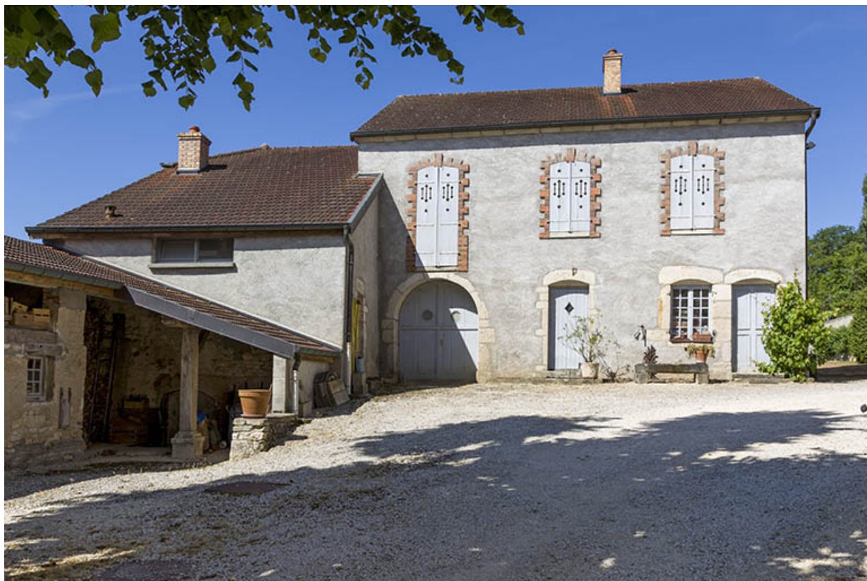
Vue générale de la ferme depuis l'entrée.
