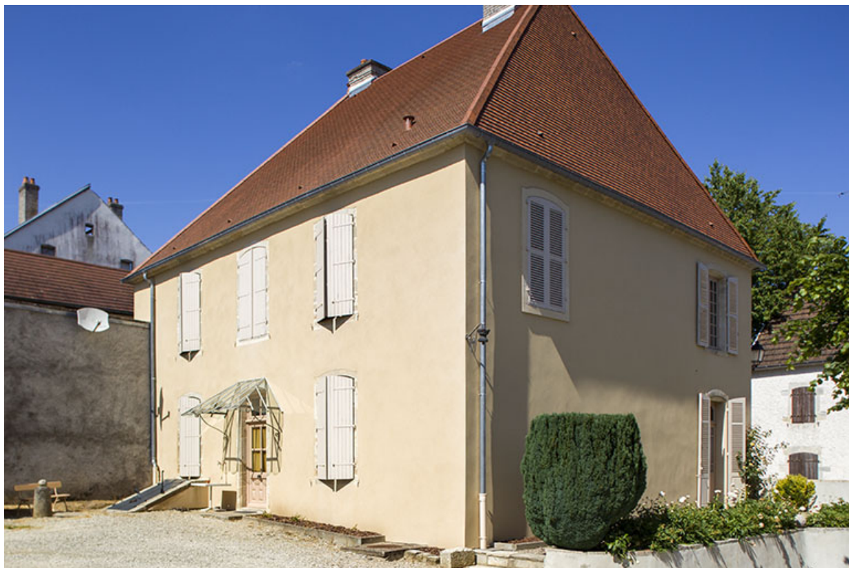
Façade postérieure de trois quart gauche.
