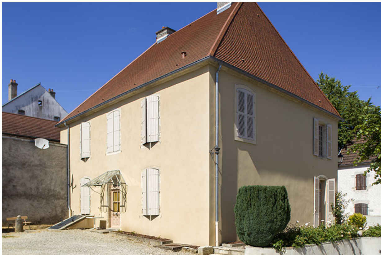
Façade postérieure de trois quart gauche.
