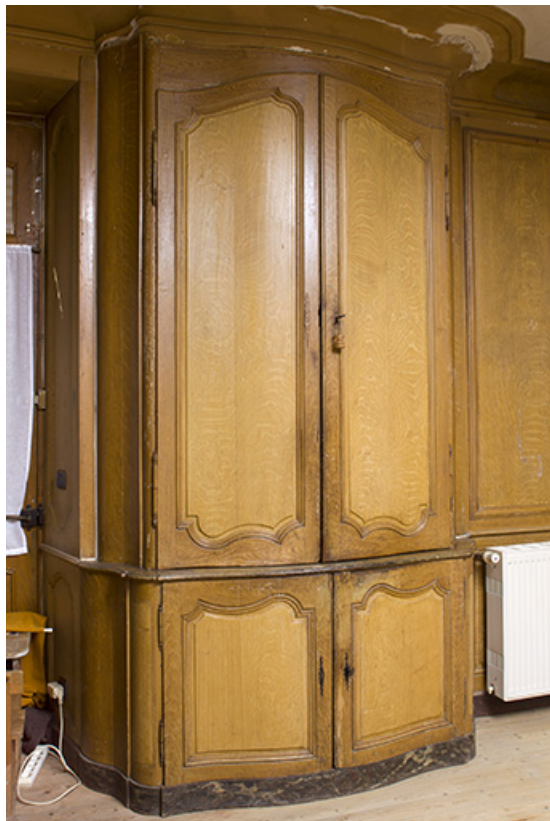
Intérieur : le buffet intégré dans les lambris de revêtement du salon. 70, Ray-sur-Saône, 8, 10 Grande Rue
