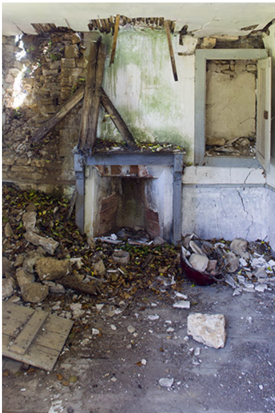
Intérieur du bâtiment : une pièce avec cheminée.
