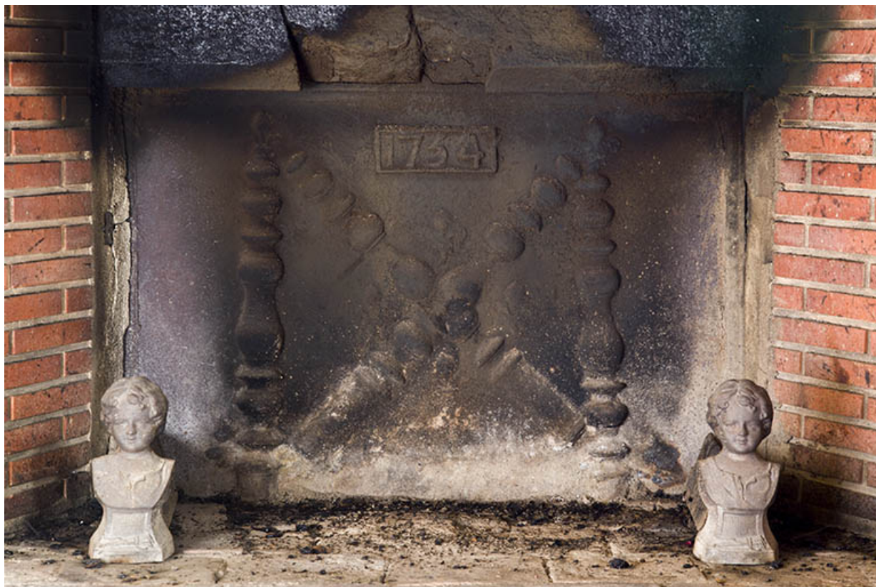
Intérieur : la plaque de cheminée du salon portant la date 1754.
