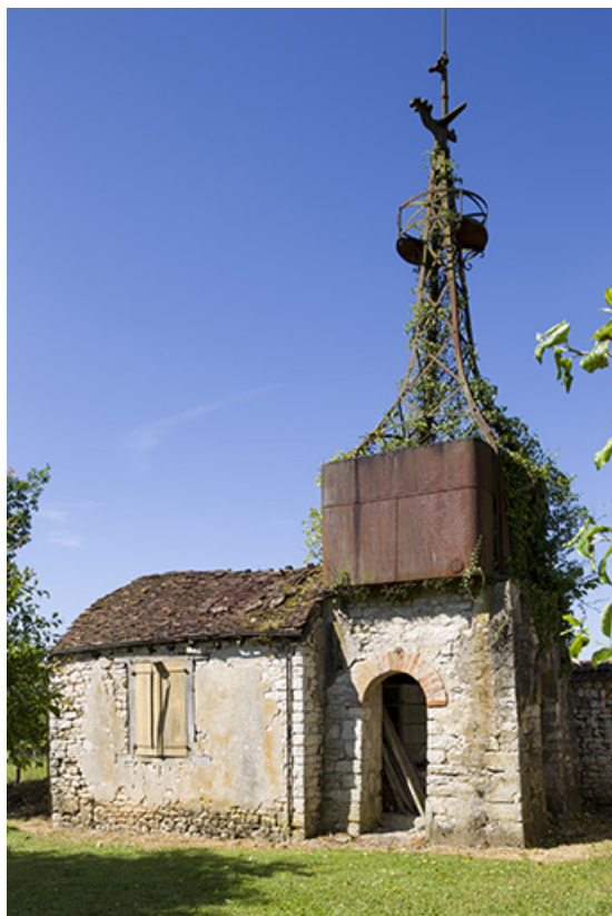
Vue rapprochée du bâtiment et de l'éolienne.
