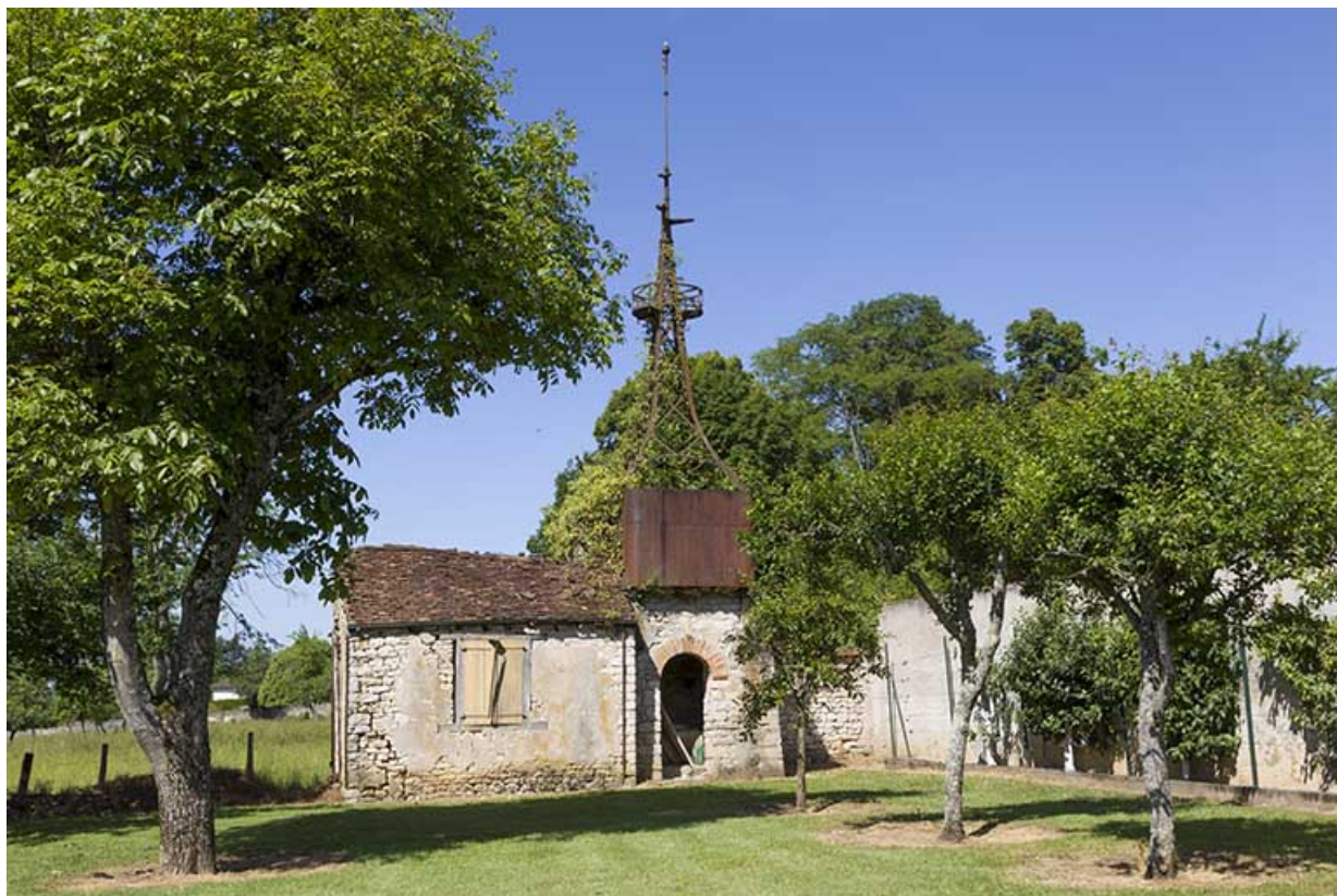
Bâtiment avec éolienne en fond de parcelle.
