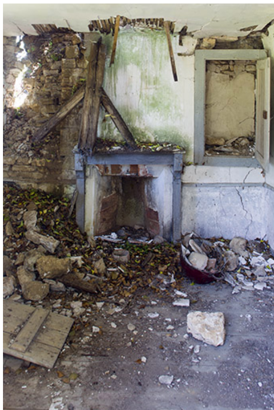
Intérieur du bâtiment : une pièce avec cheminée.
