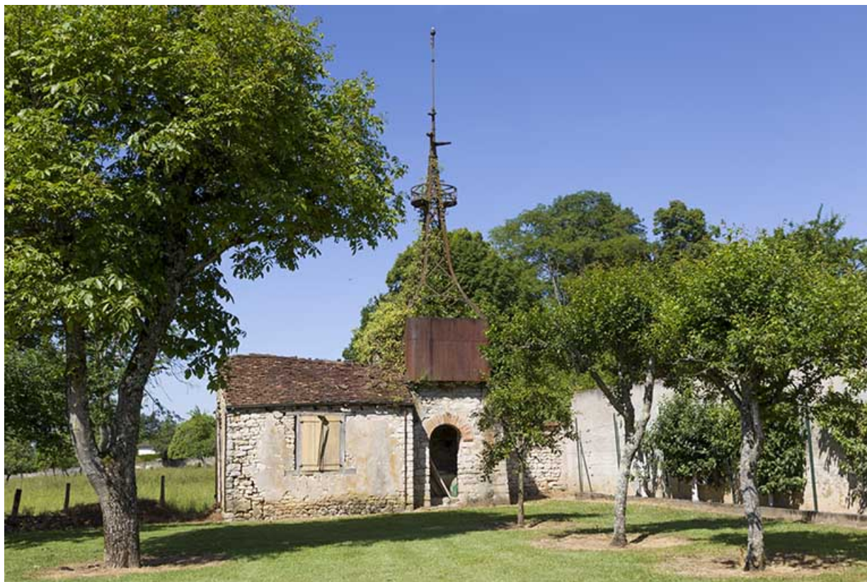
Bâtiment avec éolienne en fond de parcelle.
