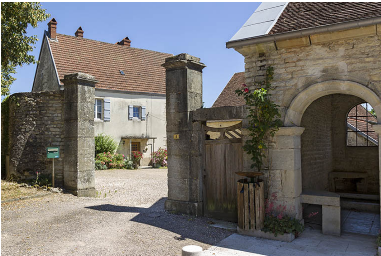
Vue générale depuis la place de l'Eglise.
