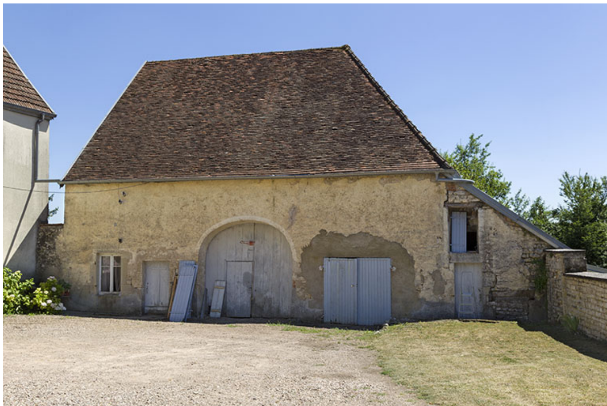
Vue générale du bâtiment agricole sur cour.
