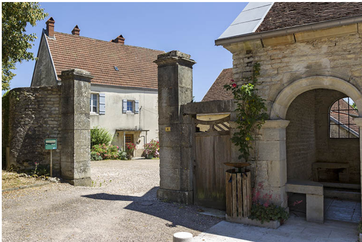
Vue générale depuis la place de l'Eglise.
