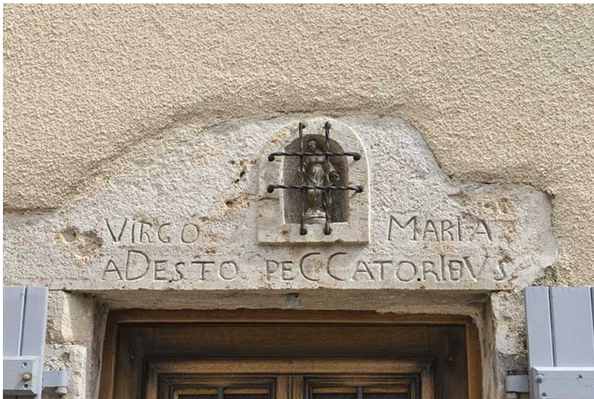
Date portée inscrit sur le linteau de la porte d'entrée.
