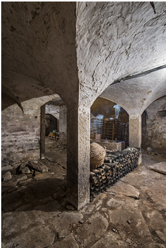
Détail d'une colonne supportant les voûtes. 70, Purgerot rue de la Fontaine carrée
