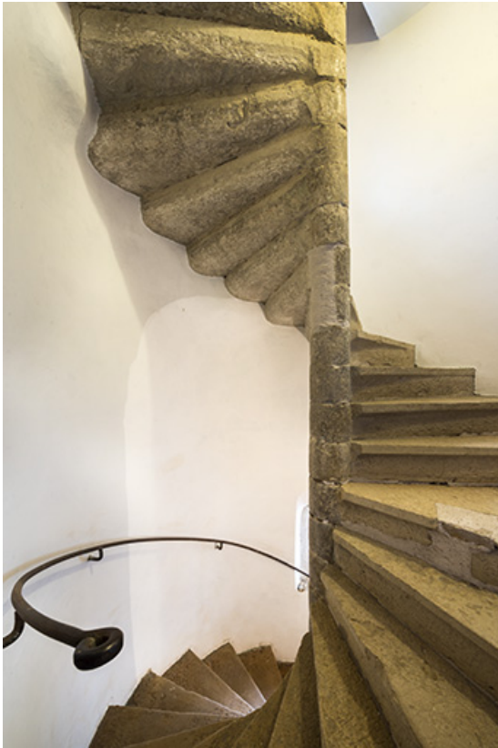
L'escalier à vis dans la tour.
