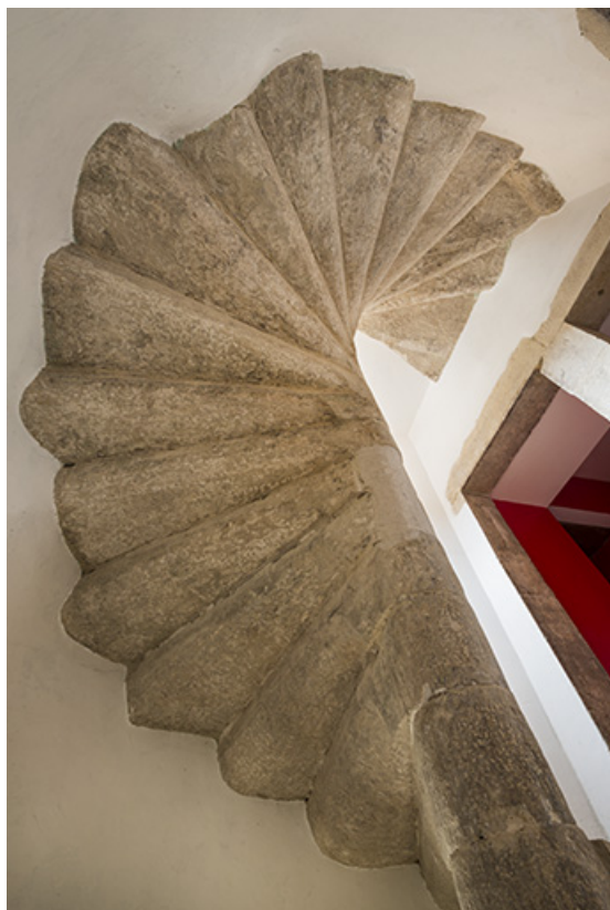
Vue en contre-plongée de l'escalier.
