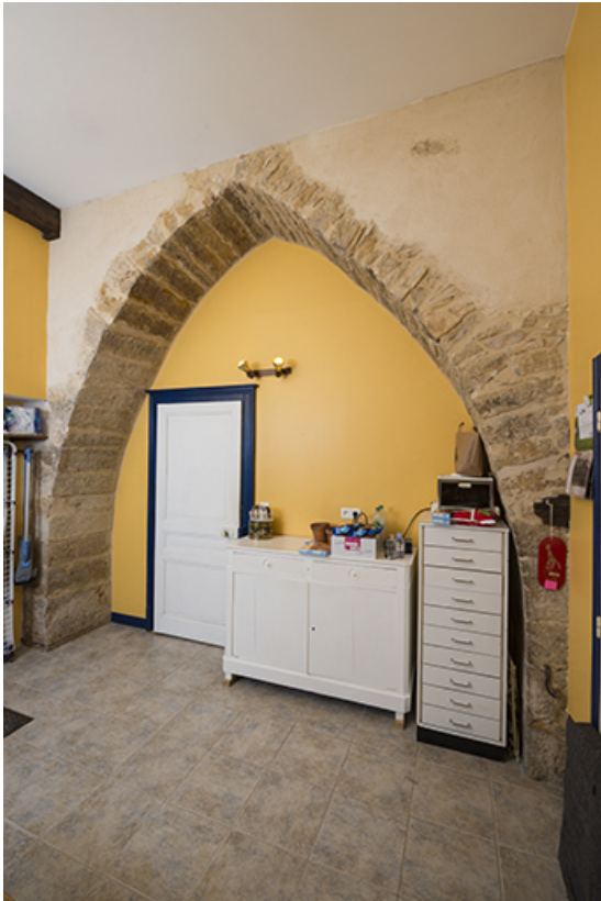
Voûte en tiers-point, arrière cuisine. 70, Purgerot rue de la Fontaine carrée
