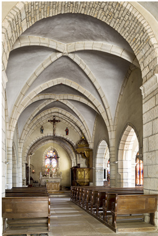
Intérieur : la nef vue de trois quart depuis l'entrée.
