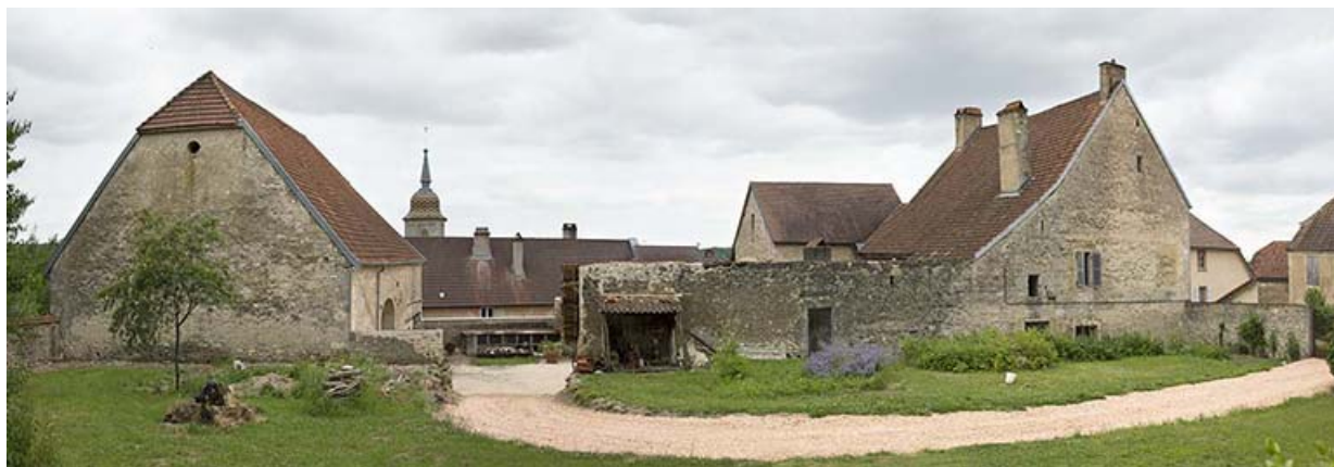
Vue générale des bâtiments autour de la cour : grange à gauche et demeure à droite.
