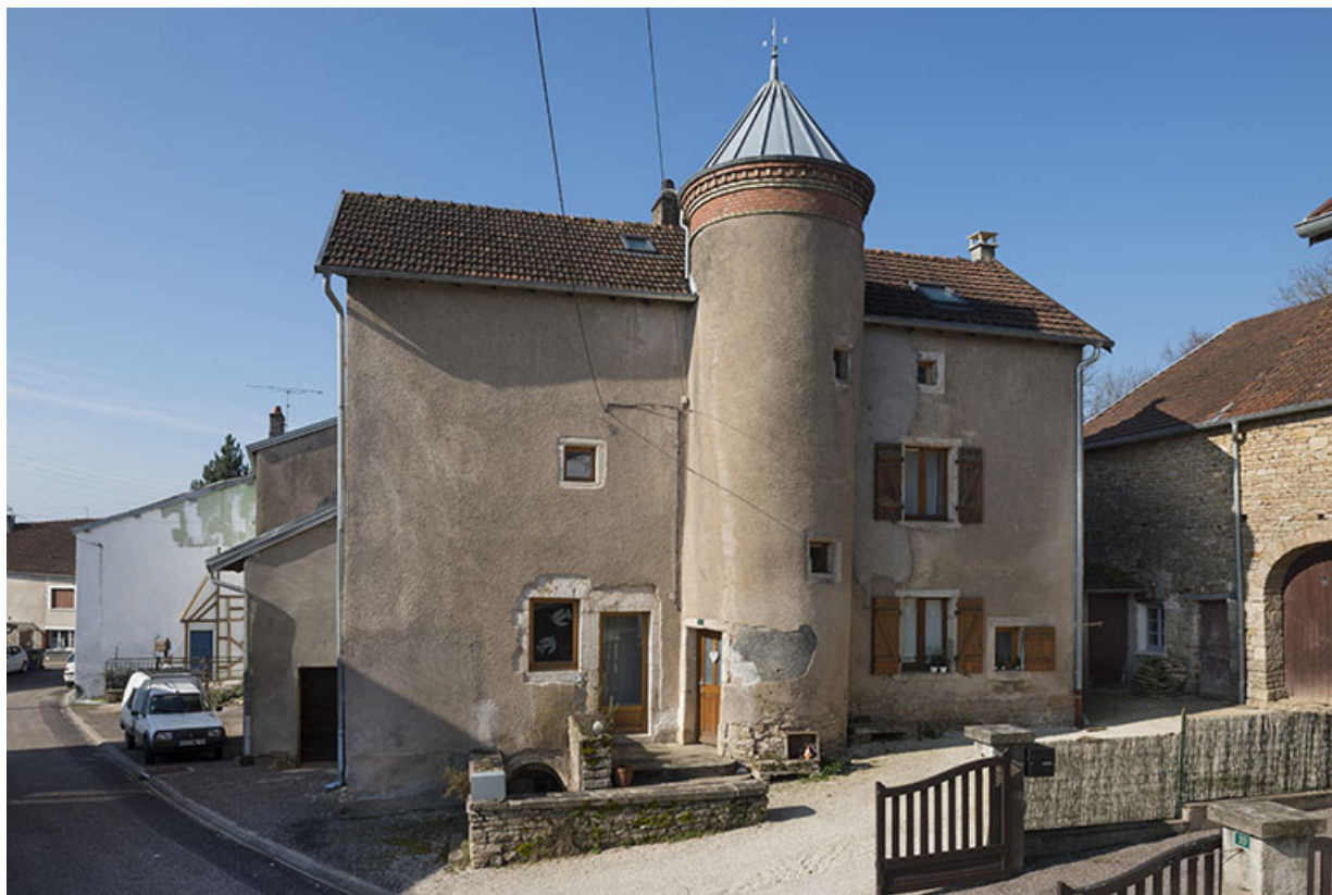
Façade antérieure de la maison.
