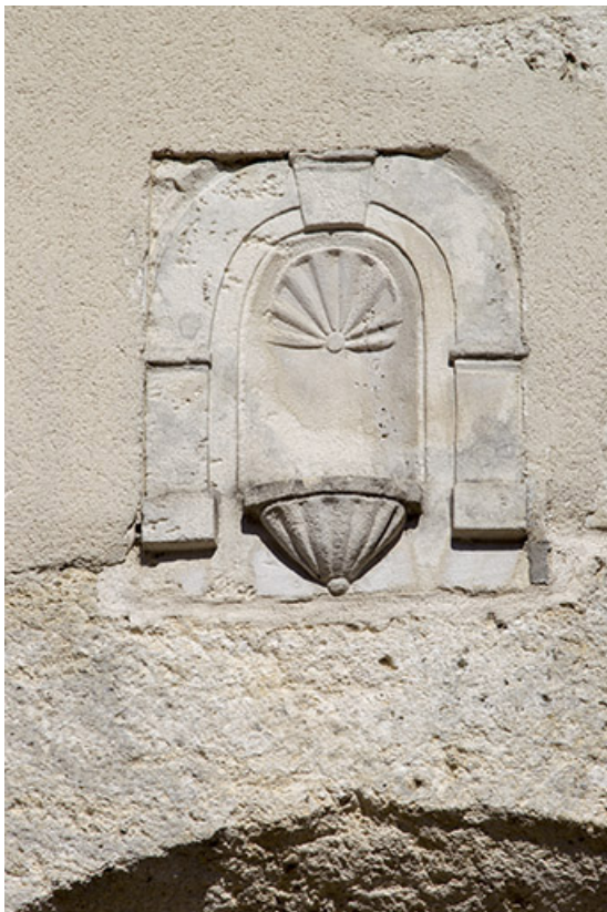
Ferme ? Grande Rue : détail de la niche décorée d'une coquille. 70, Ray-sur-Saône
