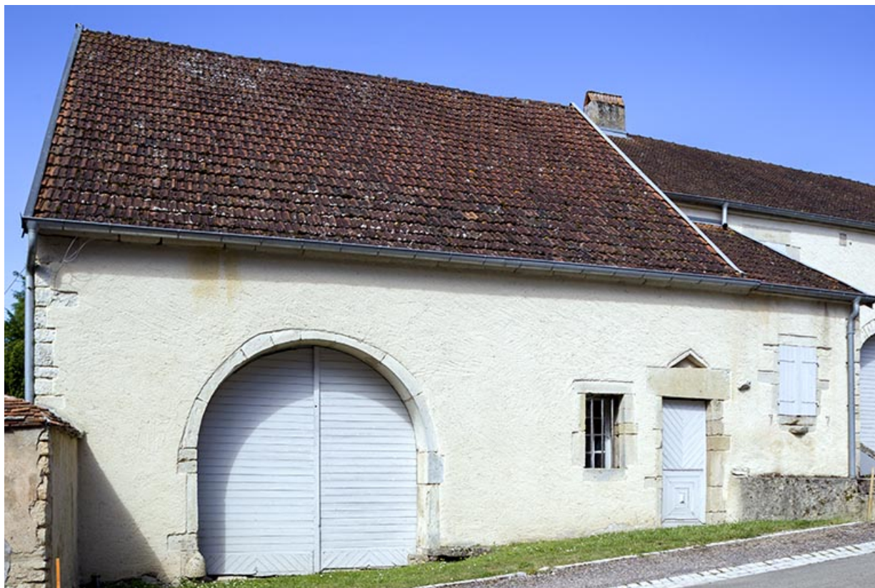
Ferme bloc à deux travées, 11 rue du Château. 70, Ray-sur-Saône
