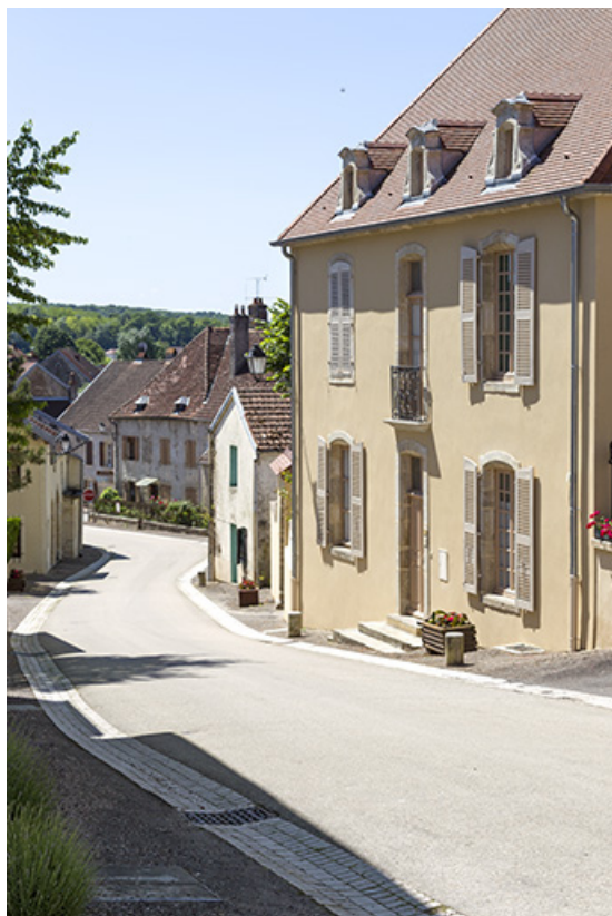
Demeure 8 et 10 Grande Rue, et vue partielle de la Grande Rue en direction du bas du village. 70, Ray-sur-Saône
