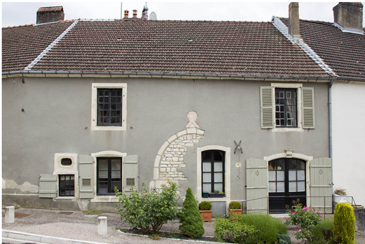
Maison 4 place Gabrielle de Salvarte, vue rapprochée de la façade antérieure. 70, Ray-sur-Saône
