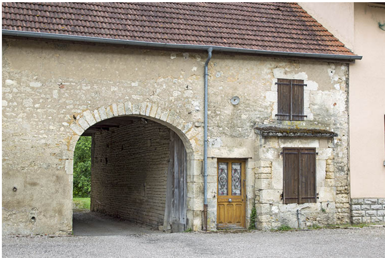
Ferme bloc au 37 Grande Rue : la grange et le logis, qui se distingue par une avancée (la "souillarde") contenant l'évier. 70, Ray-sur-Saône
