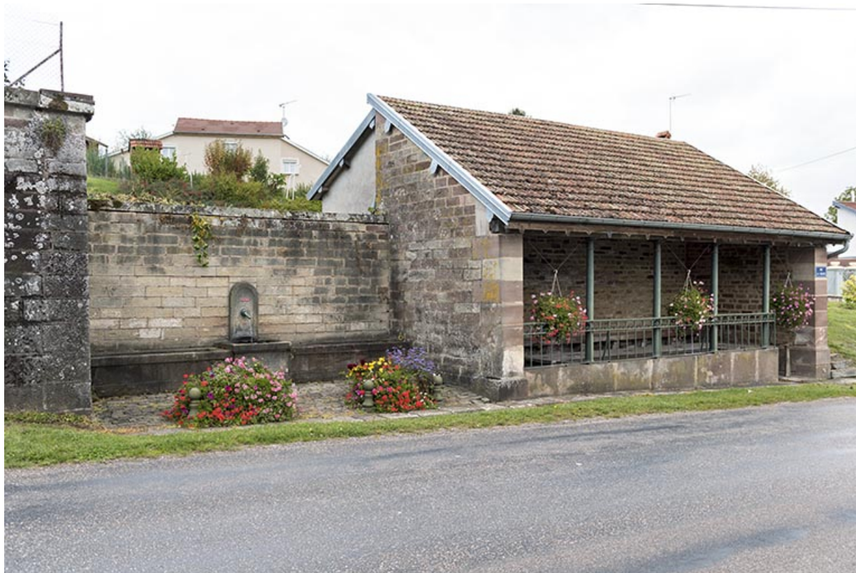
Fontaine-lavoir, rue de la Tuilerie.
