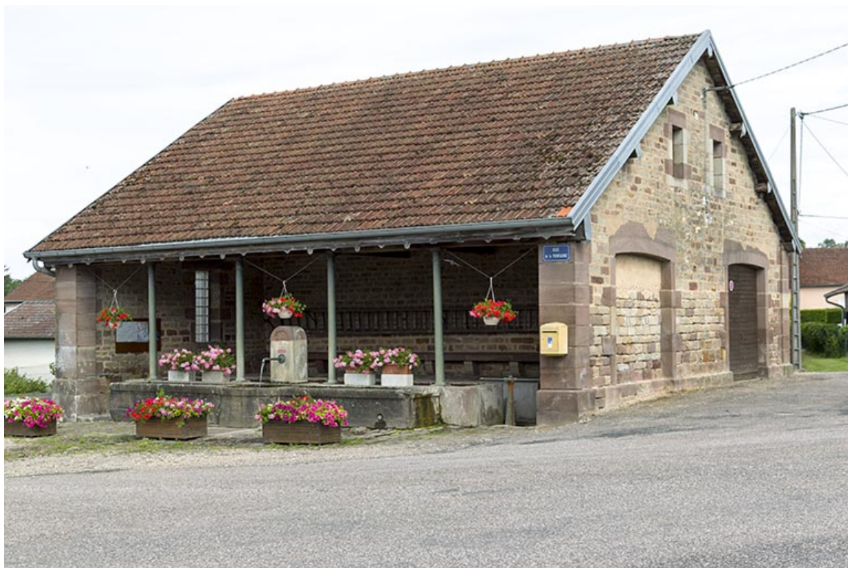
Fontaine-lavoir, rue de la Fontaine.
