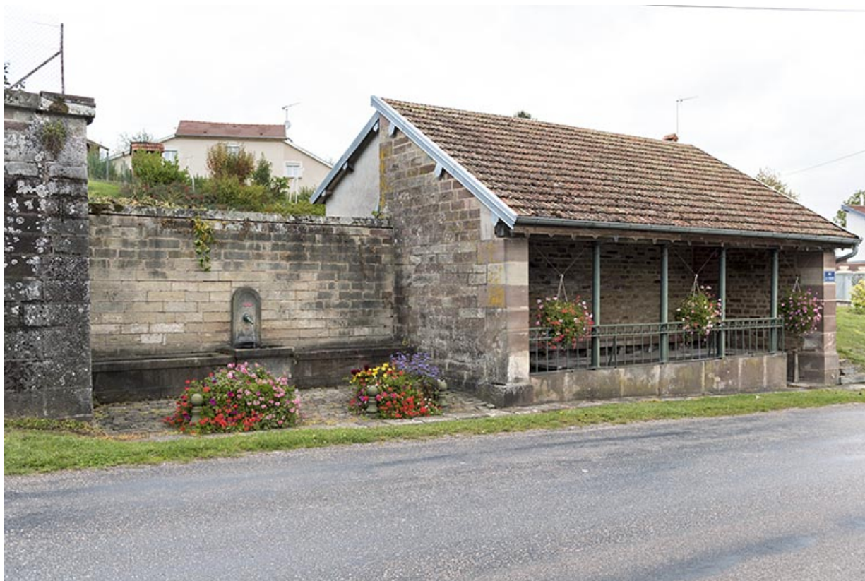
Fontaine-lavoir, rue de la Tuilerie.
