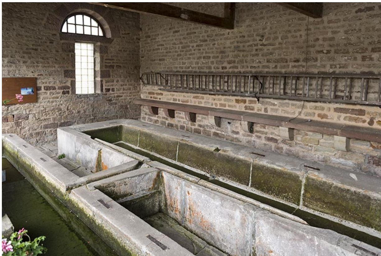
Bassins du lavoir.
