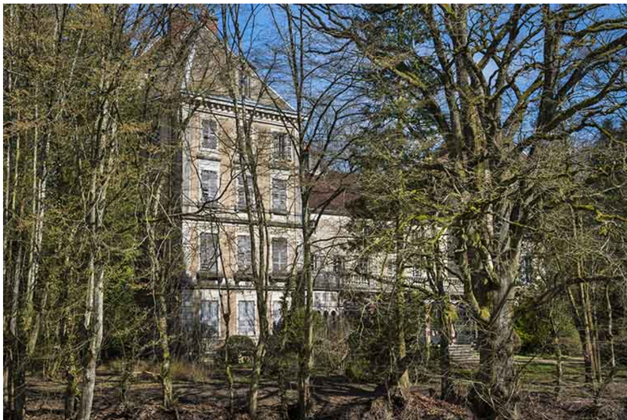
Le pavillon occidental, façade sud-ouest. 70, Conflandey
