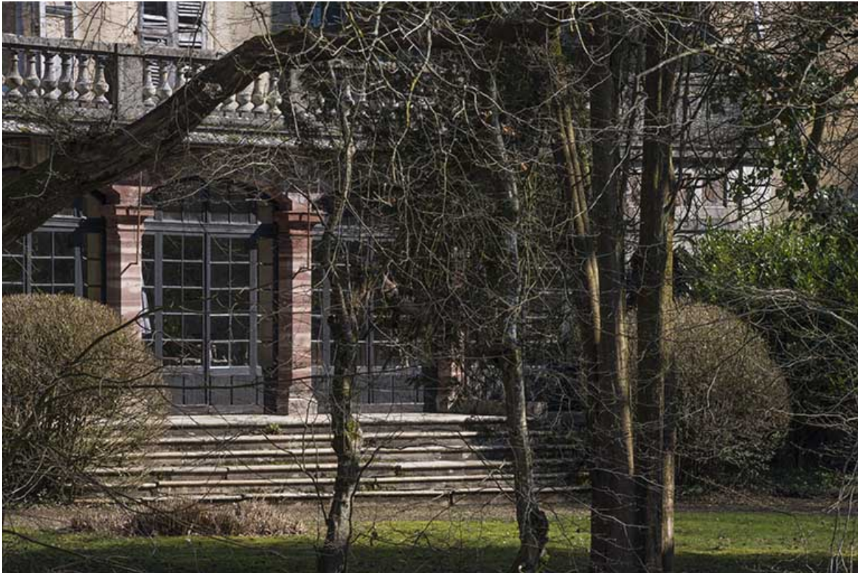
Détail du rez-de-chaussée, façade sud-ouest. 70, Conflandey
