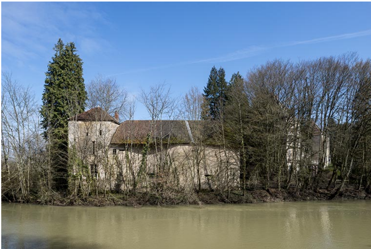
Communs du château, vue depuis la rue du Moulin rouge. 70, Conflandey
