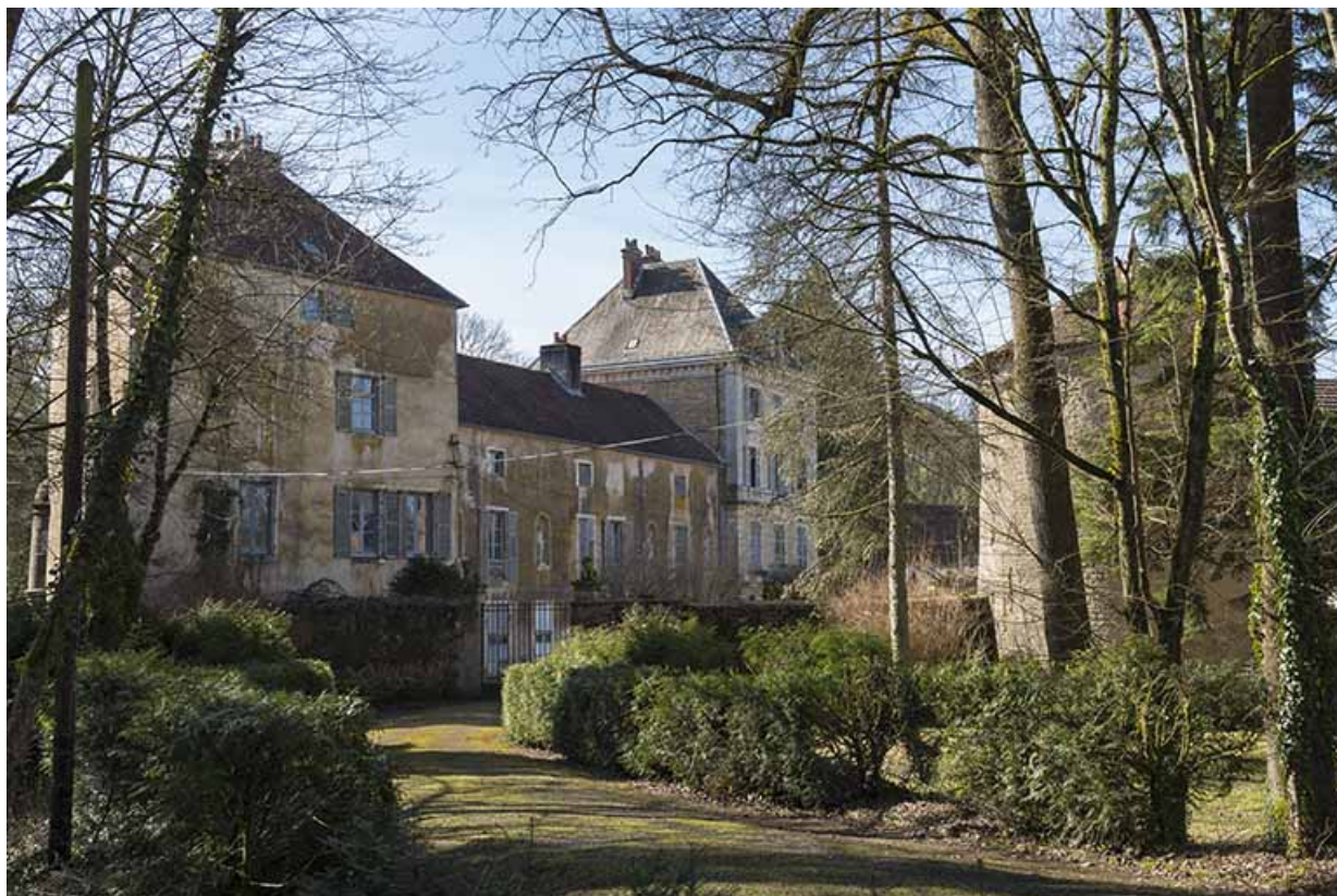
Le corps de logis et ses deux pavillons.
