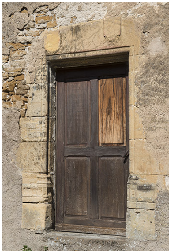
Porte latérale, façade sud.
