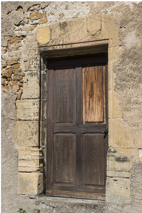
Porte latérale, façade sud.
