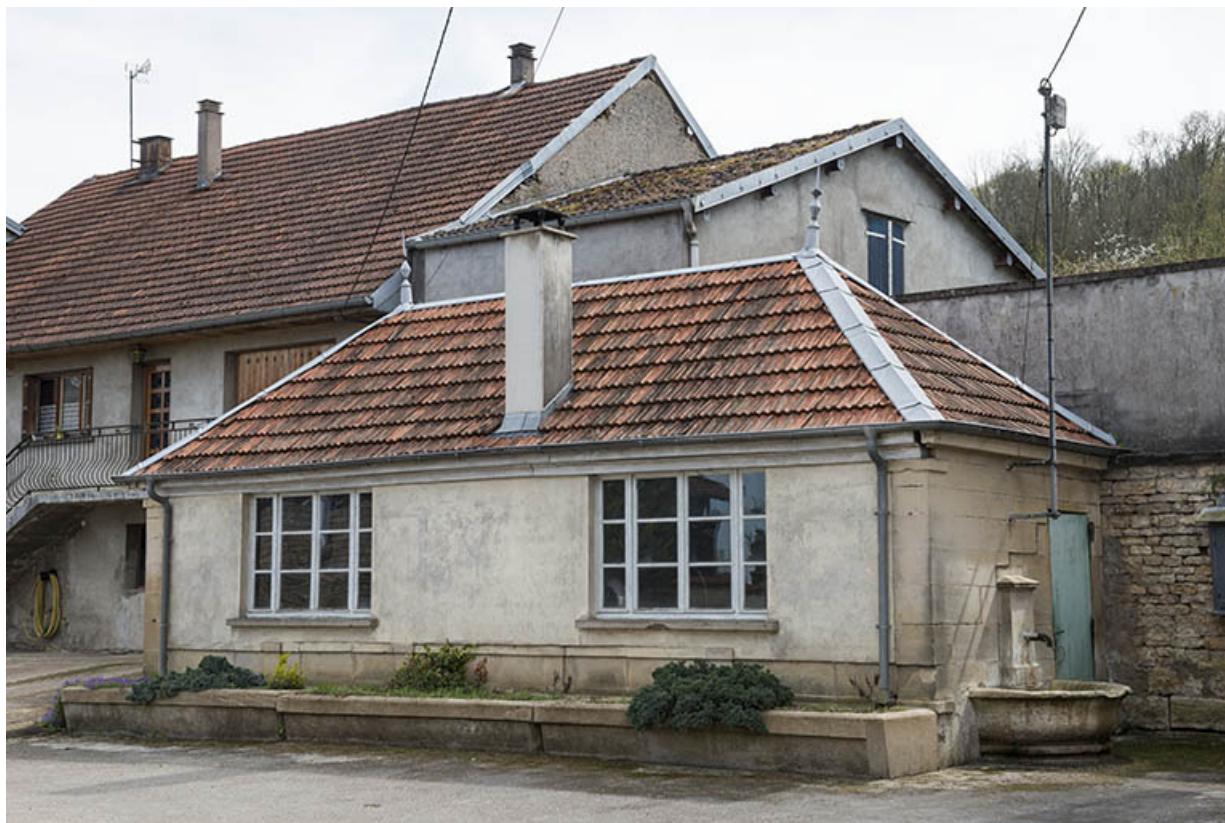
Ancien lavoir transformé en remise.
