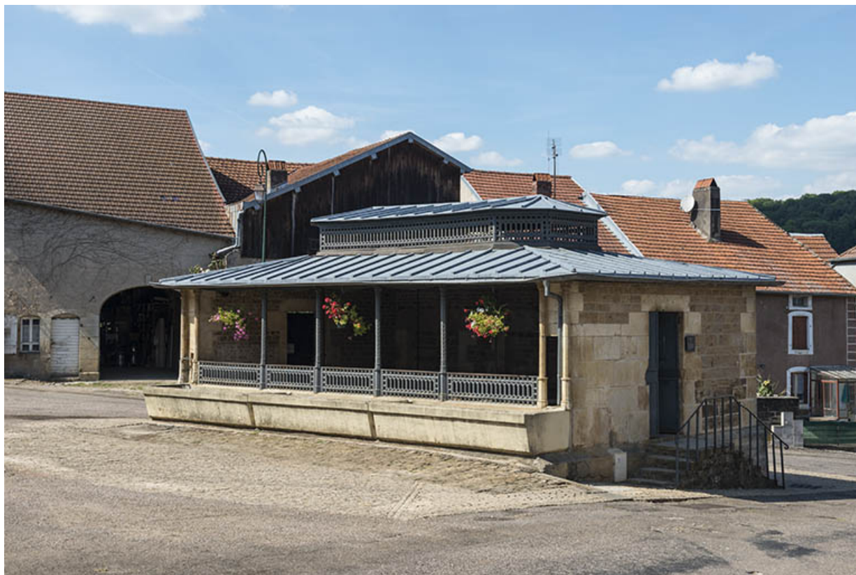
Fontaine-lavoir, rue du Vaux.
