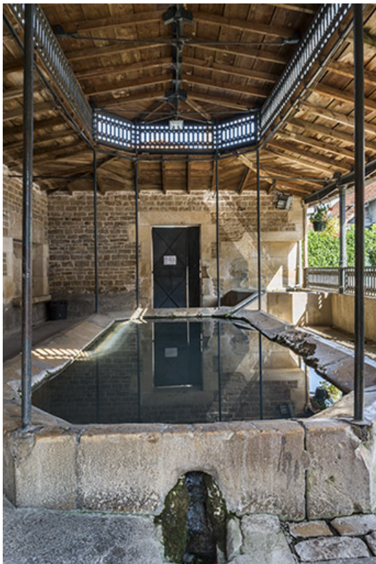
Le bassin du lavoir.
