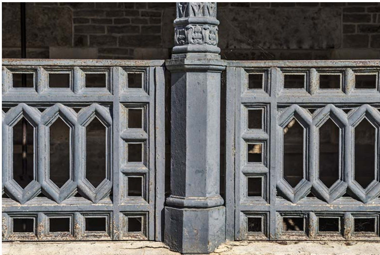
Détail du garde-corps et d'une colonne.
