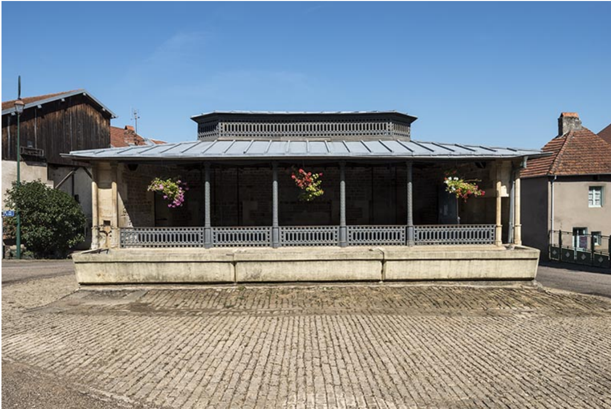
La façade antérieure de l'édifice.
