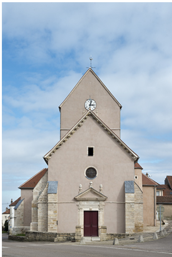
La façade occidentale. 70, Purgerot Grande Rue
