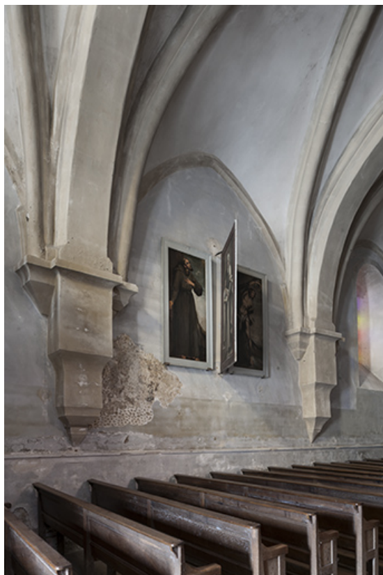
Une des trois travées de la nef.
