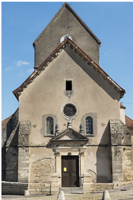
Vue avant restauration (2016).
