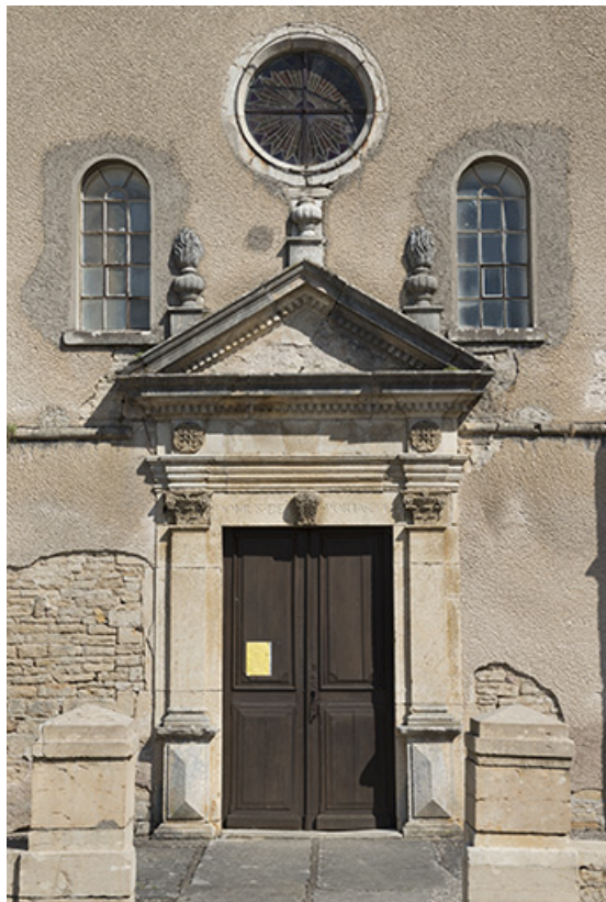
Vue avant restauration (2016).
