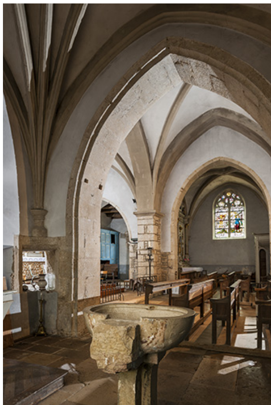
Vue depuis la chapelle latérale nord.
