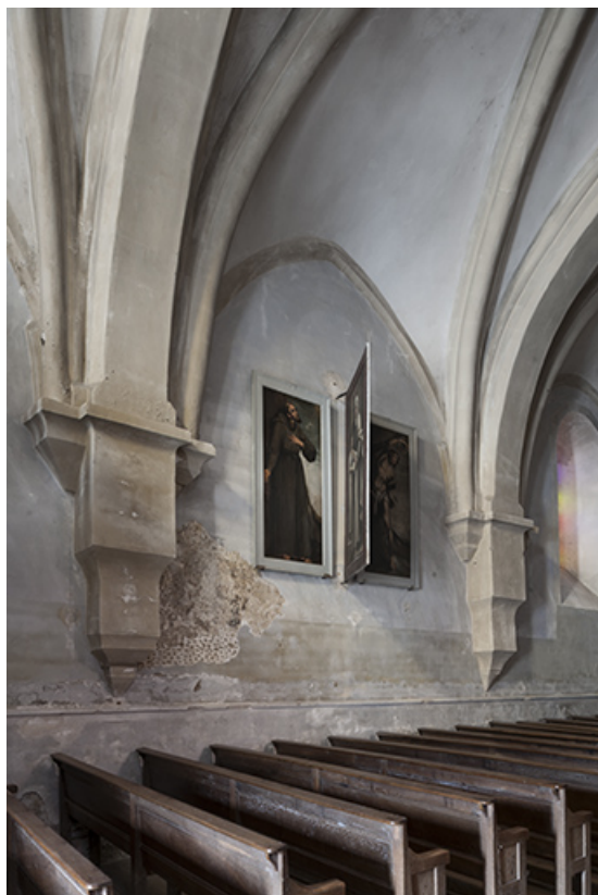
Une des trois travées de la nef.
