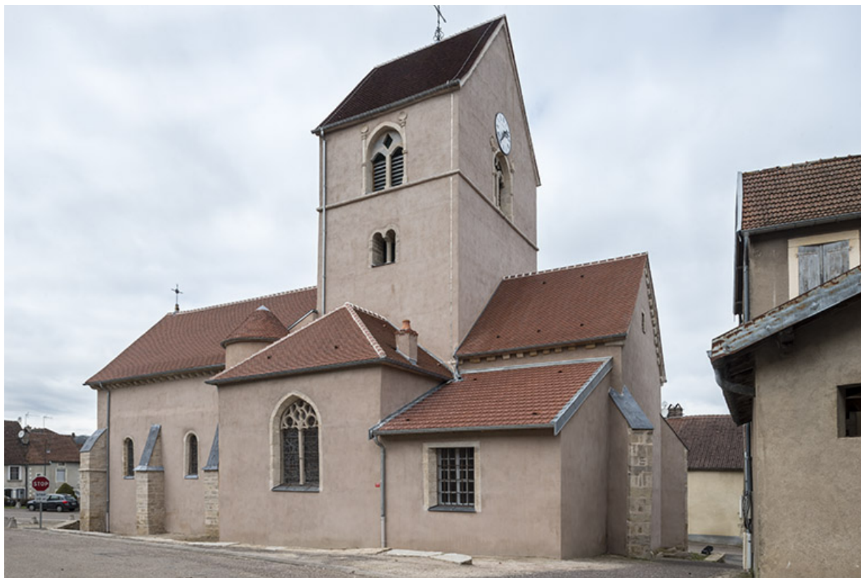
Vue latérale depuis la rue des Ecoles.
