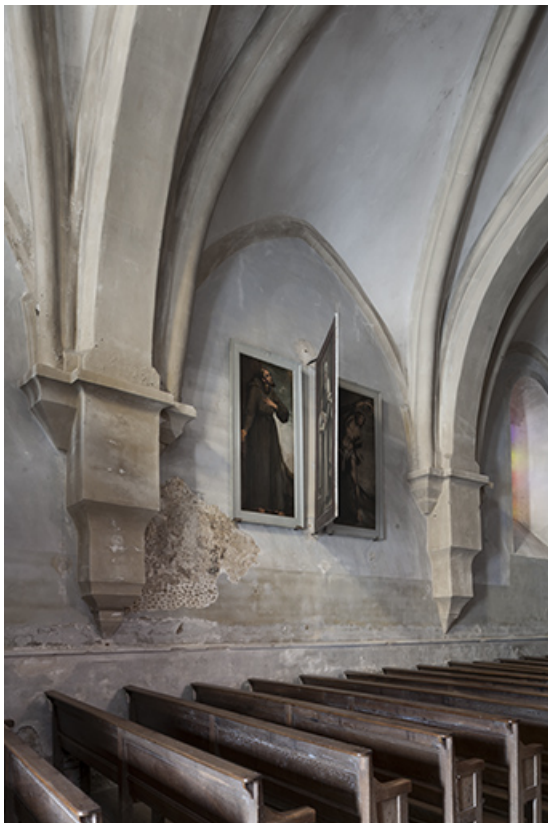
Une des trois travées de la nef.
