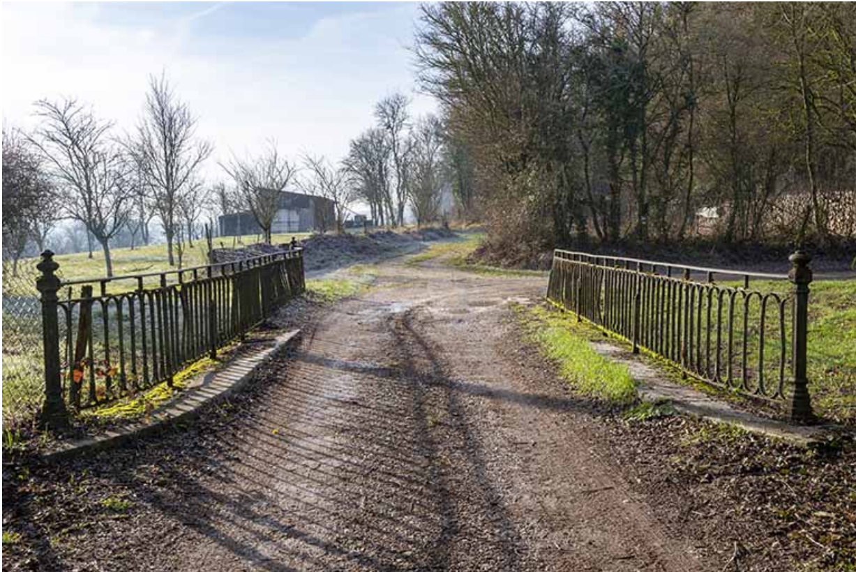
Pont franchissant la tranchée de la voie ferrée (aujourd'hui comblée) dans le quartier de l'Église. 70, Sceaux-sur-Saône-et-Saint-Albin
