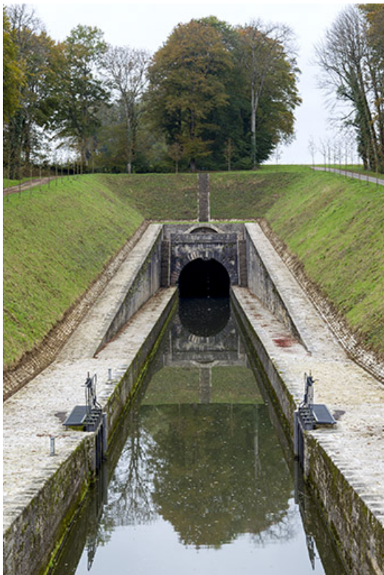
Entrée amont du tunnel de Saint-Albin.
