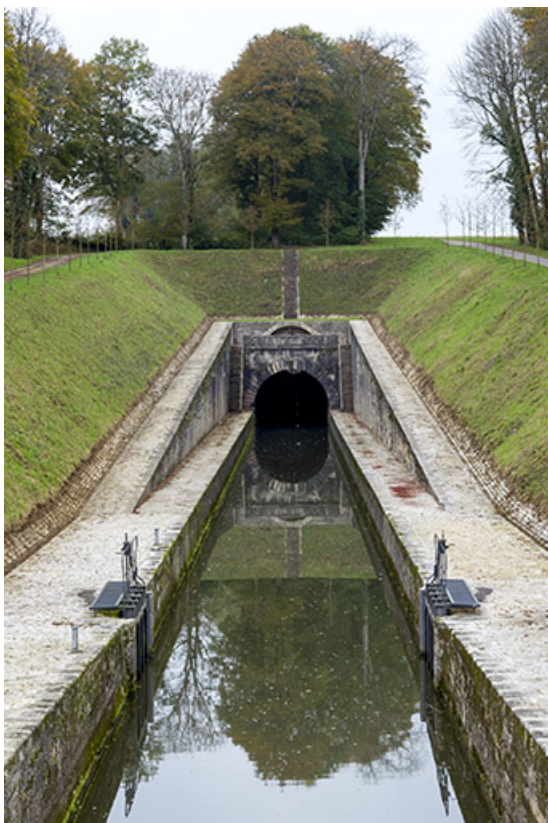
Entrée amont du tunnel de Saint-Albin.
