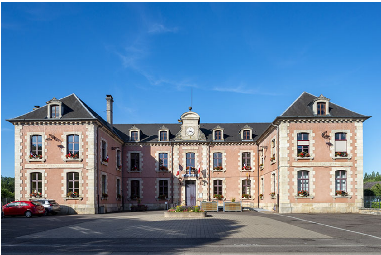
Maison commune, justice de paix et école de la seconde moitié du 19e siècle. 70, Scey-sur-Saône-et-Saint-Albin
