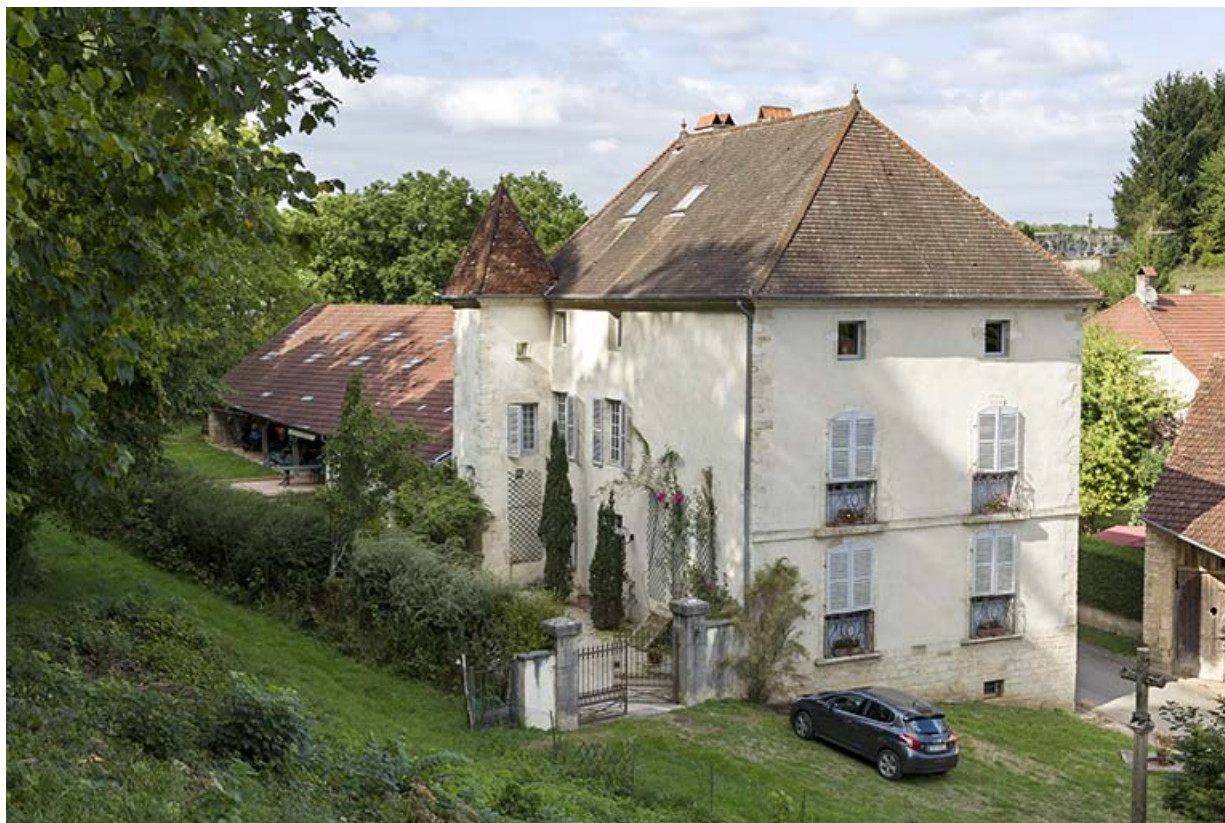
Vue générale de trois quart de la façade antérieure, avec la tourelle et l'ancien "grangeage". 70, Rupt-sur-Saône, 3 rue de la Garenne
