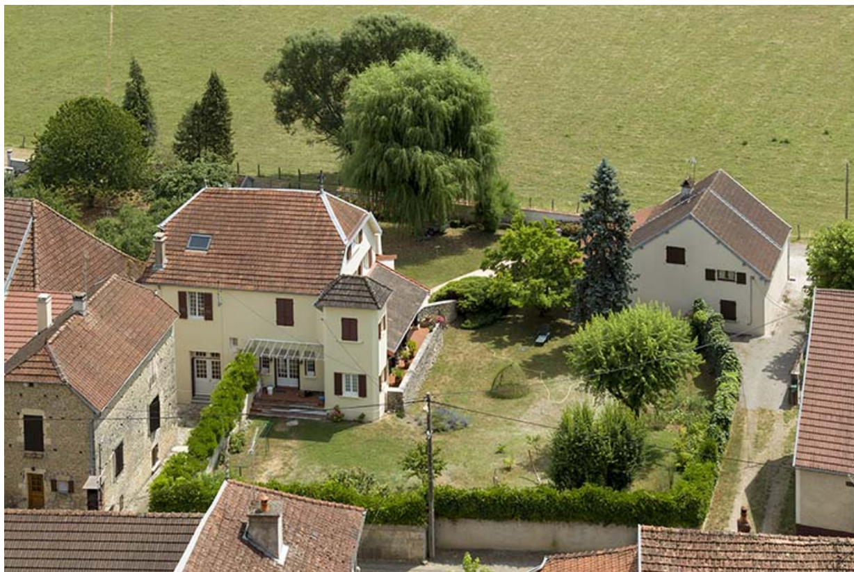
Vue plongeante sur le logement patronal (à gauche).
