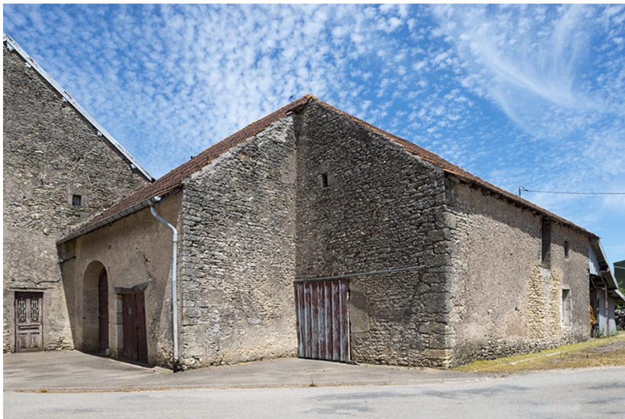
Ferme à l'angle du chemin de défrèvement des Vergers.
