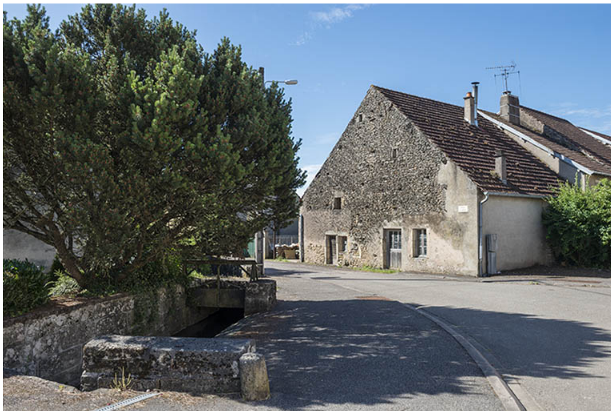
Vue générale de la ferme située à l'angle de l'impasse du château. 70, Ferrières-lès-Scey
