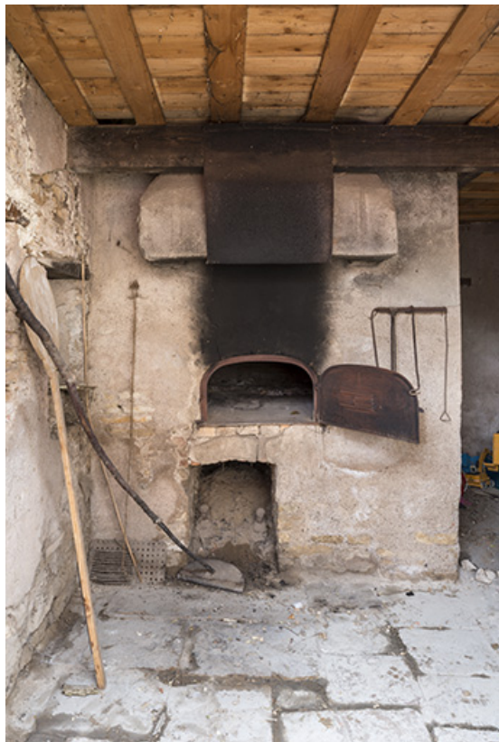
Four à pain, ferme située 10 rue de la Prairie. 70, Ferrières-lès-Scey
