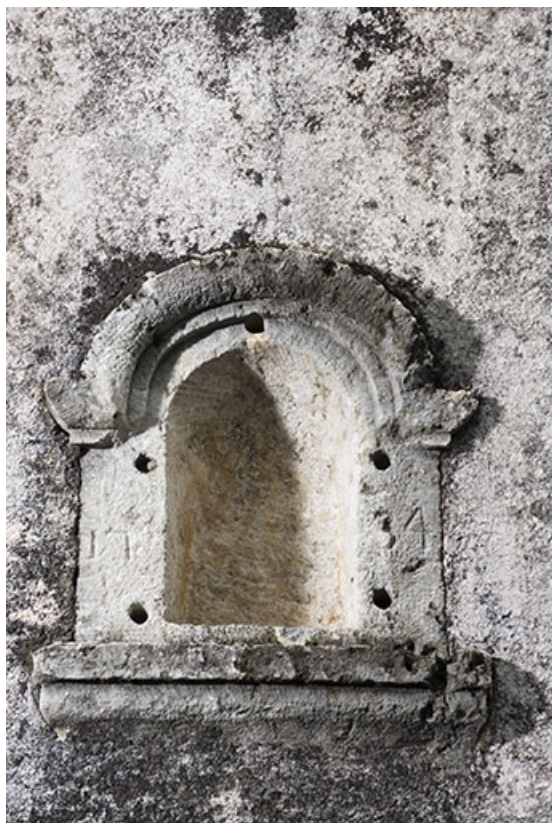
date portée, rue de la Prairie.
