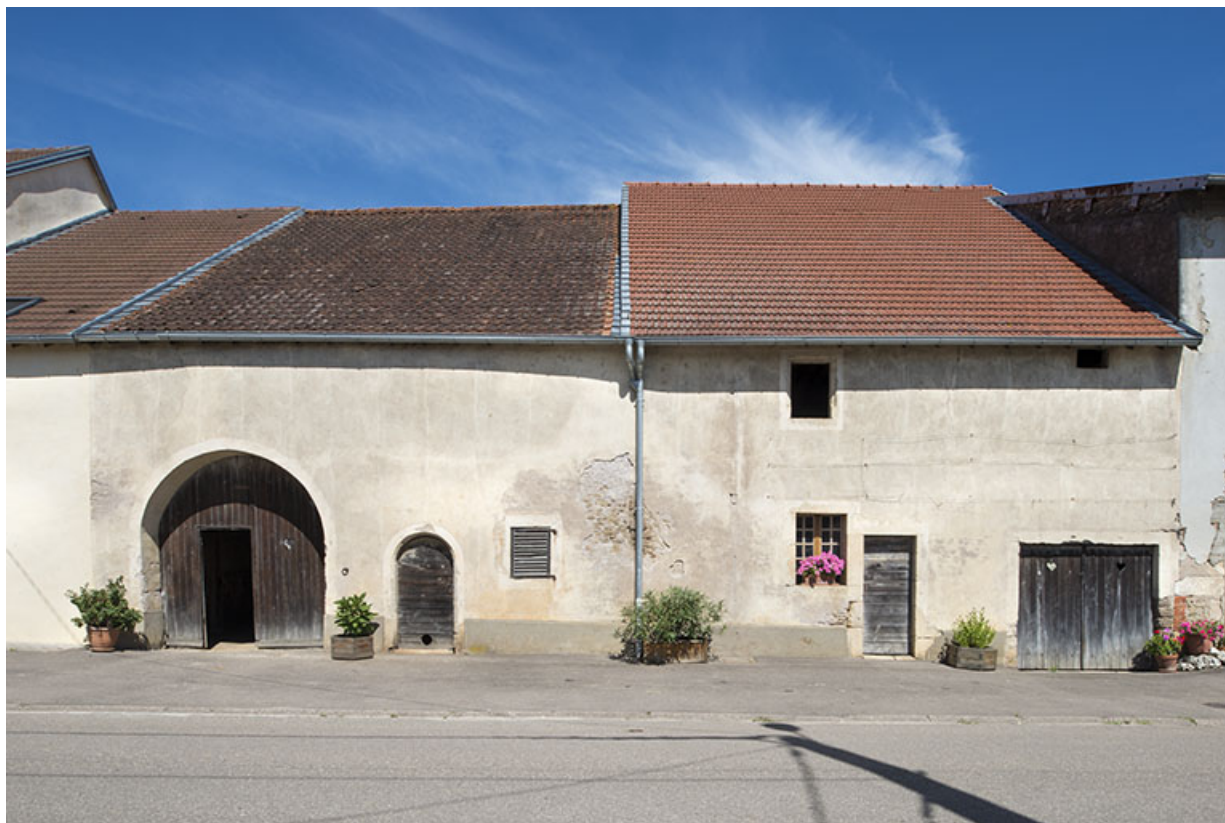
Fermes bordant la route de Scey-sur-Saône. 70, Ferrières-lès-Scey
