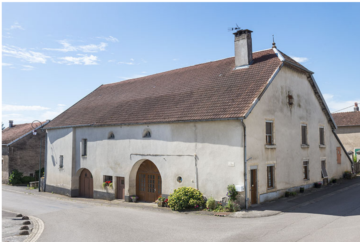
Vue d'ensemble de la ferme située au n°2 route de Scey-sur-Saône. 70, Ferrières-lès-Scey
