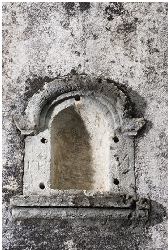
date portée, rue de la Prairie.
