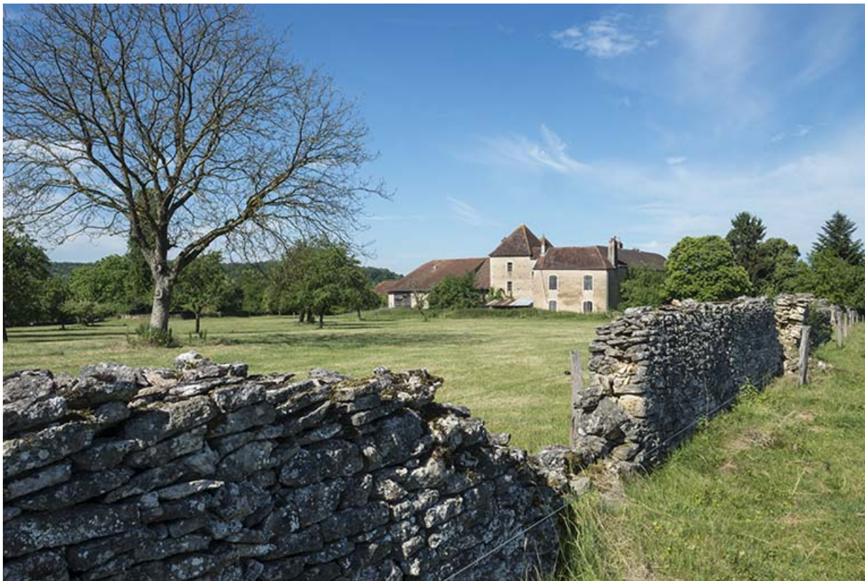
La façade orientale de la maison forte.
