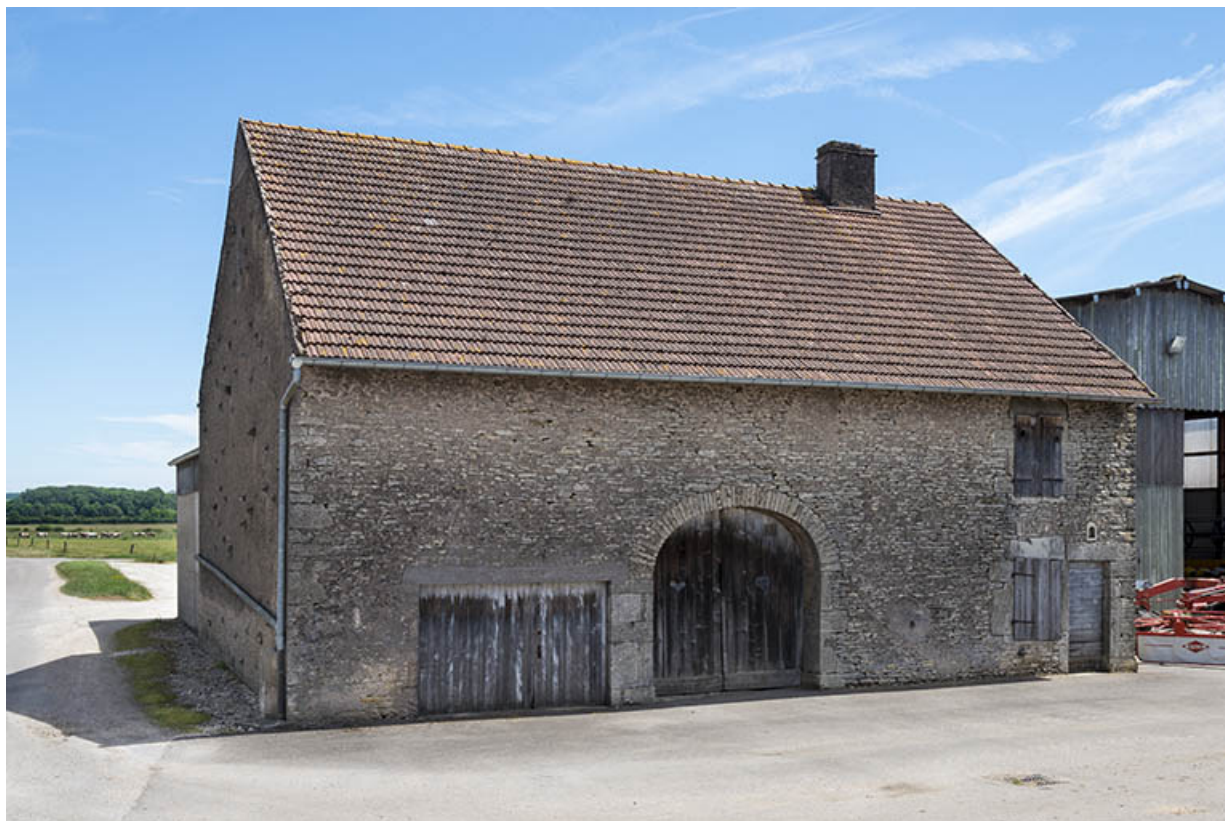
Ferme située à l'extrémité du chemin de défrèvement des Vergers. 70, Ferrières-lès-Scey
