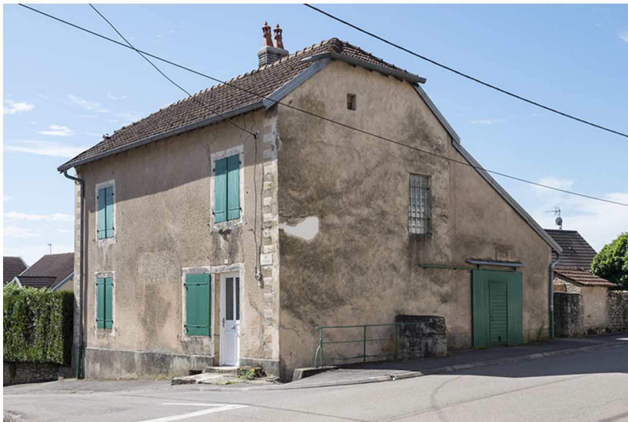
L'ancienne maison commune, située à l'angle de la rue de Scey-sur-Saône et de la rue du Tilleul. 70, Ferrières-lès-Scey route de Port-sur-Saône
