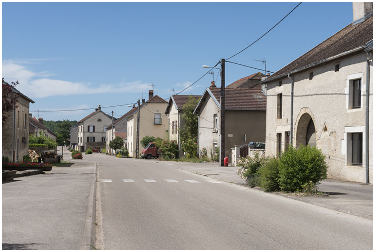
La route de Port-sur-Saône bordée de fermes. 70, Ferrières-lès-Scey
