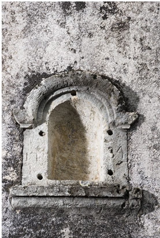
date portée, rue de la Prairie.
