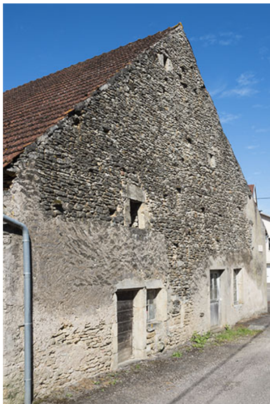
Mur pignon de la ferme située à l'angle de l'impasse du Château. 70, Ferrières-lès-Scey
