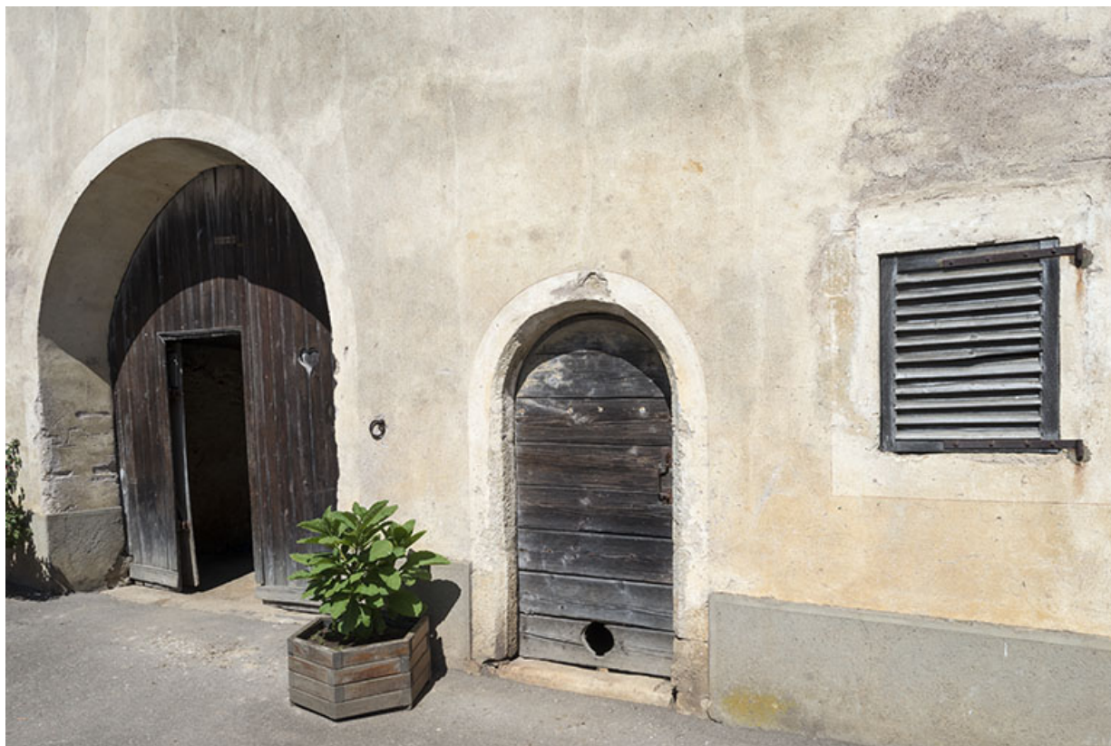
Entrées de ferme située route de Scey-sur-Saône. 70, Ferrières-lès-Scey
