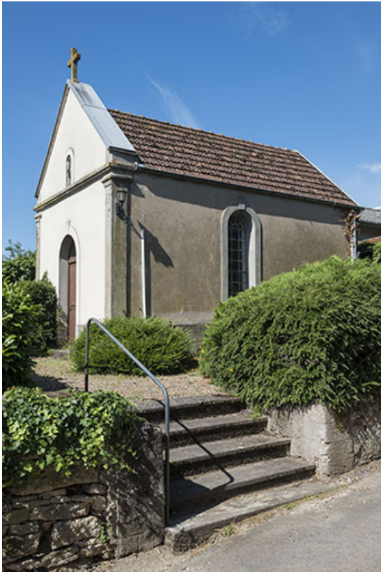
Vue générale de la chapelle et son accès depuis la rue de la Fontenotte. 70, Ferrières-lès-Scey rue de la Foutenotte
