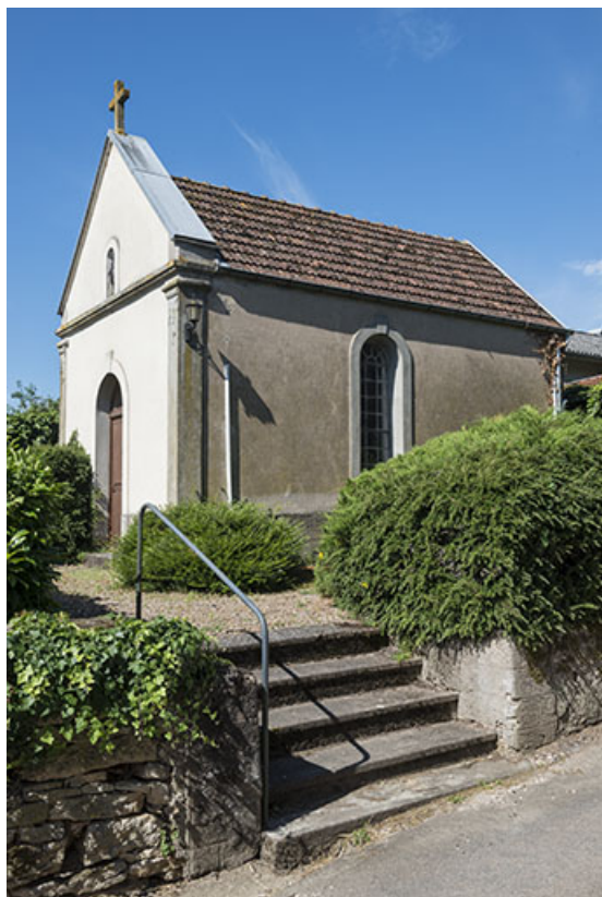
Vue générale de la chapelle et son accès depuis la rue de la Fontenotte. 70, Ferrières-lès-Scey rue de la Foutenotte
