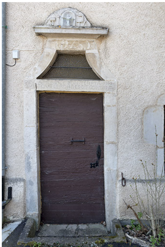
Porte, n°8 rue de la Rezelle. 70, Port-sur-Saône
