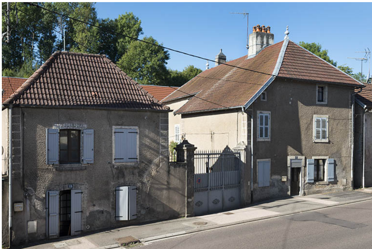
Ancienne ferme située en face de la chapelle. 70, Port-sur-Saône
