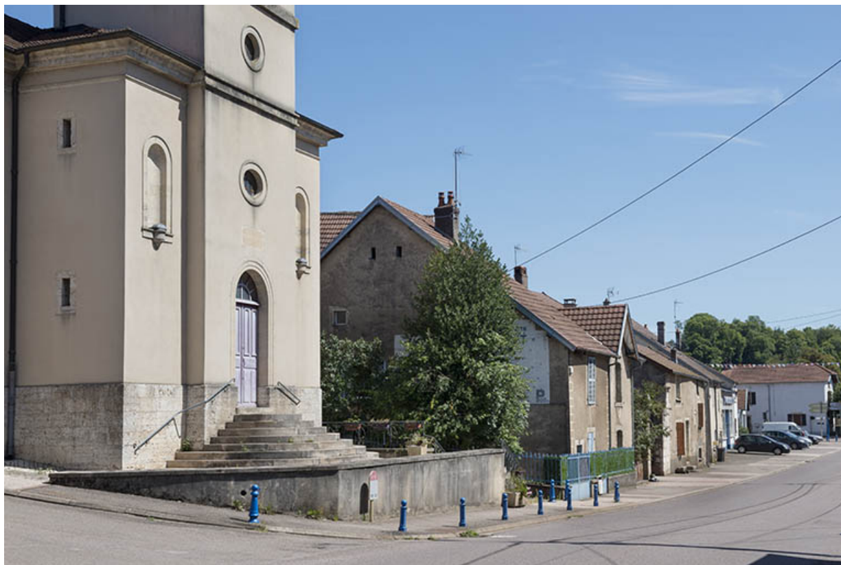
La façade antérieure de la chapelle et la rue Saint-Valère. 70, Port-sur-Saône
