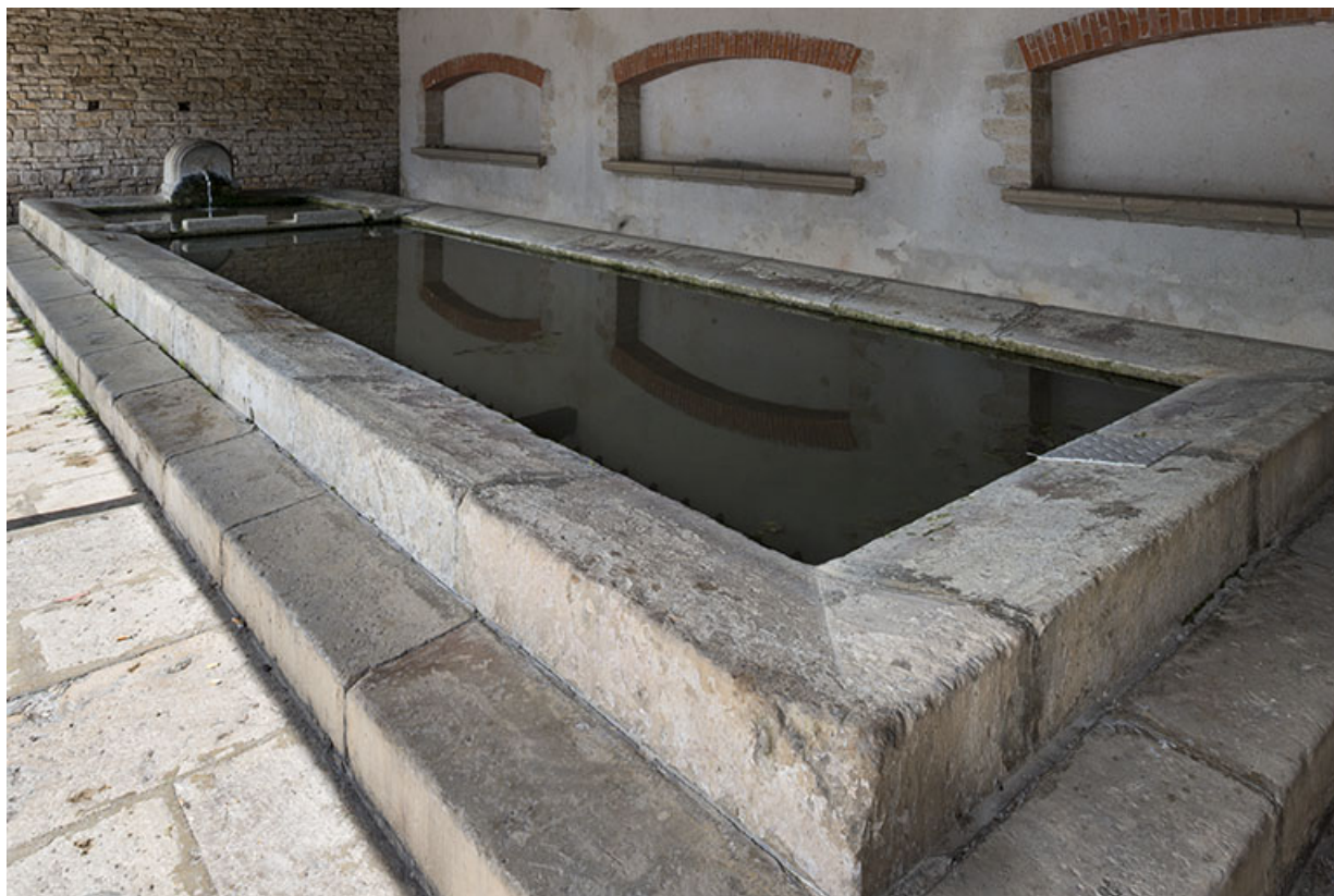
Bassin du lavoir. 70, Port-sur-Saône
