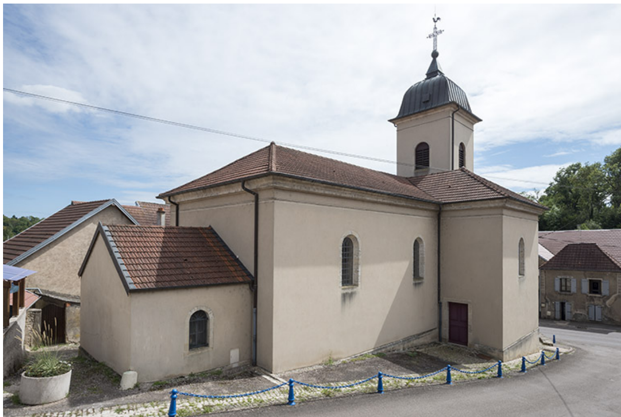
La chapelle, vue latérale.
