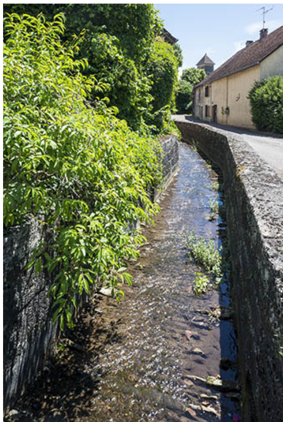
Le ruisseau canalisant traversant le village. 70, Ferrières-lès-Scey
