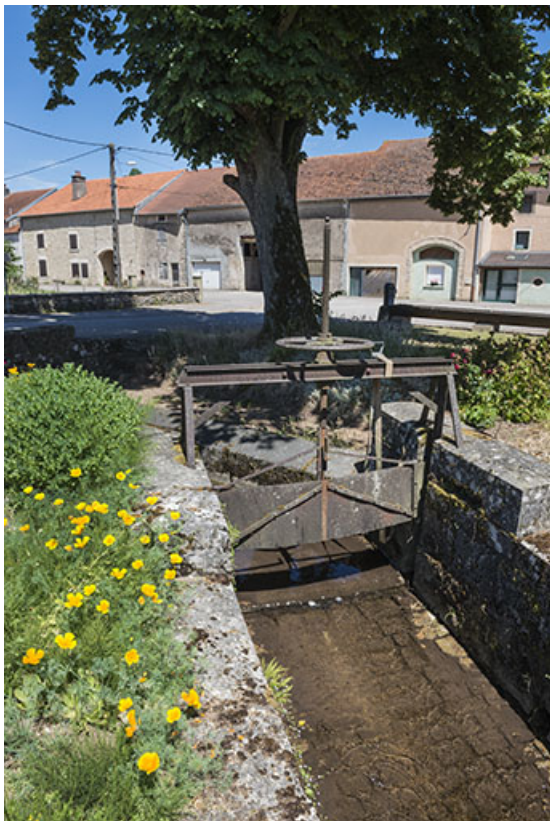
Vanne située à l'extrémité sud du village.
