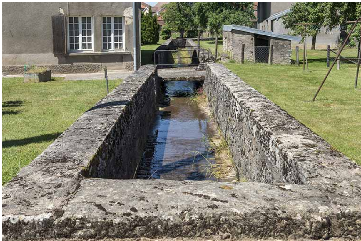
Le ruisseau canalisé qui traverse le village.
