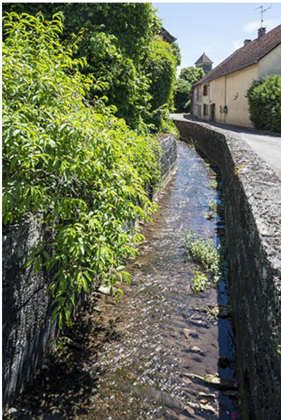
Le ruisseau canalisant traversant le village. 70, Ferrières-lès-Scey
