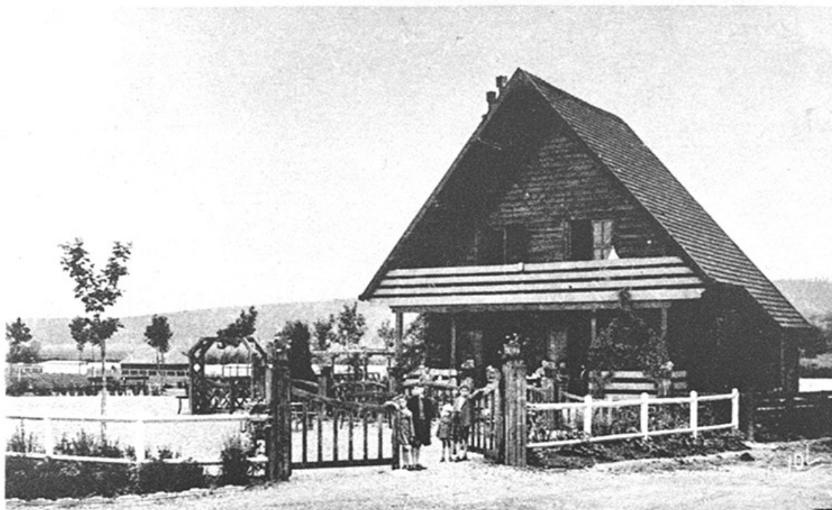
HTQ - PORT-SUR-SAONE — LE CHALET DE LA PLAGÉ
