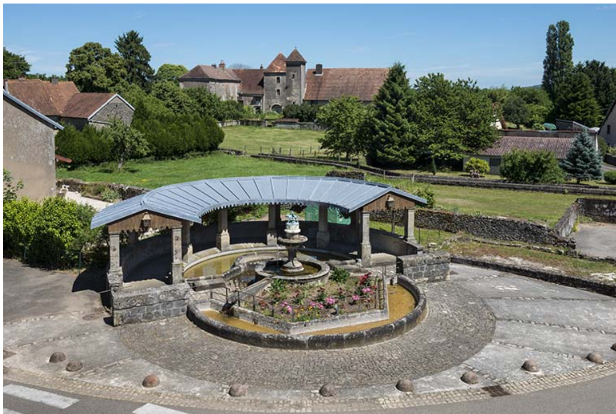
La fontaine sur la place principale du village et la maison fort en arrière plan. 70, Ferrières-lès-Scey
