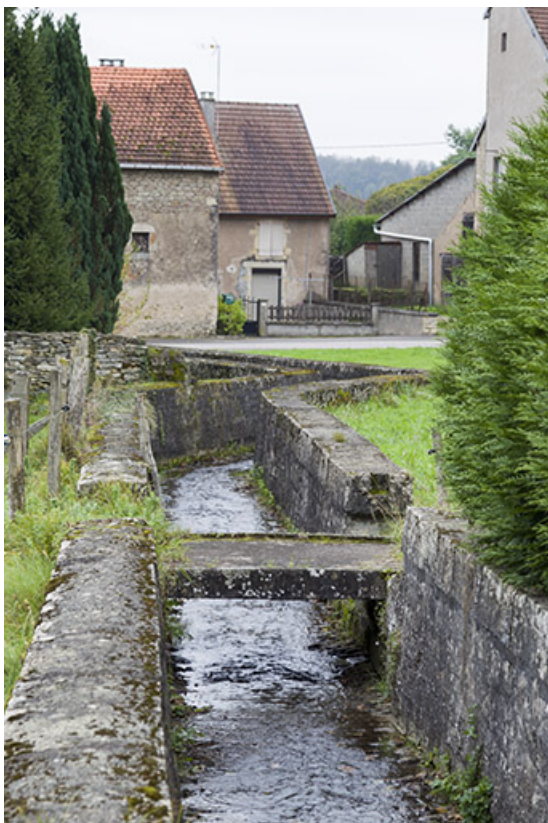
Le ruisseau canalisé traversant le village.
