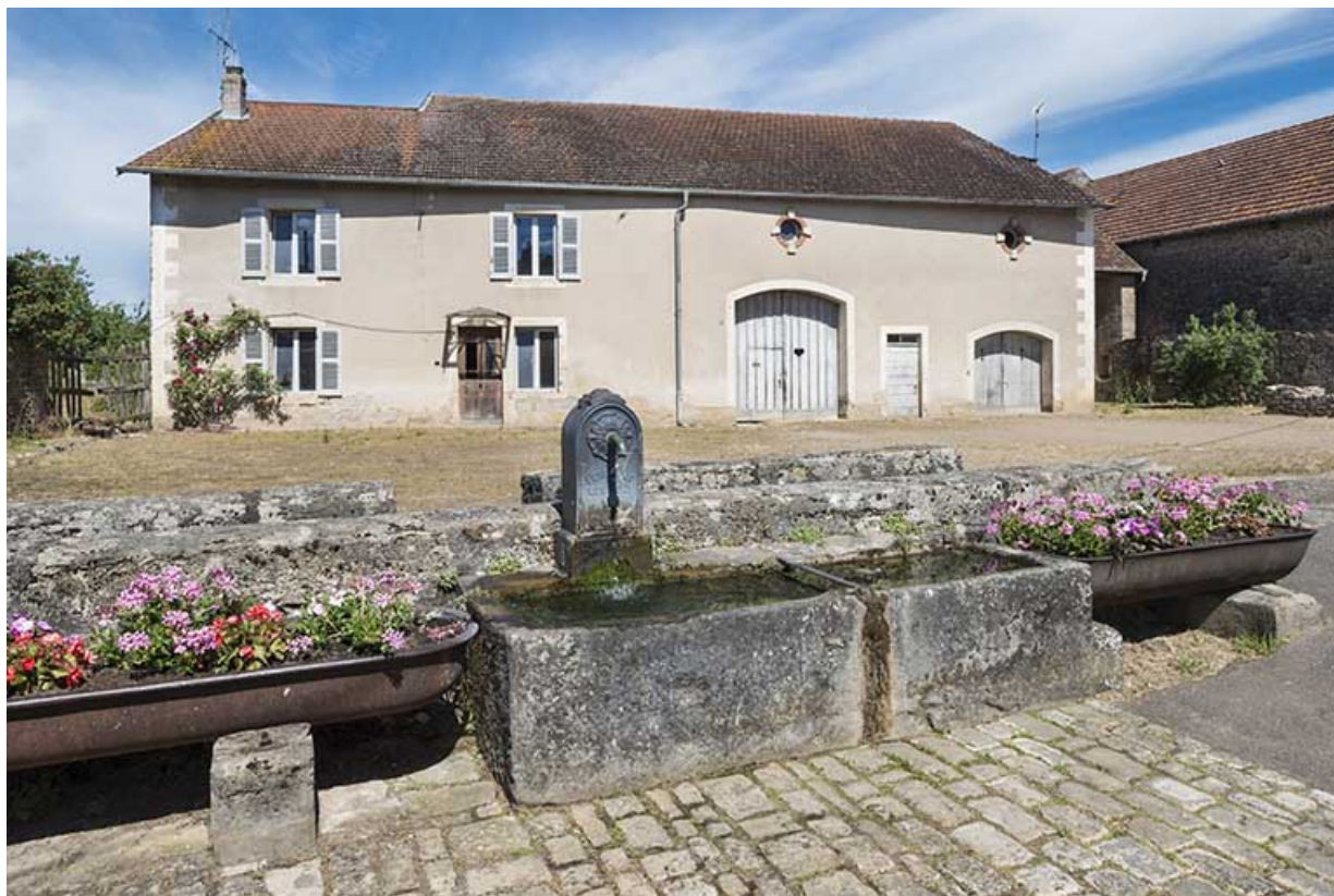
Ferme et borne-fontaine rue de la Prarie. 70, Ferrières-lès-Scey
