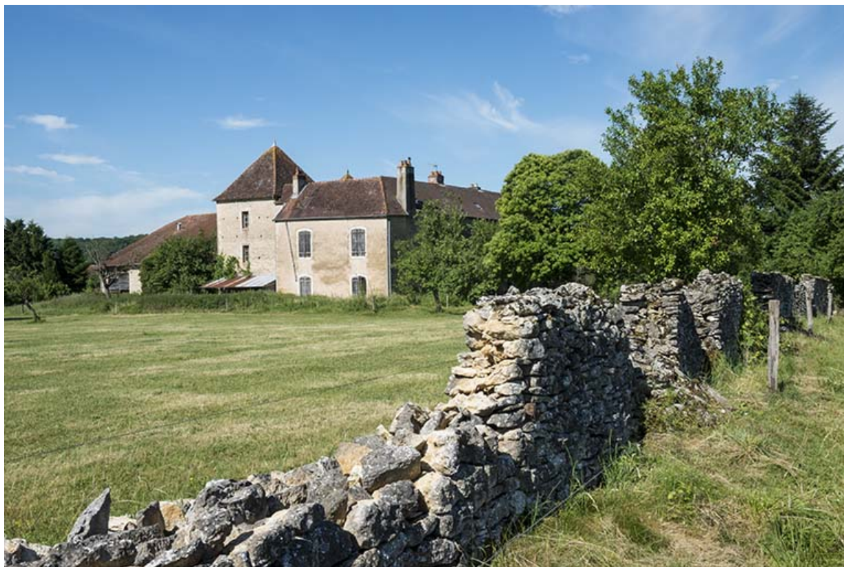
La façade orientale de la maison forte.
