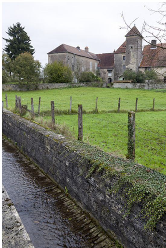
Le ruisseau pavé traversant le village et la maison forte. 70, Ferrières-lès-Scey
