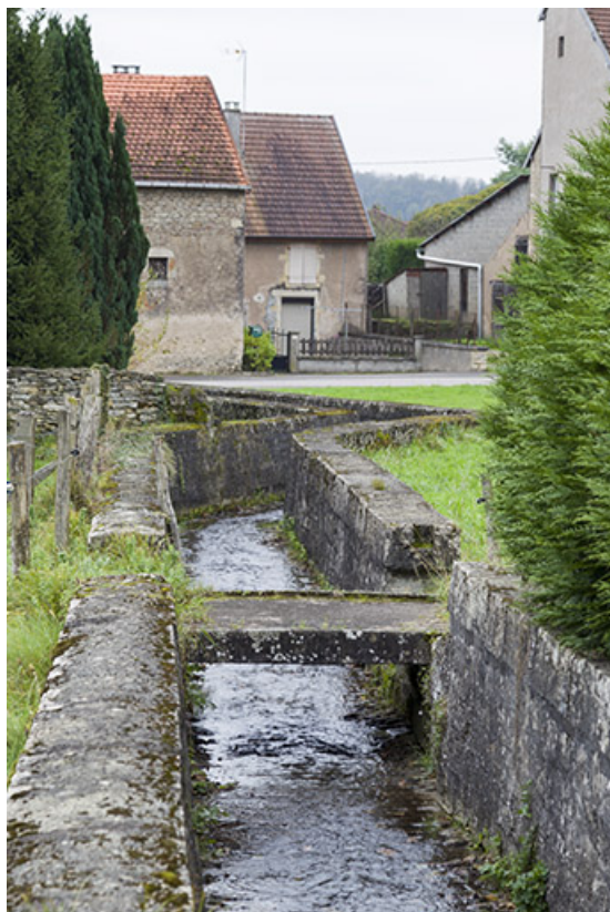
Le ruisseau canalisé traversant le village.
